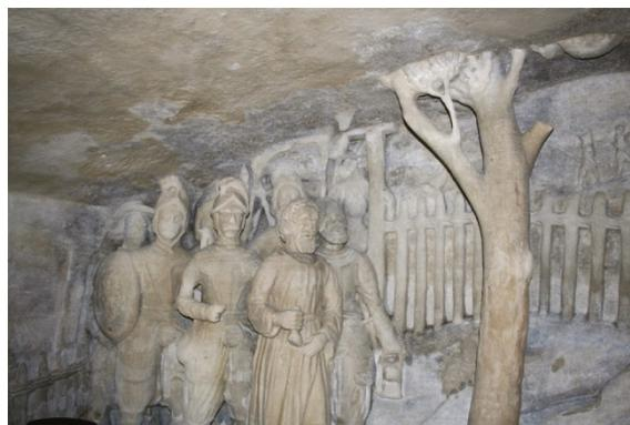
Bild 64: Westliche obere Zone nach Kittung und Schlämmung während der Trocknung
