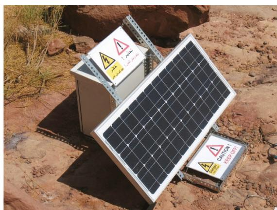
Bild 5: Solarbetriebene Basisstation
