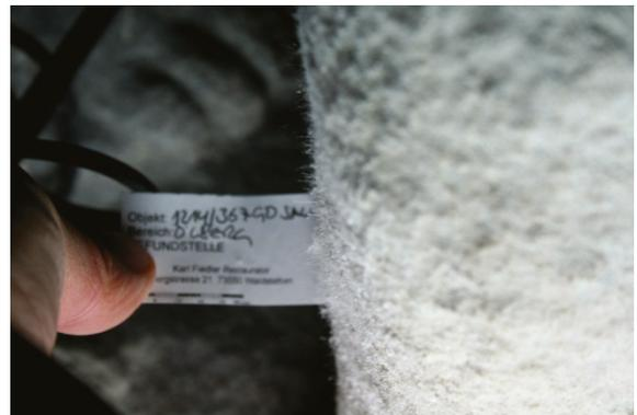
Bild 67: Salzkristallisation während der Entfeuchtung nach Kittung und Schlämmung
