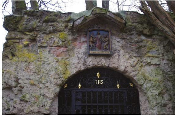
Bild 31: Kerkerkapelle mit Bruchsteinmauerwerk
