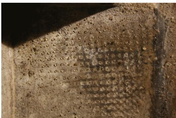
Bild 39: Zementfußboden mit Kondenswassertropfen
