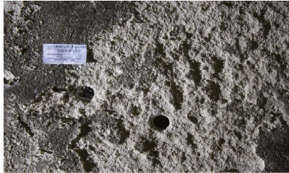
Bild 27: Bereich 05.01 Decke mit Verlust der oberflächennahen Steinzone bis in über 1 cm Tiefe
