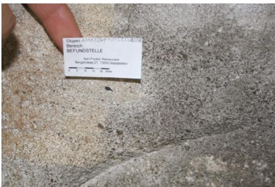
Bild 36: Bereich 04.03 Vergleichsprobe trocken-mechanische Reinigung
