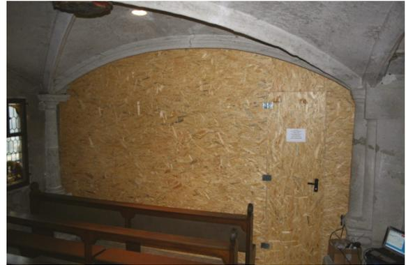
Bild 49: Trennwand für Bearbeitung Ölberg, rechts unten permanente Messung der Ethanol-Konzentration im Ölbergbereich
