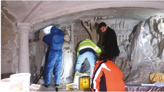
Bild 56: Nach der Festigung Absaugung von Schimmelsporen in den Tiefen / Kontrolle der Festigung durch Ultraschall-Laufzeitmessung
