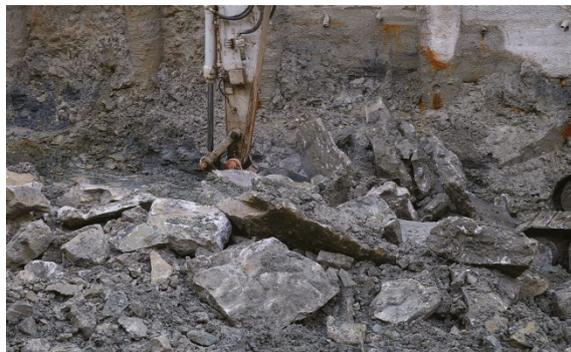
Bild 10: Fleins aus dem Unteren Stubensandstein im Tunnel
