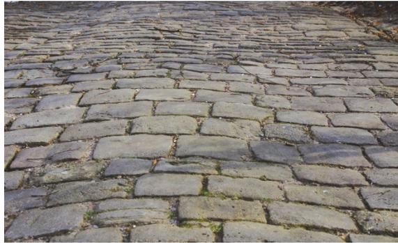
Bild 9: Kalkgebundene Pflastersteine Unt. Stubensandstein
