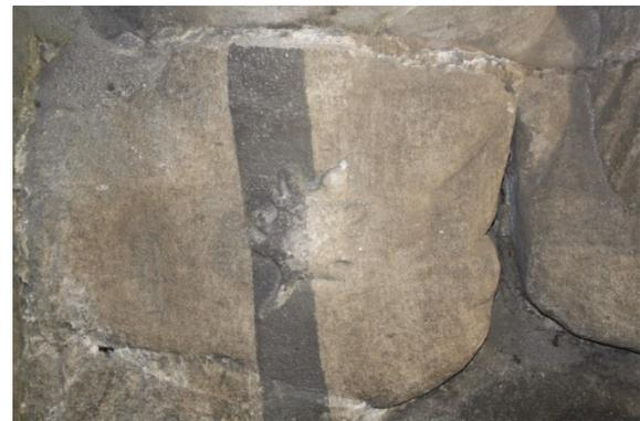
Bild 46: Laser-Reinigung, Detail Zwischenzustand Bereich 03.02
