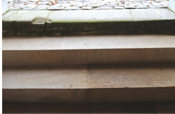
Bild 24: Stufen erneuert durch Leistädter Sandstein
