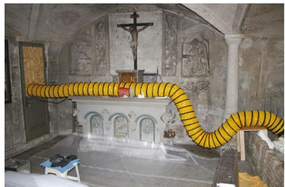
Bild 50: Absauganlage für permanenten Luftaustausch
