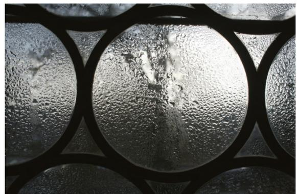
Bild 75: Kondenswasserbildung an den Fenstern
