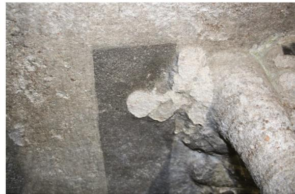
Bild 47: Laser-Reinigung, Detail Zwischenzustand Bereich 05.01 (Decke)
