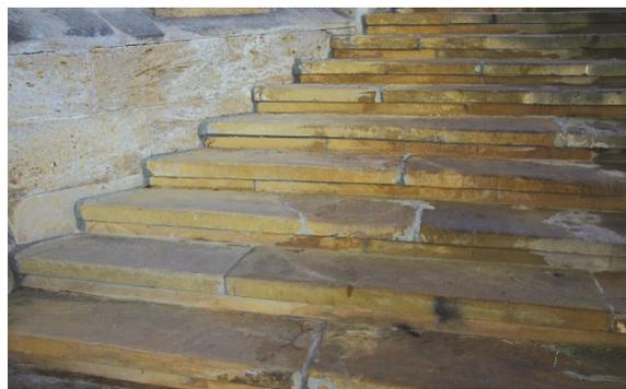
Bild 47: Sandsteintreppe, Schilfsandstein und Muschelkalkfassade
