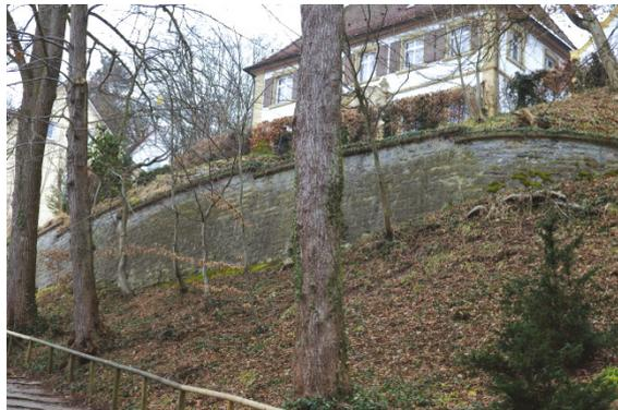
Bild 59: Natursteinmauer aus Arietenkalk unter dem Mesnerhaus
