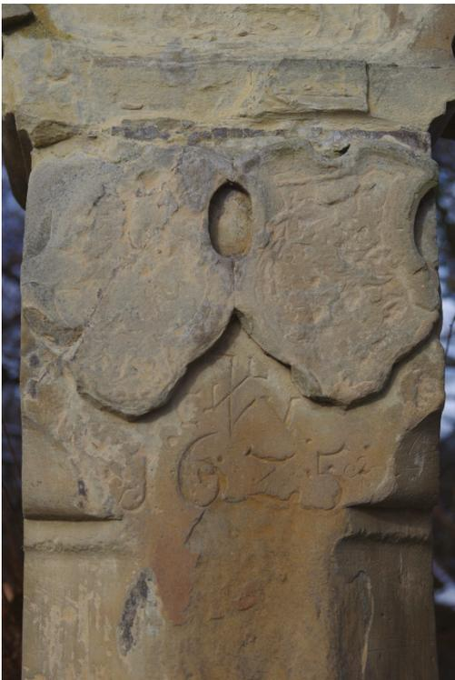
Bild 38: Verwitterter Eisensandstein mit Steinmetzzeichen
