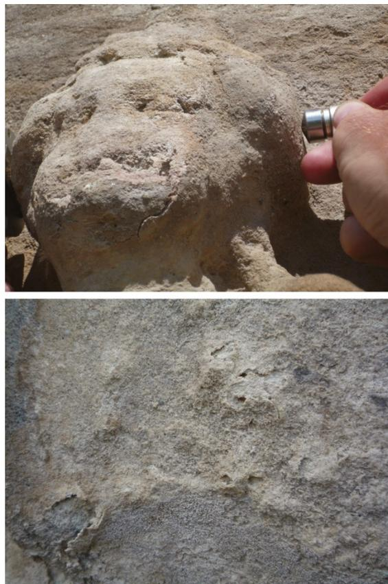
Bild 3: Aktuelle Schäden wie hohl liegende Antragsmörtel (oben) und Salzpustel auf absandenden Flächen (unten)
