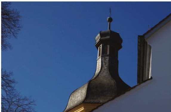
Bild 58: Die devonischen Schieferplatten auf dem Glockenturm
