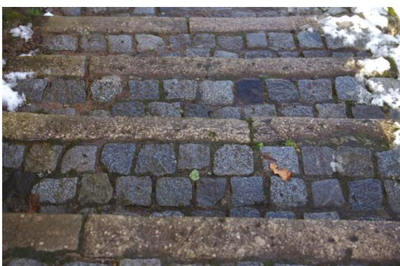
Bild 34: Weg mit Trochitenkalkstufen aus dem Oberen Muschelkalk
