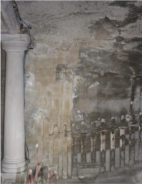
Bild 37: Laser-Reinigung Musterfläche in Bereich 04.03
