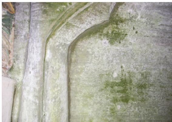
Bild 8: Schichtiger Verlauf des Biofilms, der den Inhomogenitäten des Steins folgte
