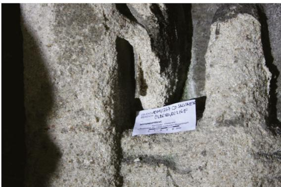
Bild 26: Bereich 06.05/04.01 Ausbrüche mit feinen, fragilen Schalenrändern
