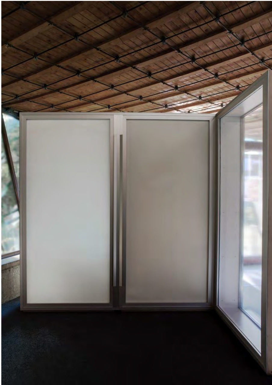
Abbildung 80: Innenansicht von 3 Modulen einer Membranfassaden (transluzent, opak und transparent)
