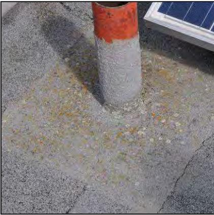
Bild 7.2-25: Ausführungssituation des Abdichtungsanschlusses an Lüfter I
