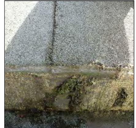
Bild 7.2-39: Übergang Rinnenrand, FLK an die beschieferte Bitumenbahn
