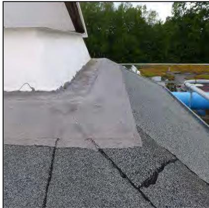
Bild 7.2-47: Typische Ausführungssituation des Übergangs der FLK an die beschieferte Dachbahn
