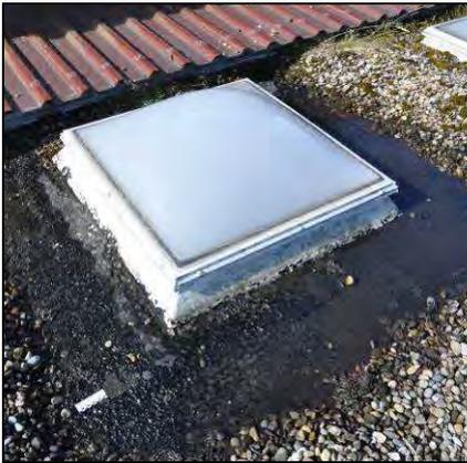
Bild 7.2-16: Zustand vor der Reparatur mit FLK, Gewebeeinlage frei liegend
