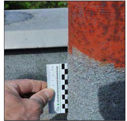
Bild 7.2-27: Obere Abschluss der FLK am Lüfterrohr
