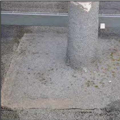
Bild 7.2-28: Ausführungssituation des Abdichtungsanschlusses an Lüfter II, Gewebeeinlage endet ca. 2 cm vor dem Ende der Beschichtung
