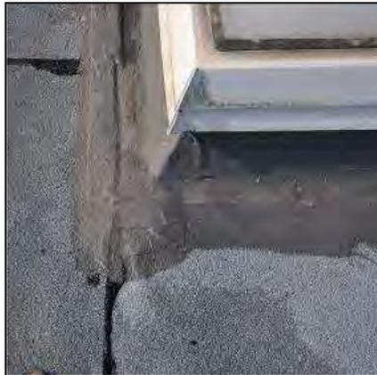
Bild 7.2-20: Übergang FLK an Bahnenabdichtung im Eckbereich
