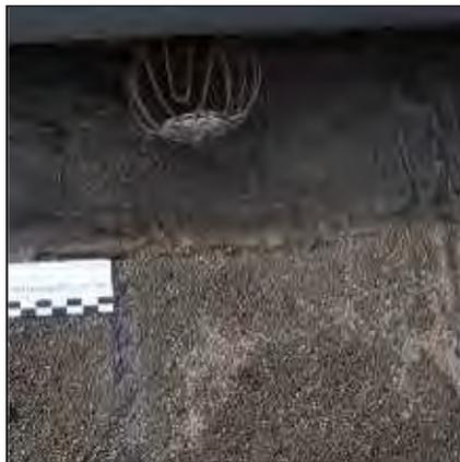
Bild 7.2-65: Zustand des 1. Übergangs zwischen FLK und beschiefelter Bitumenabdichtung
