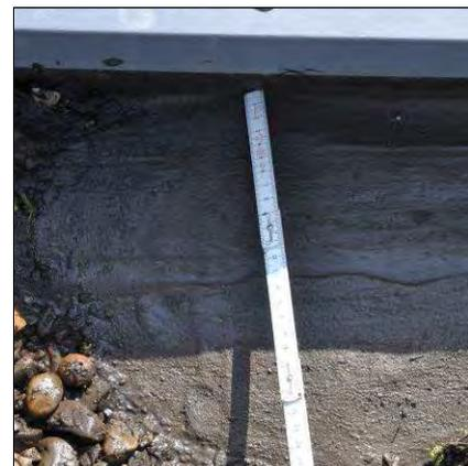
Bild 7.2-69: FLK bindet ca. 150 mm in die Fläche ein
