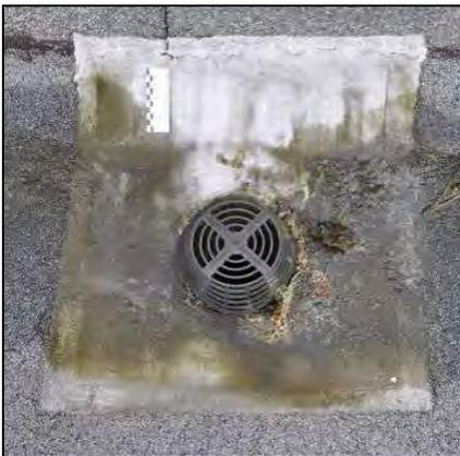
Bild 7.2-10: Typischer Zustand eines Ablaufs im Bereich der Entwässerungsrinne
