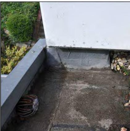
Bild 7.2-64: Anschluss an Wasserspeier und Betonsockel der Terrassentrennwand mit FLK
