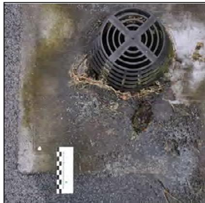
Bild 7.2-11: Verschmutzungen durch stehendes Wasser
