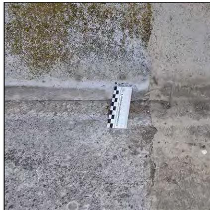
Bild 7.2-53: Ursprünglich aufgebraachte Abdichtungsbahn bindet ca. 30 cm auf die anschließende Fläche ein
