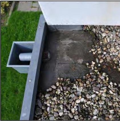
Bild 7.2-61: Aktuelle Anschlusssituation an einen Wasserspeier als Dachflächenentwässerung
