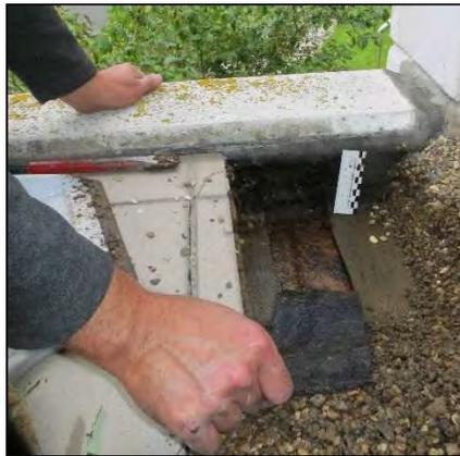
Bild 7.1-17: Übergang der FLK zur Abdichtung in der Fläche im Bereich der Betonaufkantung
