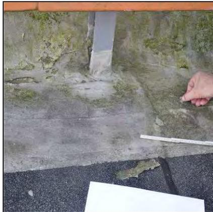
Bild 7.2-56: FLK wird ca. 30 mm über den Rand der Vlieseinlage auf die beschieferte Bitumenbahn fortgeführt
