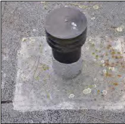
Bild 7.2-7: Typischer Lüfteranschluss
