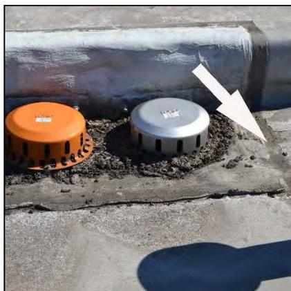
Bild 7.1-2: Kein Ablösen und Aufkräuseln der FLK im nicht von Wasser überstauten Bereich (Pfeil)
