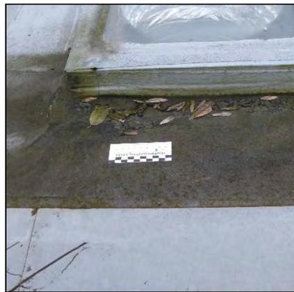
Bild 7.2-74: Starke Verschmutzungen im quer zum Gefälle liegenden Bereich
