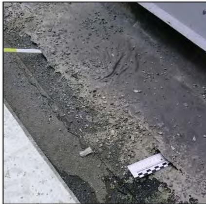
Bild 7.1-8: Ablösungen vom Untergrund an mehreren Stellen
