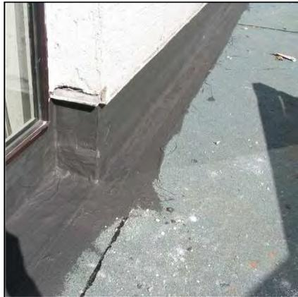
Bild 7.2-71: Ausführung der FLK im Türlaibungsbereich während der Bauphase (Bild: Zengler)
