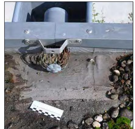
Bild 7.2-66: 2. Übergang zwischen FLK und beschiefelter Bitumenabdichtung
