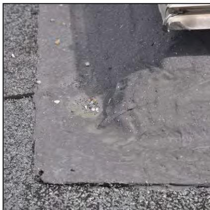
Bild 7.2-32: Übergangsbereich zwischen FLK und Bahnenabdichtung bei Lichtkuppel A
