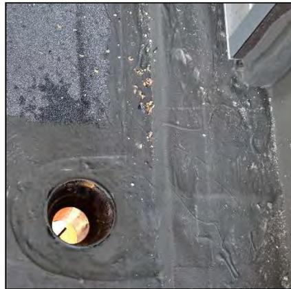
Bild 7.1-5: Anschluss an den Ablauf und den Fassadensockel mit FLK
