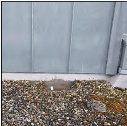
Bild 7.2-22: Dachrandanschluss an den zweigeschossigen Gebäudebereich
