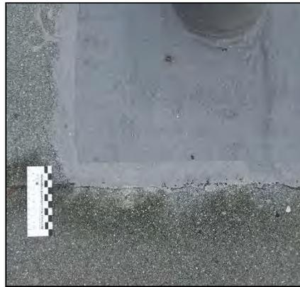
Bild 7.1-11: Anschluss an die Dachentlüfter mit FLK
