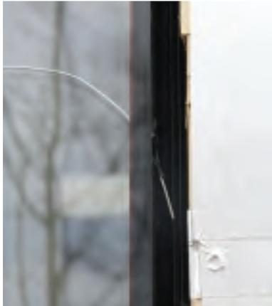
**Abbildung 16** Kapillarende im Glasfalz der Pfosten-Riegel-Fassade
