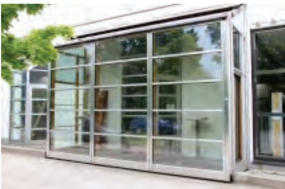
**Abbildung 14** Pfosten-Riegel-Fassade für die Freibewitterung von druckentspannten MIG
