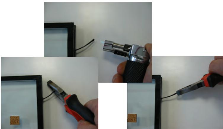
**Abbildung 27** Druckanpassung über Kunststoffschlauch
