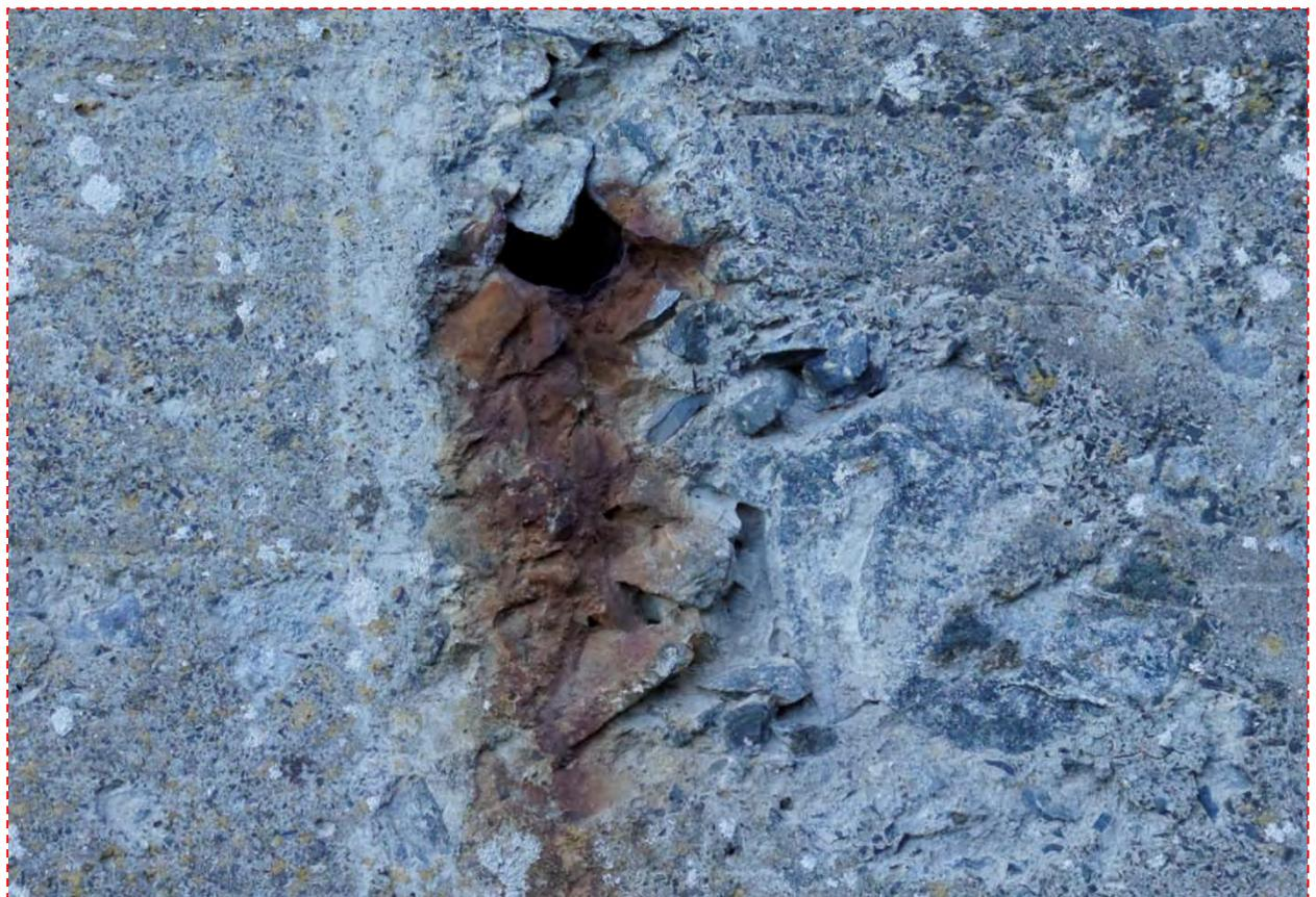
Abbildung 36: Identifizierte Rostfahne an der Oberfläche der Staumauer (Luftseite, Aufnahmeabstand ca. 5m), oben: Originalbild, unten: Bildausschnitt in voller Auflösung (100%)
