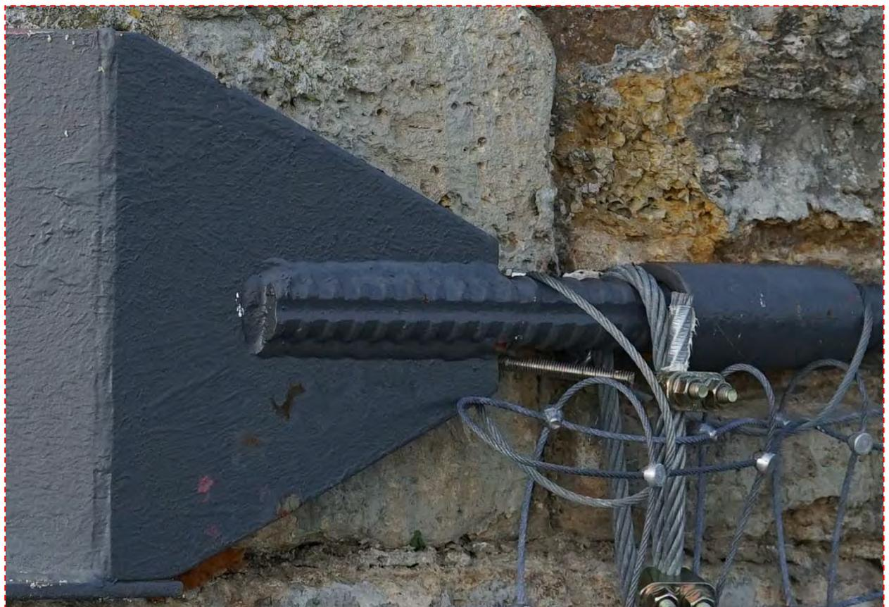
Abbildung 20: Aufnahme eines Stahlzugbandes und des Sicherungsfangnetzes mit Verschraubungen an der südwestlichen Turmecke, oben: Originalaufnahme, unten: Detailausschnitt in voller Bildauflösung (100%)
