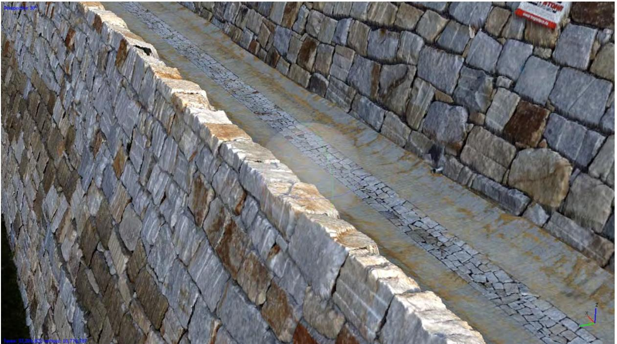
Abbildung 74: Ausschnitt aus dem vermaschten farbcodierten 3D-Modell der Stützwand
