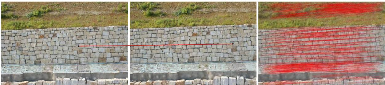
Abbildung 63: Robuste Extraktion und Zuordnung von auffälligen Bildmerkmalen
