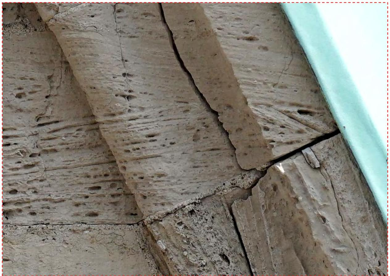
Abbildung 24: Aufnahme der Turmhelme und oberen Fassadenbereiche der Türme, oben: Originalaufnahme, unten: Detailausschnitt mit erkanntem Trennriss im Übergangsbereich von der Fassade zum Dach in voller Bildauflösung (100%)
