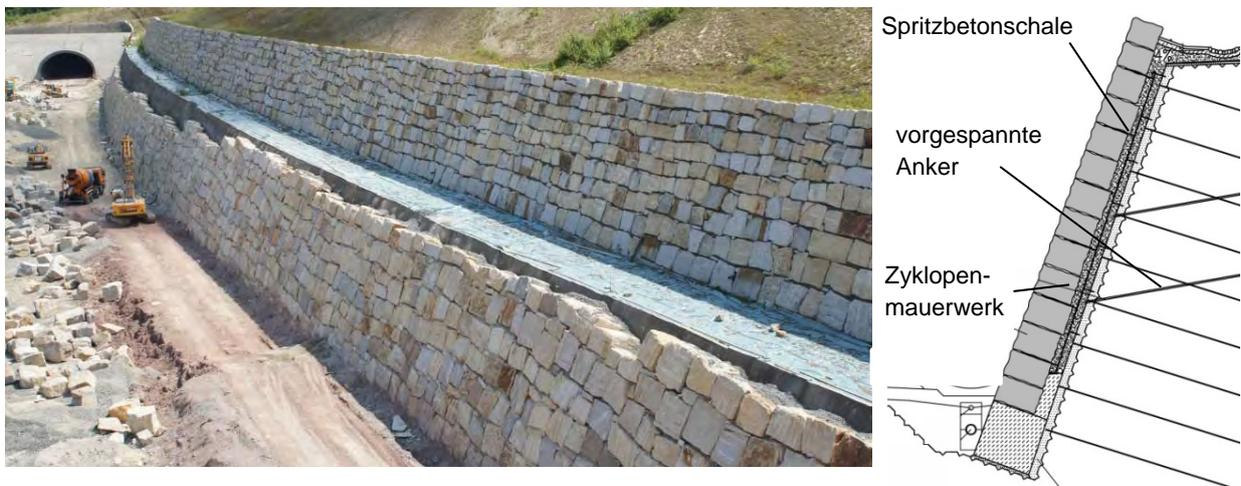
Abbildung 60: Stützwand, links: Rückverankerte Spritzbetonschale mit vorgesetzten Zyklopenmauerwerk, rechts: Querschnitt der unteren Teilwand
