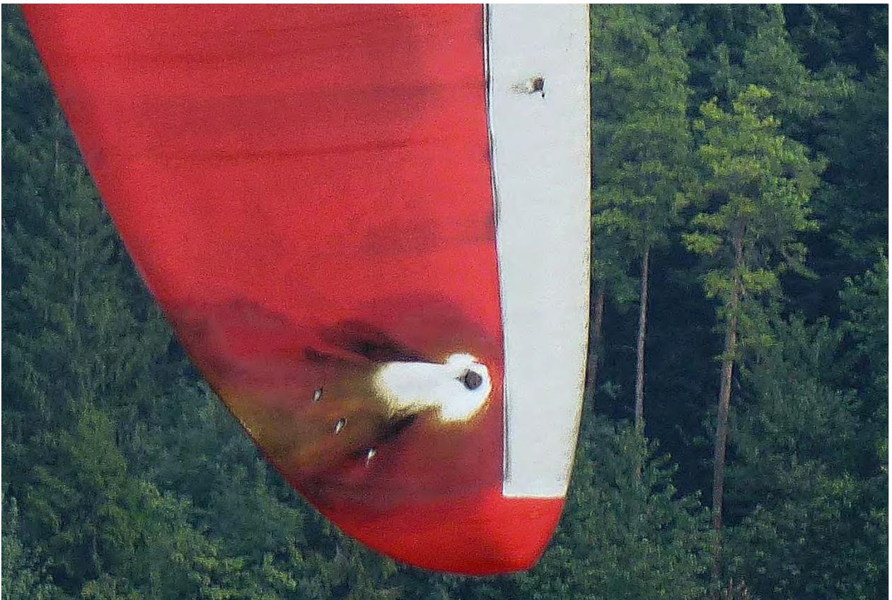
Abbildung 40: Aufnahme der untersuchten Windkraftanlage, oben: Originalaufnahme, unten: Zoomaufnahme einer identifizierten Beschädigung an der Rotorblattspitze
