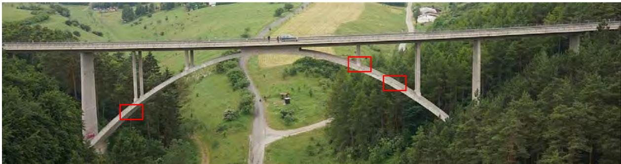
Abbildung 43: Wirrbachtalbrücke Nordwestansicht, rot markiert: identifizierte Schadstellen
