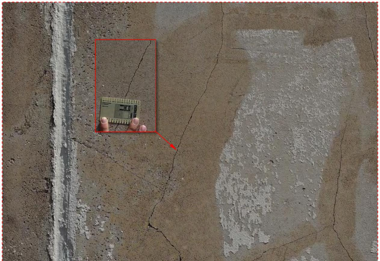
Abbildung 16: Luftbildaufnahme eines Risses (Rissbreite: 0,5mm) an der Betonoberfläche der Westfassade des Referenzbauwerks, oben: Originalaufnahmen im Abstand von ca. 7,5m, unten: Detailausschnitt in voller Bildauflösung (100%), Kamera: Sony Alpha 7R
