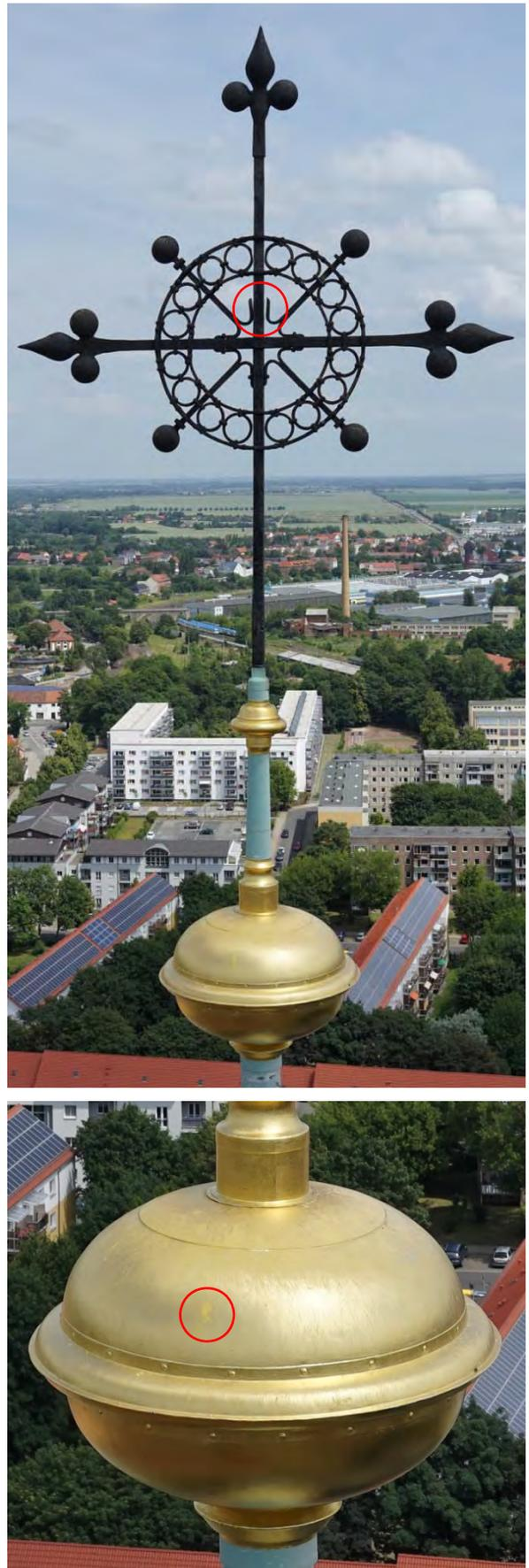
Abbildung 22: Aufnahme der Turmhelme des Doms zu Halberstadt, links: Westansicht des Doms, rechts: Turmspitze des Nordturms mit erkanntem Schaden (fehlerhafte Nietverbindung) am Kreuz und Ablösungen an der vergoldeten Kugeloberfläche
