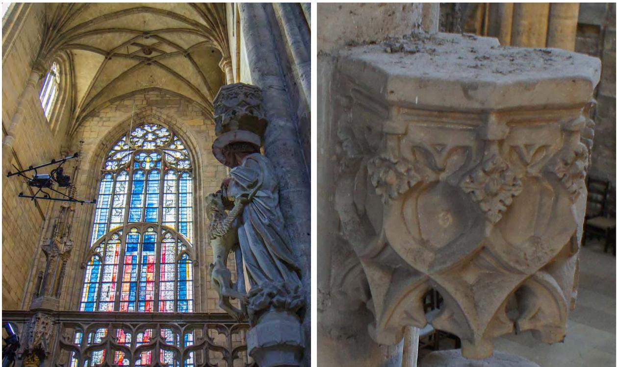
Abbildung 27: Innenraumaufnahmen im Dom zu Halberstadt, links: Aufnahme einer Figur aus kürzester Distanz zur Ermittlung des Verschmutzungsgrades [Foto: Späth, AscTec], rechts: Konsolenelement oberhalb der Figur mit starker Verschmutzung
