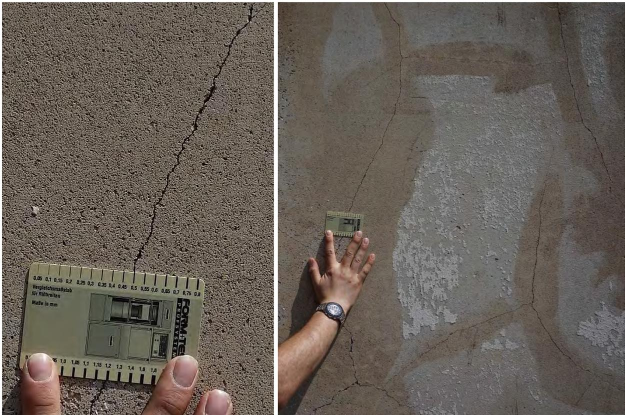
Abbildung 15: Manuelle Rissbreitenmessung an der Westfassade des Bürogebäudes
