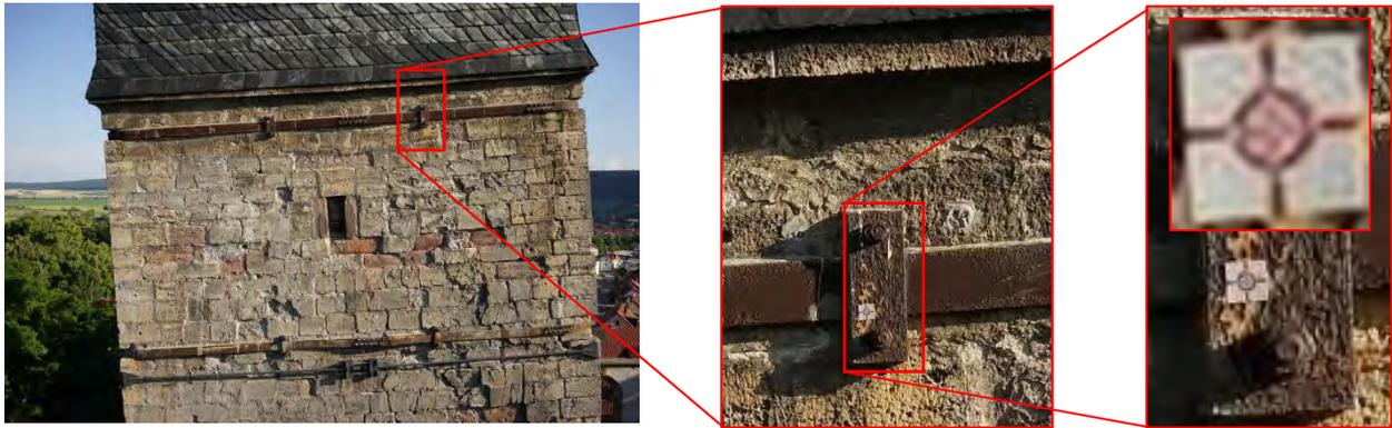
Abbildung 52: Verwendeter Passpunkt am Bauwerk, links: Originalaufnahme, Mitte: Bildausschnitt 100% Auflösung, rechts: max. Zoombereich
