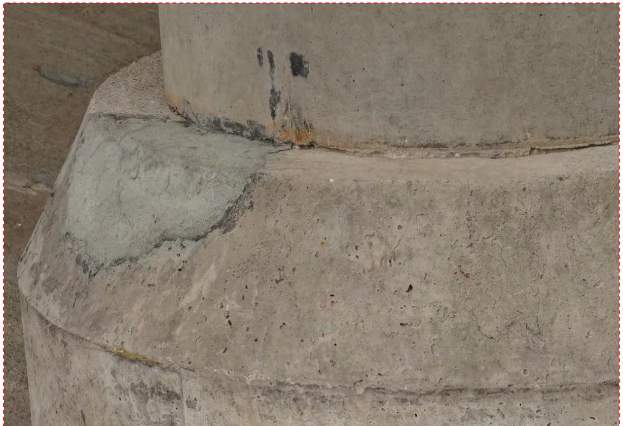
Abbildung 45: Aufnahme einer instandgesetzten Abplatzung an einem Pfeilerfuß, oben: Originalaufnahme, unten: Detailausschnitt in voller Bildauflösung (100%)
