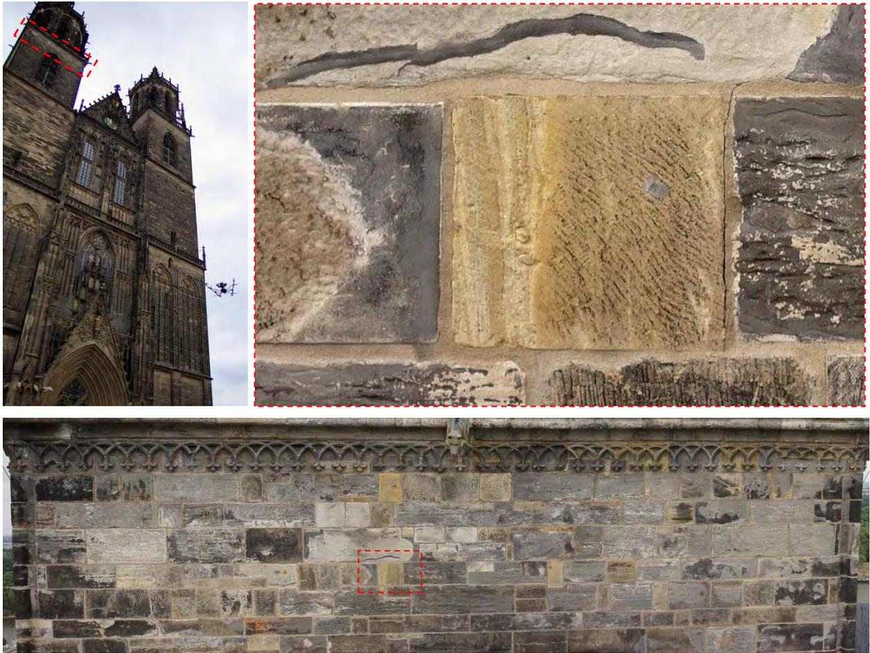
Abbildung 31: Aufnahme eines Fassadenbereichs an der Westseite des Nordturms in ca. 80m Höhe, oben rechts: Detailausschnitt aus dem generierten Orthophoto in voller Auflösung (100%), unten: Gesamtaufnahme des untersuchten Fassadenbereichs
