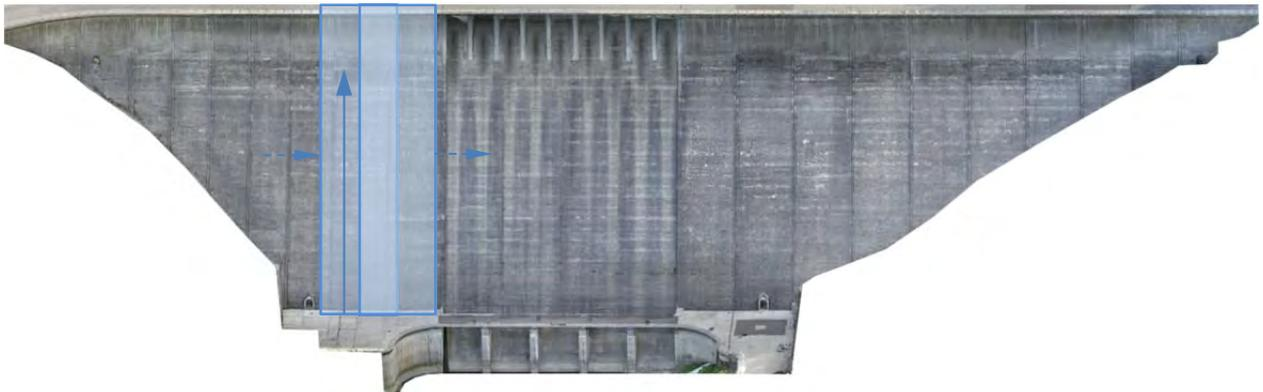
Abbildung 35: Hochaufgelöste Orthophoto-Nordost-Ansicht der Rappbodetalsperre mit zwei vertikal sich überlappenden Aufnahmestreifen/-sektoren
