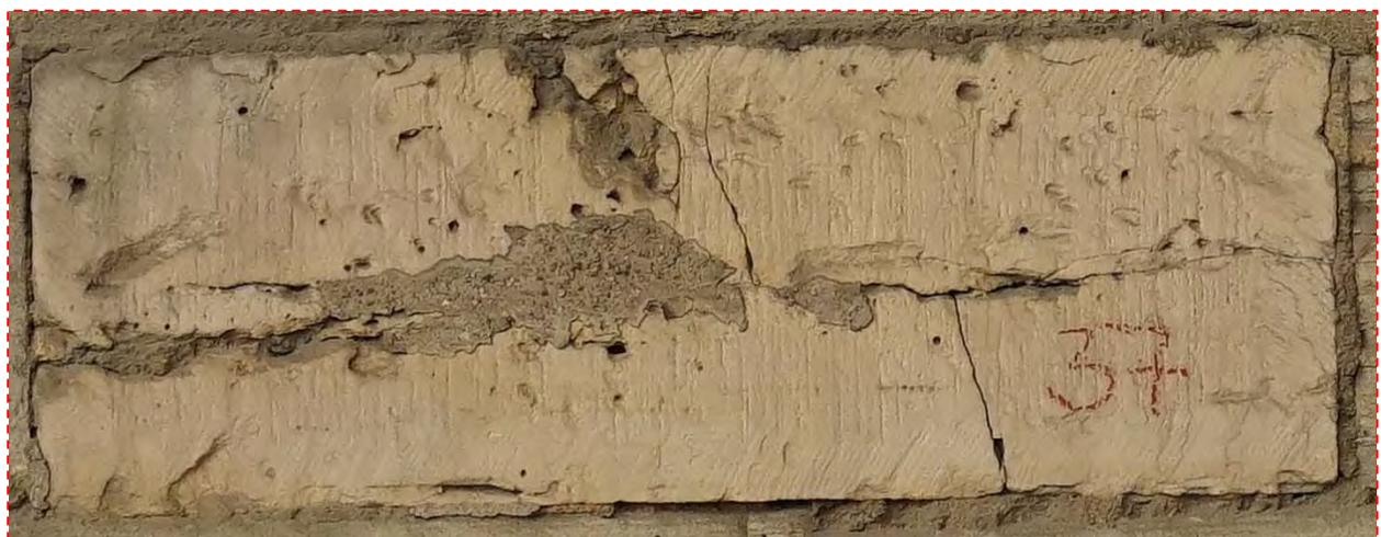
Abbildung 32: Aufnahme der nördlichen Außenwände des Ostchores, oben: Originalaufnahme, unten: Detailausschnitt einer geschädigten Steinoberfläche in voller Auflösung (100%)
