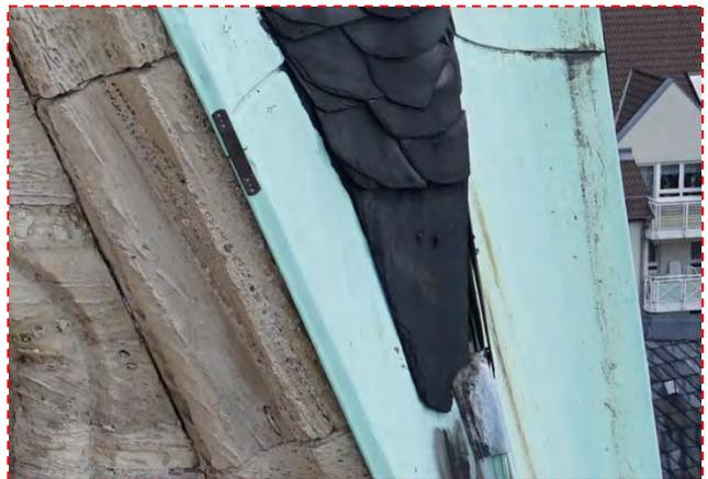
Abbildung 23: Aufnahme der Turmhelme des Doms zu Halberstadt, links: Orthophoto der Westansicht des Nordturms, rechts: Detailausschnitte aus dem Orthophoto mit erkannten Schäden an der Dacheindeckung in voller Bildauflösung (100%)
