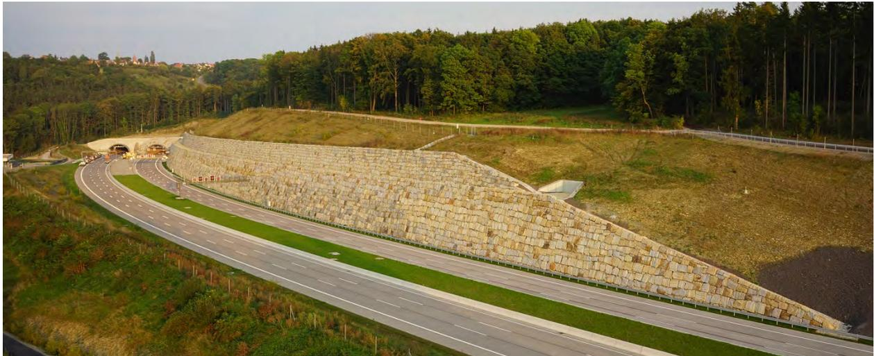
Abbildung 59: Referenzbauwerk Stützwand entlang der BAB 4 bei Bucha (Jena), Westportal Jagdberg-Tunnel, Thüringen
