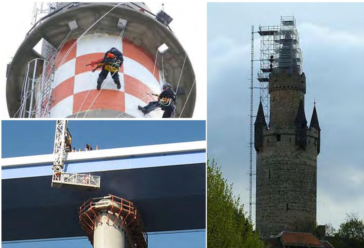
Abbildung 1: Beispiele für die Inspektionen schwer zugänglicher Bauwerke, links oben: Industriekletterer am Schornstein [1], links unten: Brückenuntersichtgerät [2], rechts: Spezialgerüst am historischen Burgfried [3]
