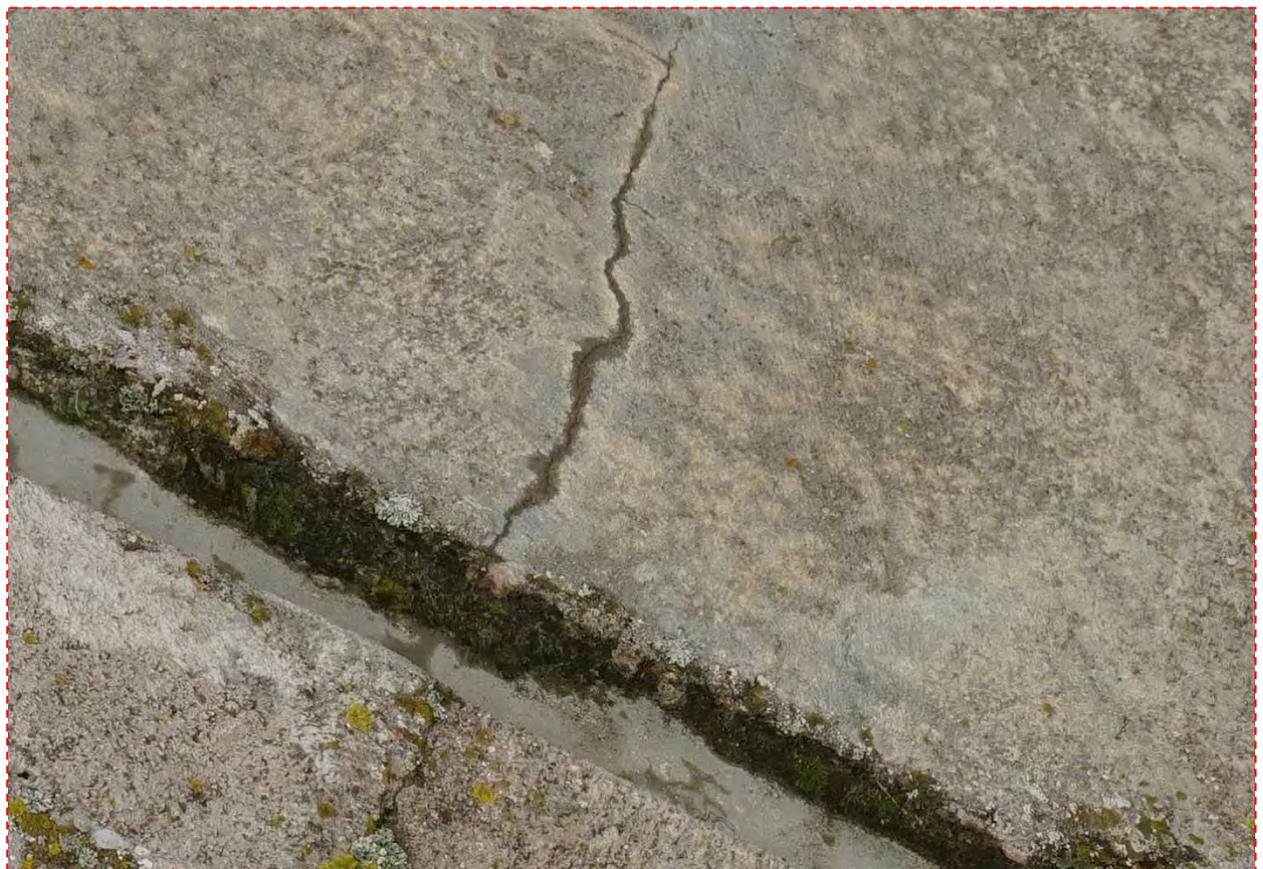
Abbildung 44: Aufnahme eines Risses am Bogen, oben: Originalaufnahme, unten: Detailausschnitt in voller Bildauflösung (100%)
