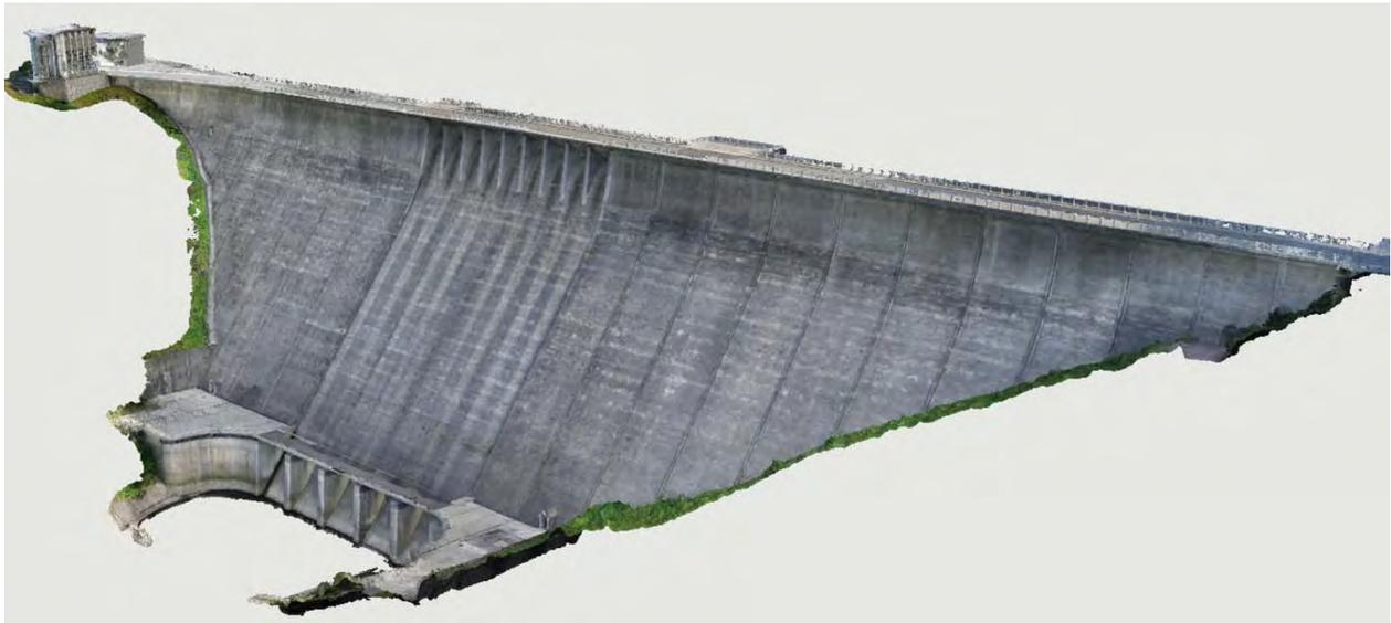
Abbildung 34: 3D-Modell der Rappbodetalsperre, Ansicht Nordwest (Luftseite), Kronenlänge ca. 415m, Höhe ca. 90m
