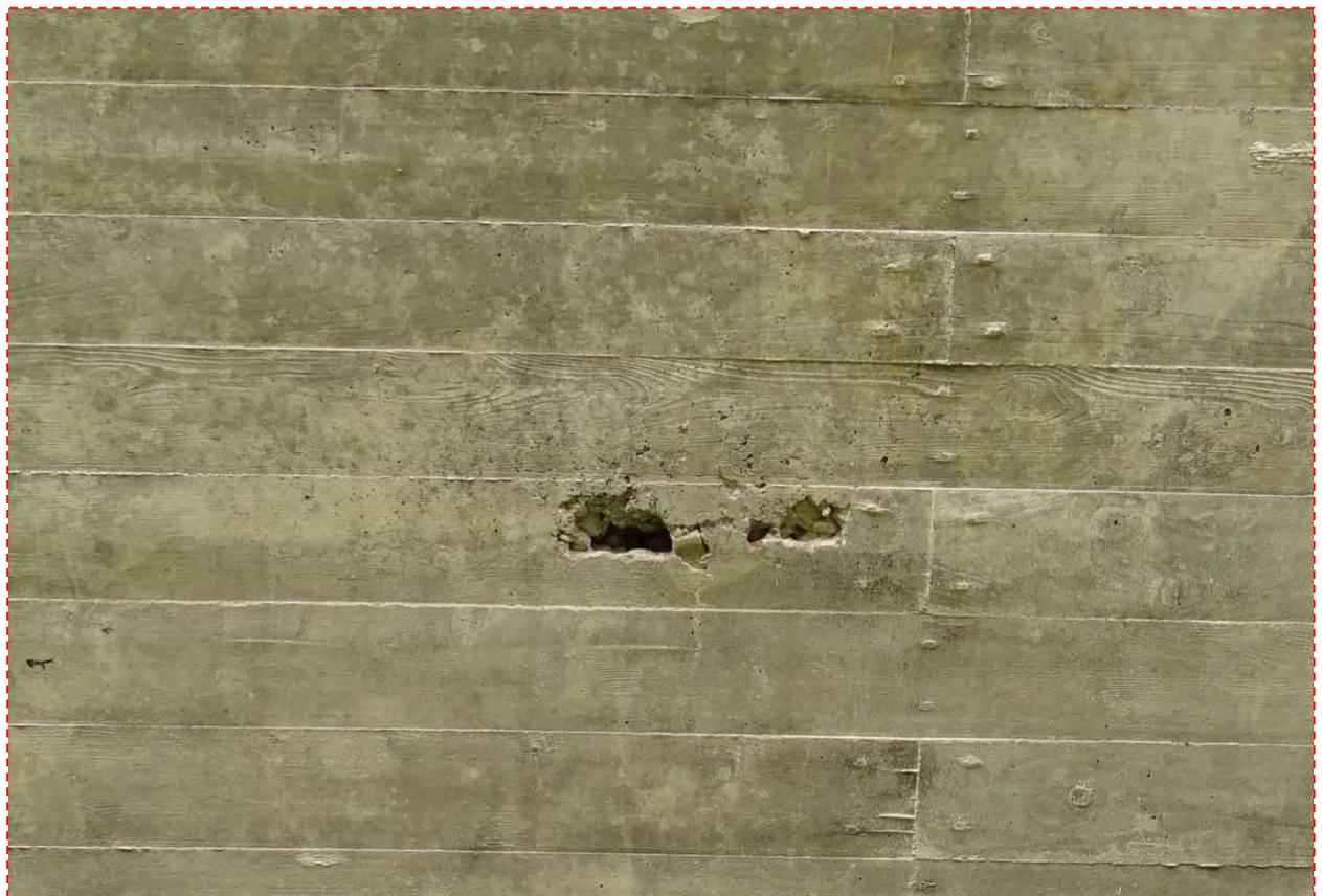
Abbildung 46: Aufnahme eines Kiesnestes an der Bogenuntersicht, oben: Originalaufnahme, unten: Detailausschnitt in voller Bildauflösung (100%)
