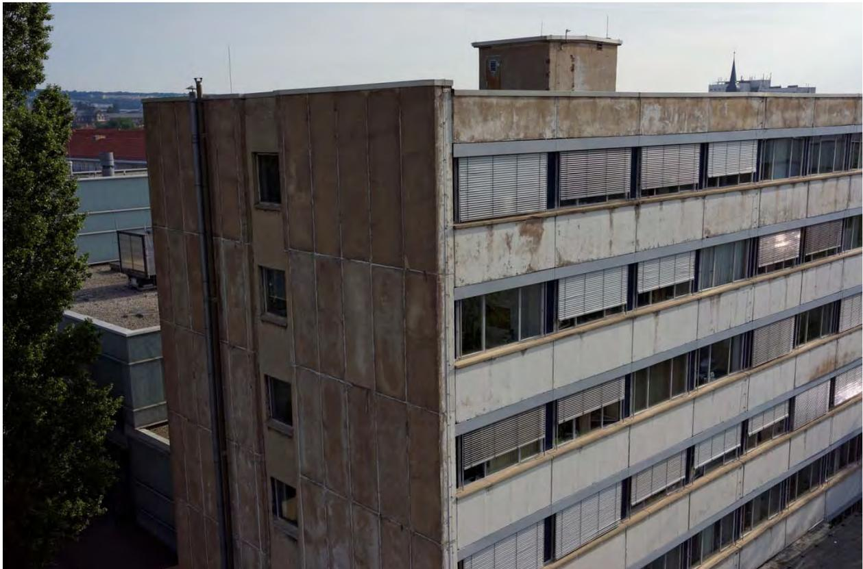
Abbildung 14: Südwestansicht Referenzbauwerk Bürogebäude mit stark geschädigter Westfassade
