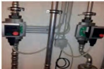
Einbausituation einer Zirkulationspumpe
