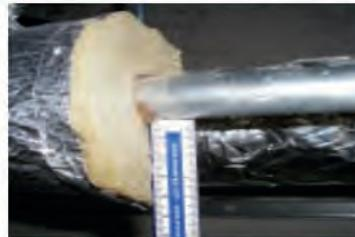
Messung der Dämmstärke im teilweise gedämmten Zustand (mit ablesbaren Werten)
