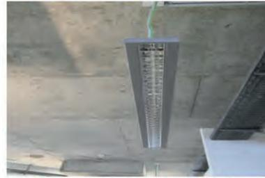
Leuchtstofflampe, stabförmig (Detail)
