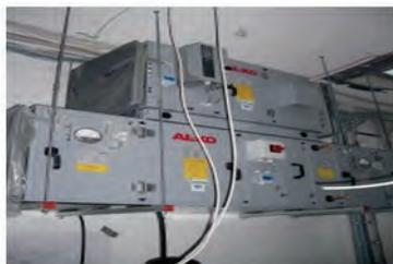
Einbausituation einer Zu- und Abluftanlage
