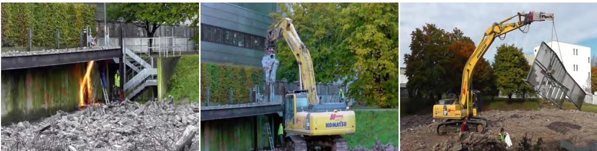
Abbildung 53: Trennen (l.), Herausheben (m.) und Umsetzen der Treppenhausbauteile (r.)
