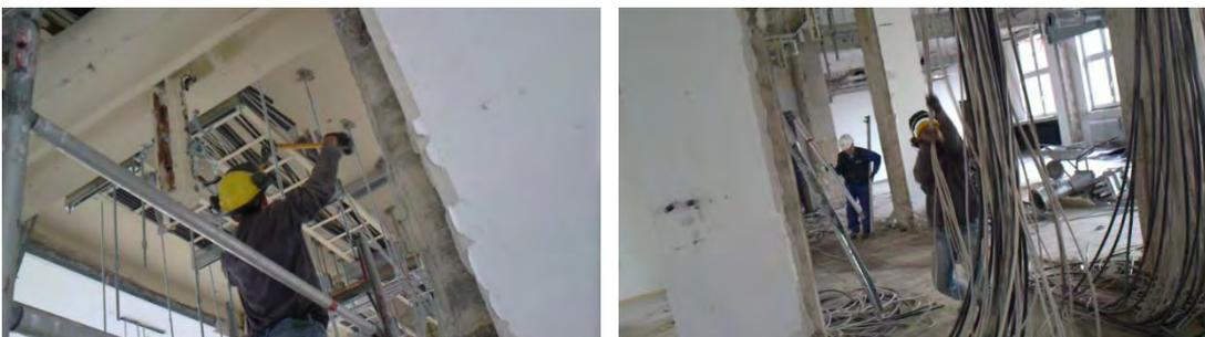
Abbildung 69: Demontage von Rohrleitungen und Kabeln
