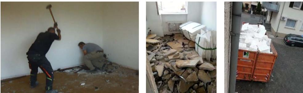
Abbildung 92: Estrich brechen; Zwischenlagern gebündeltes Styropor, zu entsorgendes Styropor (v. l.)
