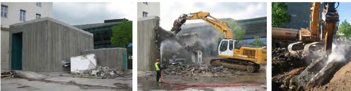
Abbildung 83: Abbruch des Versuchsstandes und der Gründungskörper
