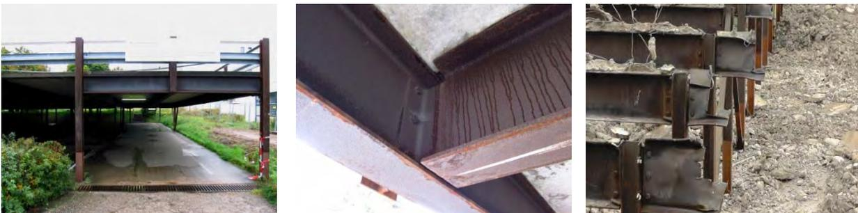
Abbildung 44: Traversenfeld, Anschluss Unterzug-Traverse, Anschluss Unterzug- Mittelstütze (v.l.n.r.)
