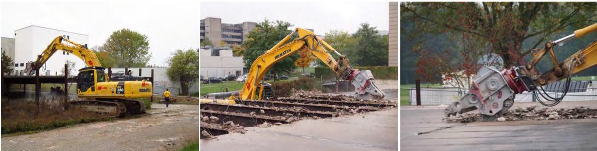
Abbildung 51: Pressschneiden der Decke
