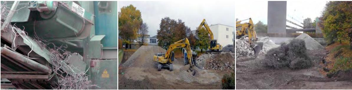
Abbildung 57: Magnetabscheider, Umsetzen des Durchsatzes und Lagerung der Stahlabfälle (v.l.n.r.)
