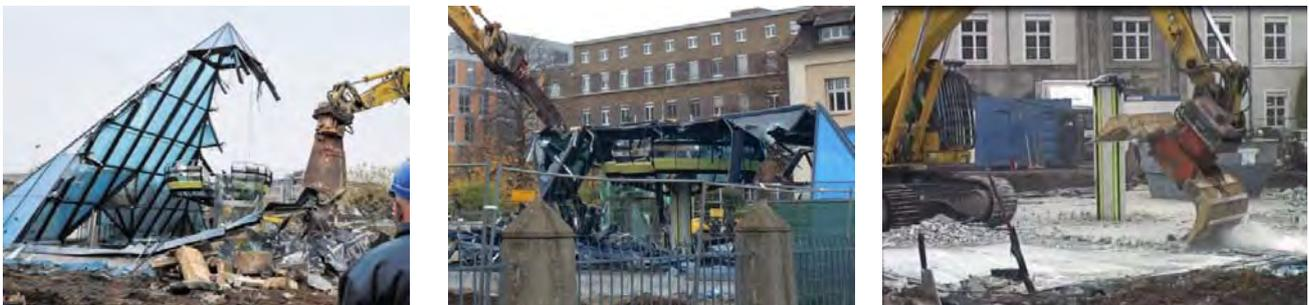
Abbildung 101: Rückbau des oberirdischen Tragwerks<sup>100</sup>
