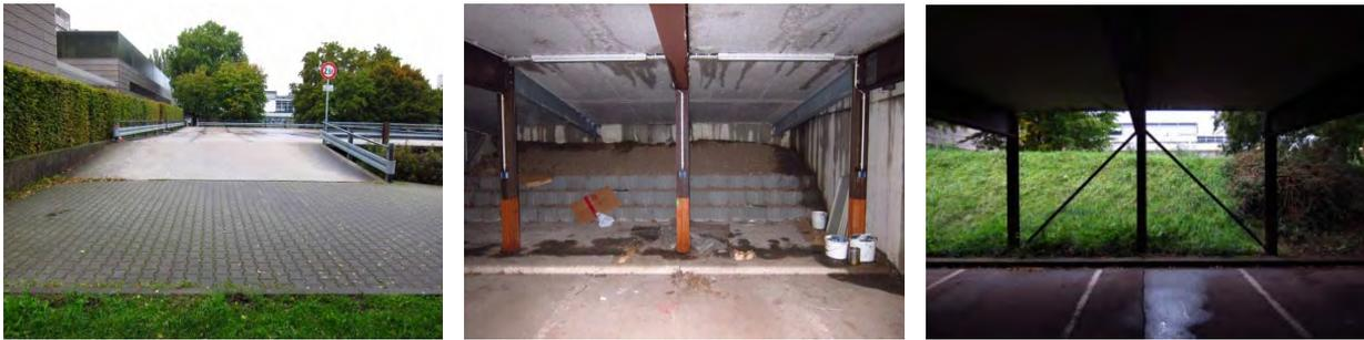
Abbildung 45: Stahlbetonrampe (l.) mit Tragwerk (m.), Windsteifen (r.)
