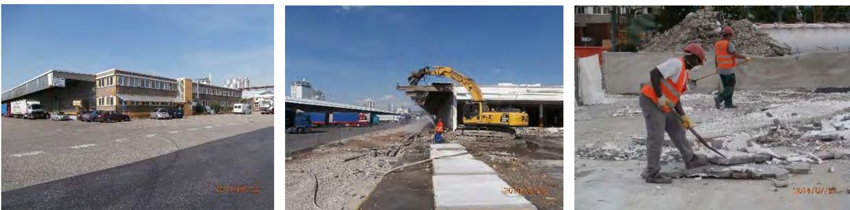
Abbildung 38: Kopfbau Nordost mit Blickrichtung Südwesten, Abbruch der Spannbetonbinder mit Blickrichtung Nordosten, Trennung von Styropor- und Stahlbetonabfällen (v.l.n.r.)
