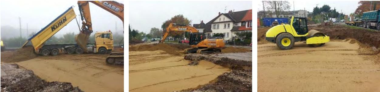
Abbildung 97: Abladen Sand (l.); Sand in Schichten verteilen (m.); Sand verdichten (r.)
