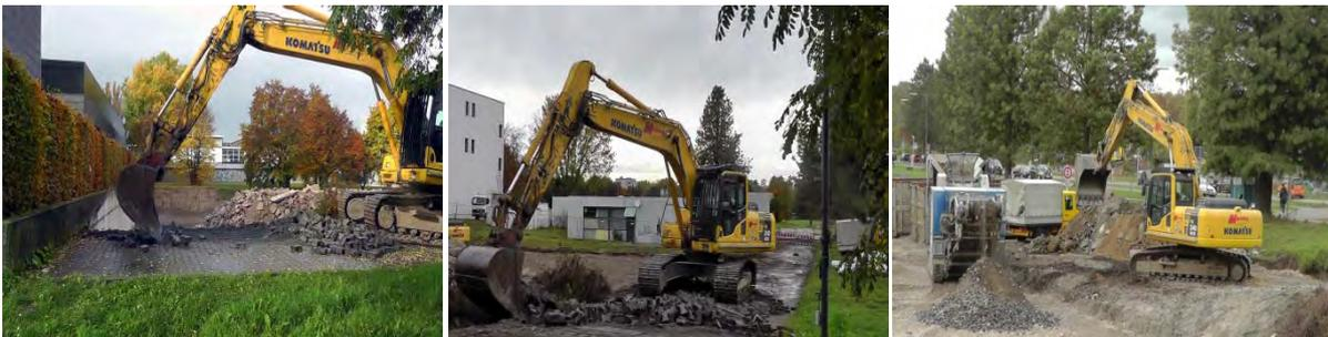
Abbildung 58: Reißen des Pflasterbelags (l. und m.) und Aufbereitung des Abfälle (r.)
