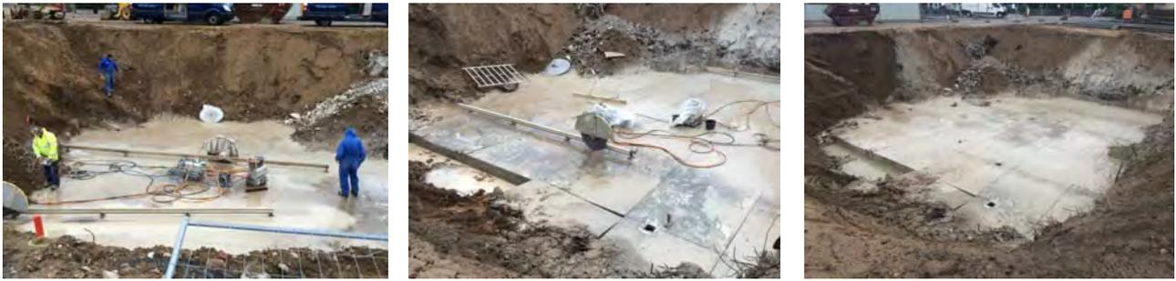
Abbildung 104: Rückbau der Bodenplatte
