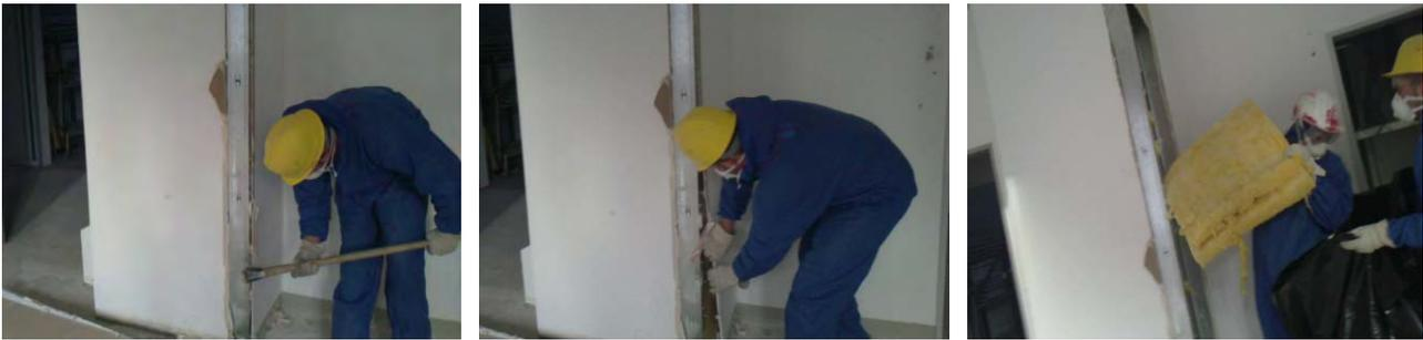
Abbildung 70: Rückbau der Gipskartonwände
