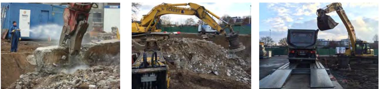
Abbildung 103: Bauschutt aufbereiten und verladen
