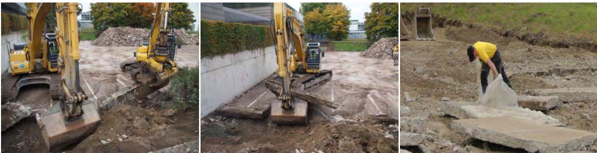
Abbildung 55: Reißen der Fundamente (l.) und Bodenplatte (m.); Lösen der Sauberkeitsschicht (r.)
