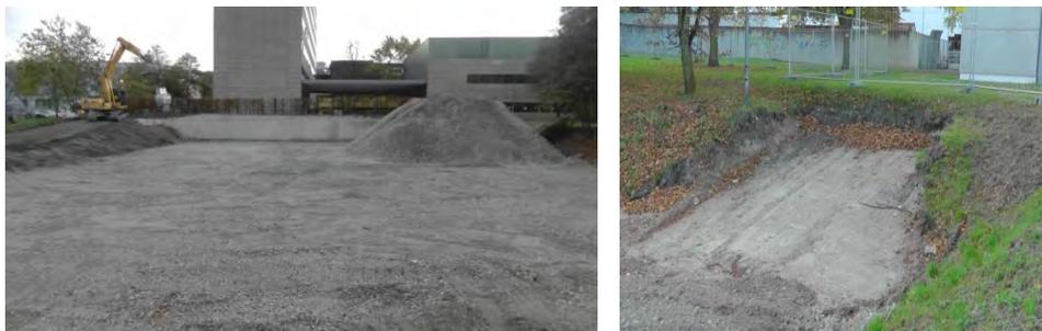
Abbildung 59: Endzustand Baufeld (l.) und Verfüllung Treppenhäuser Nordwest (r.)
