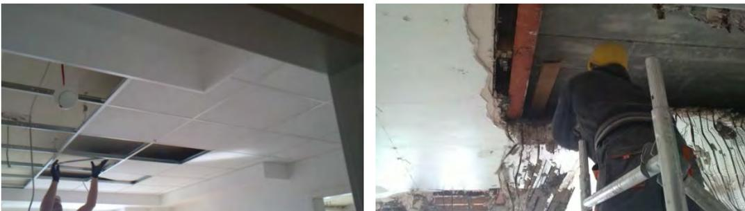
Abbildung 68: Demontage der Decken
