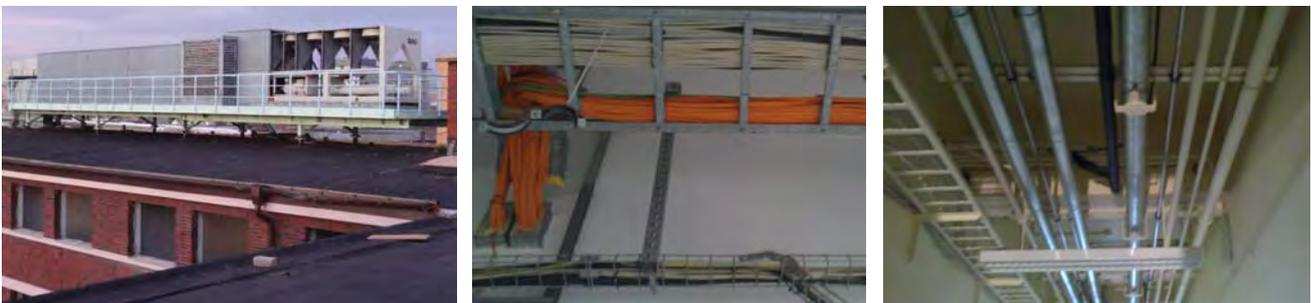
Abbildung 63: Lüftungsanlage, Medienversorgung
