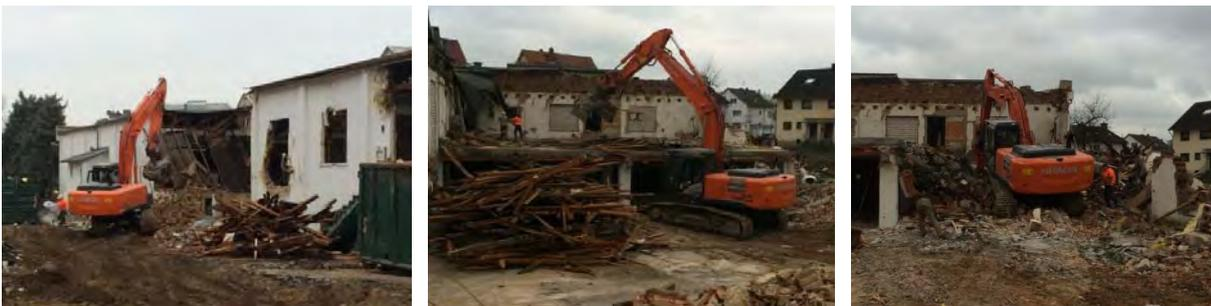
Abbildung 114: Gebäudeteil 1 - Rückbau oberirdisches Tragwerk
