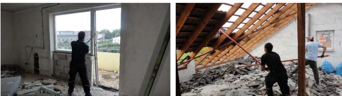
Abbildung 93: Ausbau der Fenster und Abdecken der Dacheindeckung
