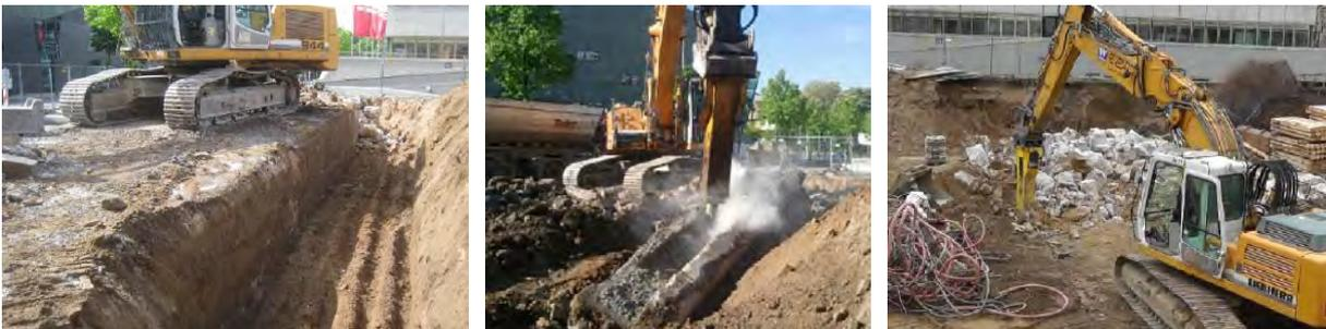
Abbildung 85: Stemmen des Blockfundament und der Bodenplatte
