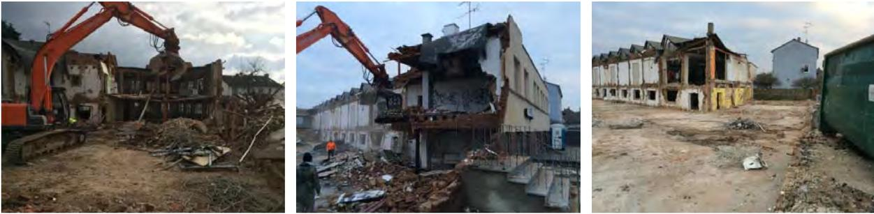
Abbildung 115: Gebäudeteil 2 und 3 - Rückbau oberirdisches Tragwerk
