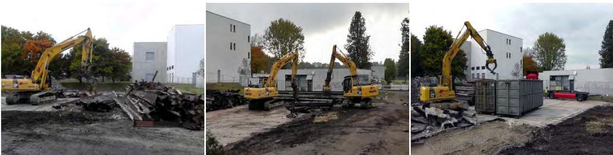
Abbildung 54: Lagerung, Bearbeitung und Verladen der Stahlabfälle (v.l.n.r.)
