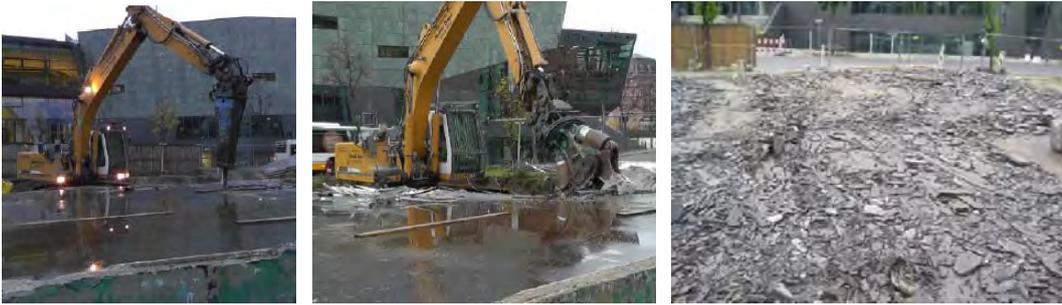
Abbildung 84: Stemmen und Pressschneiden der Decken
