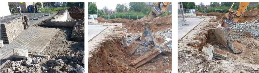
Abbildung 96: Ausgebautes Pflaster (l.); Einziehen mit Haken (m.); Einziehen mit Tieflöffel (r.)
