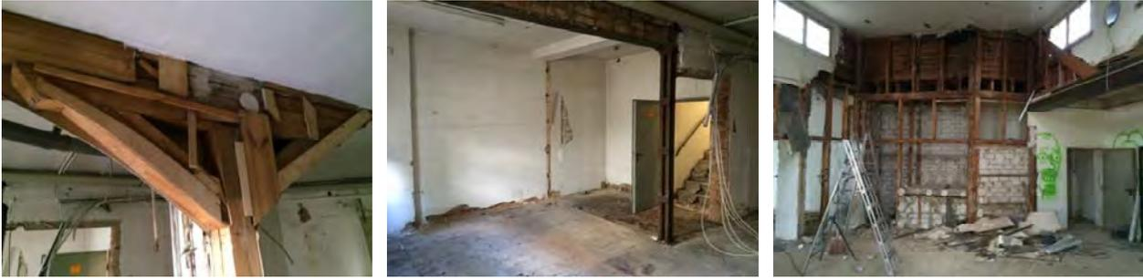
Abbildung 109: Unterstützungsstruktur Decken
