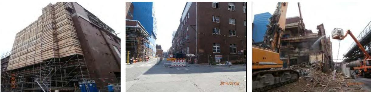
Abbildung 40: Schutzgerüst Westfassade, halbseitige Sperrung Ostseite Blickrichtung Süden, Abbruch des Tragwerks Blickrichtung Südosten (v.l.n.r.)
