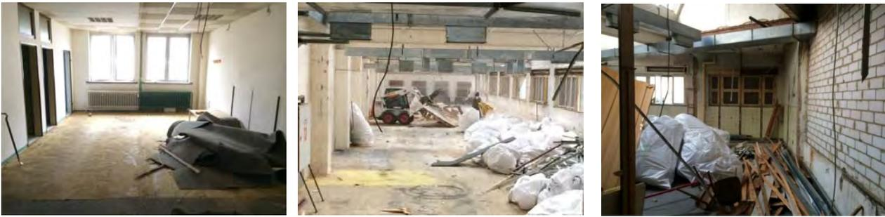
Abbildung 113: Entkernungsarbeiten
