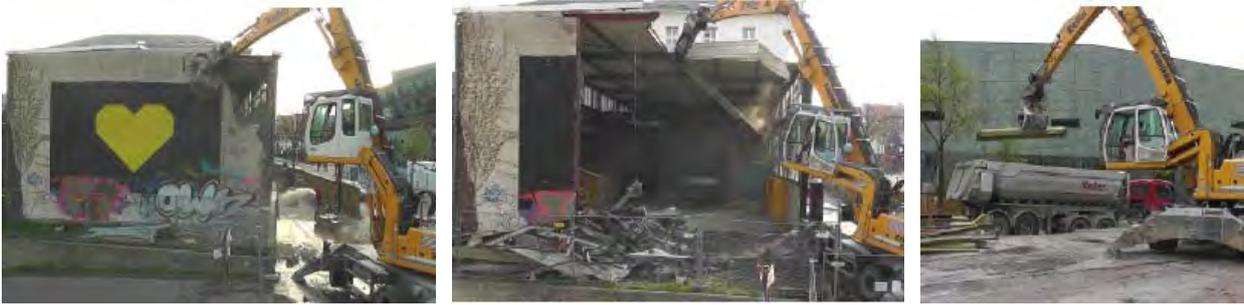
Abbildung 82: Abgreifen einer Wand, Scherschneiden eines Riegels, Verladen von Abbruchmaterialien
