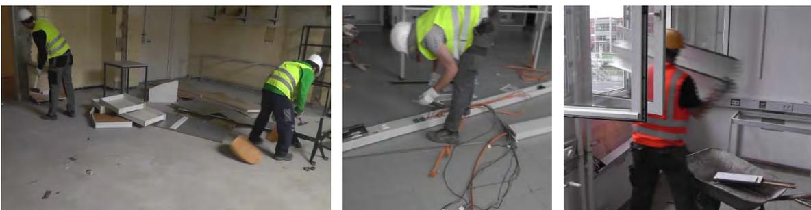
Abbildung 67: Trennung der unterschiedlichen Materialien
