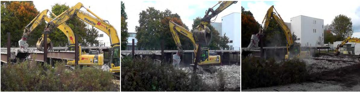
Abbildung 52: Abbruch oberirdisches Tragwerk - 1. Parkhaushälfte
