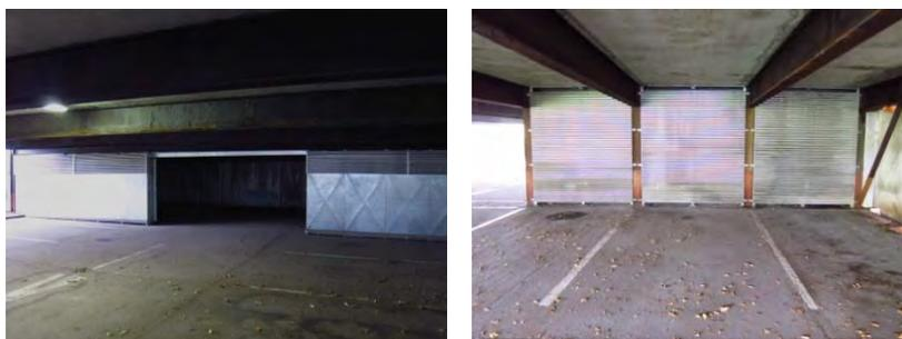
Abbildung 46: Schiebeter (l.) und Stahlwellblechwand (r.)
