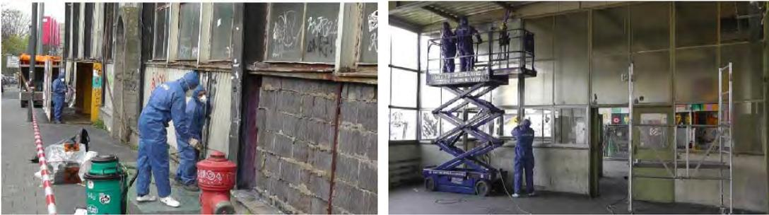
Abbildung 80: Ausbau von Faserzementplatten sowie von Fensterkitt
