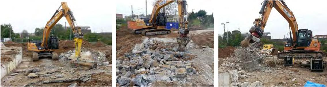
Abbildung 95: Rückbau des unterirdischen Tragwerks; Greifen aussortierter Bewehrung (v.l.)
