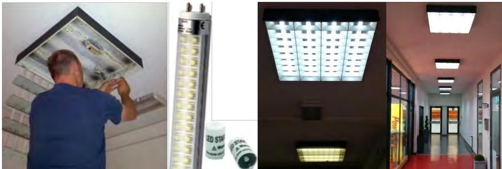
Abbildung 12 Einbau der LED-Replacements; LED-Kit; Vorher-Nachher; Stichflur
