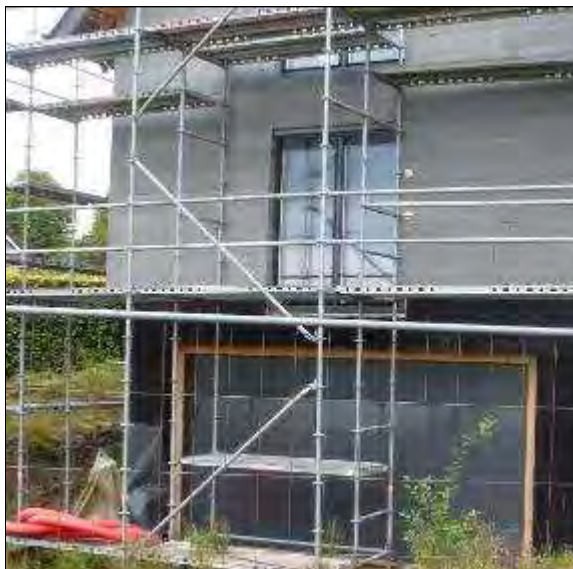
Abb. 21: Übersicht – das Gelände steigt zur Gebäuderückseite an
