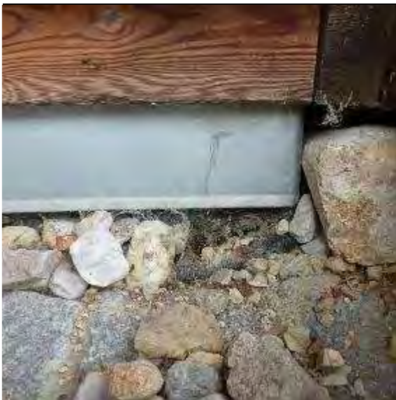
Abb. 67: Freigelegte Sockelabdichtung: Bitumenbahn unter der Blechbekleidung
