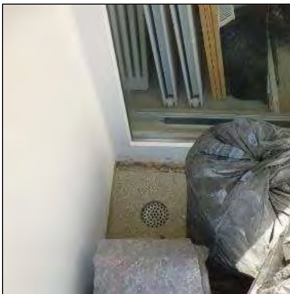
Abb. 79: Lage der Balkonentwässerung im obersten Geschoss
