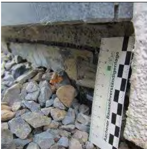
Abb. 75: Auskragender Schalungsstein
