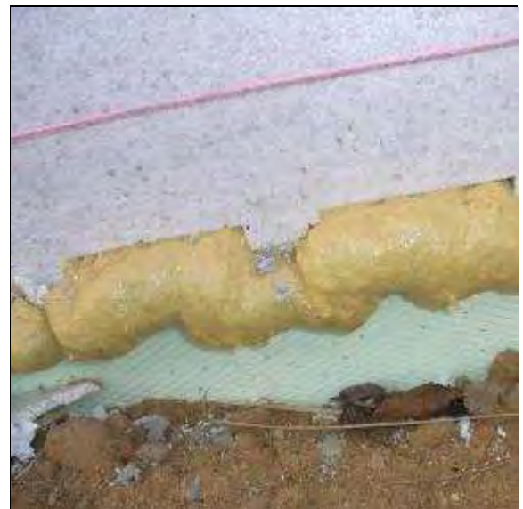
Abb. 16: Die Fuge zwischen Perimeterdämmung und Außenwandmauerwerk wurde mit Ortschaum verschlossen
