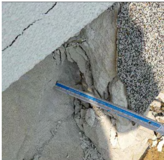
Abb. 13: Die Abplatzungstiefe des Mauerwerks beträgt bis zu 20 cm
