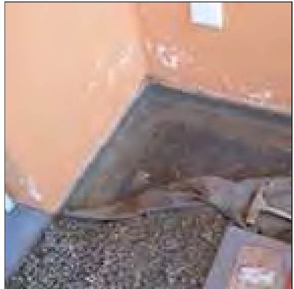
Abb. 30: Bahnenförmige Abdichtung mit Randanschlüssen aus mineralischer Dichtungsschlämme
