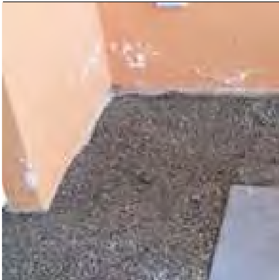
Abb. 29: Balkon mit Plattenbelag im Splittbett und Ausblühungen des Putzes in der Sockelzone
