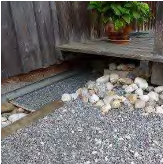
Abb. 65: Hauseingang mit Schwellenbereich oberhalb der Spritzwasserzone
