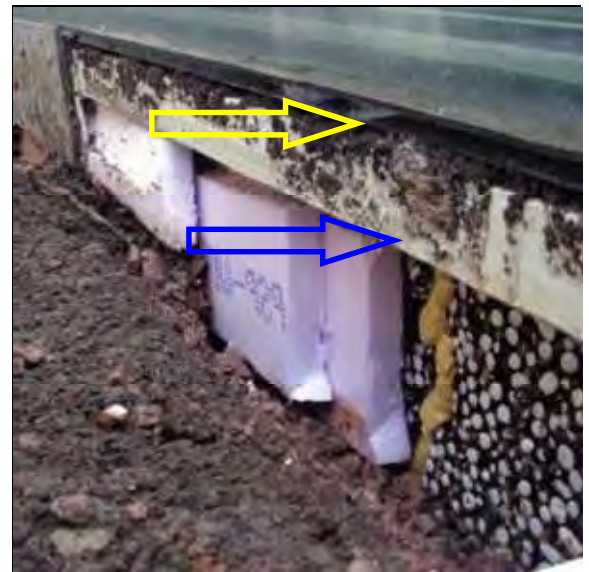
Abb. 40: Nach dem Entfernen der außenseitigen Platte: Die Abdichtung endet im Bereich des Fassadensockels auf der Unterseite der Fassadenkonstruktion (blauer Pfeil) oberhalb der Oberkante des Geländes (gelber Pfeil)
