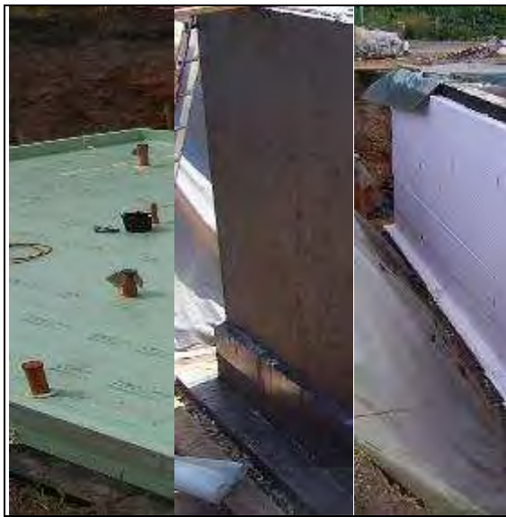
Abb. 49: Fotos zum Bauablauf
