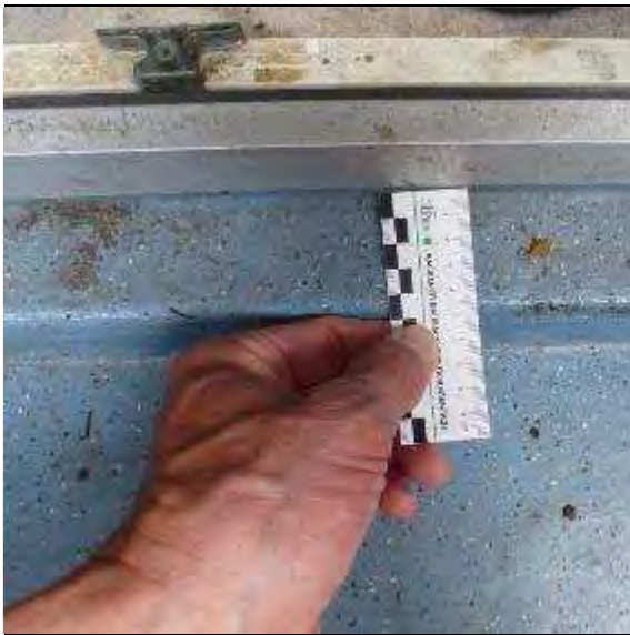
Abb. 81: Die Beschichtung ist bis auf die Türschwelle geführt
