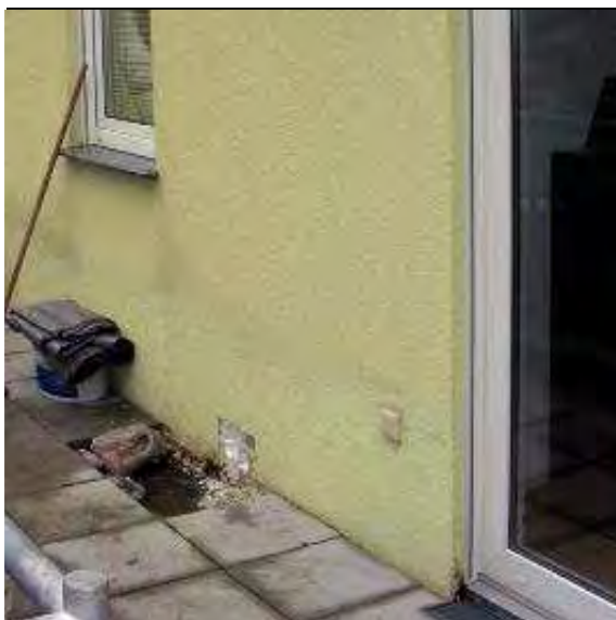
Abb. 43: Übersicht zum Sockelanschluss des WDVS
