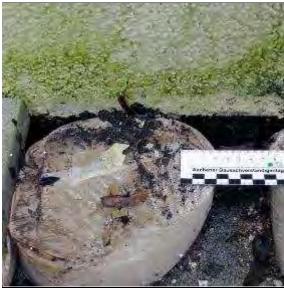
Abb. 45: KMB-Abdichtung als Instandsetzung des WDVS
