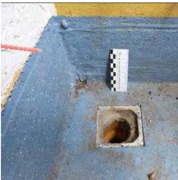
Abb. 83: Entwässerung der Balkone über Bodenabläufe
