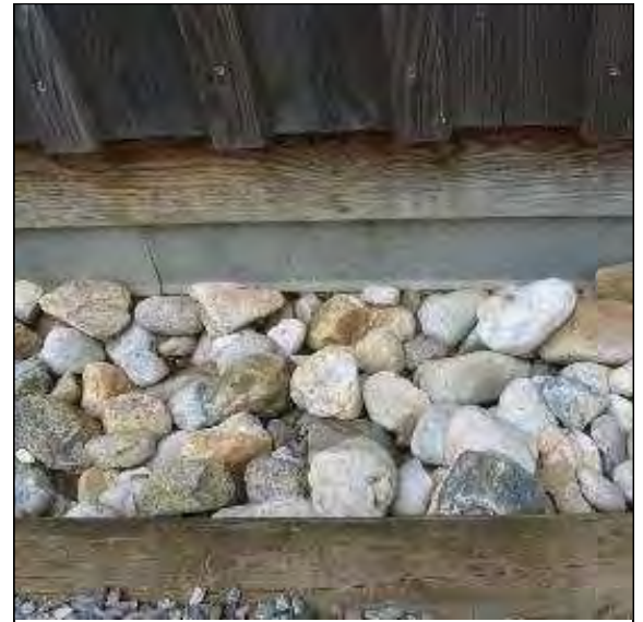
Abb. 66: Blech-Bekleidung über der Sockelabdichtung
