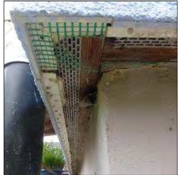
Abb. 62: Untersicht der hinterlüfteten Bekleidung
