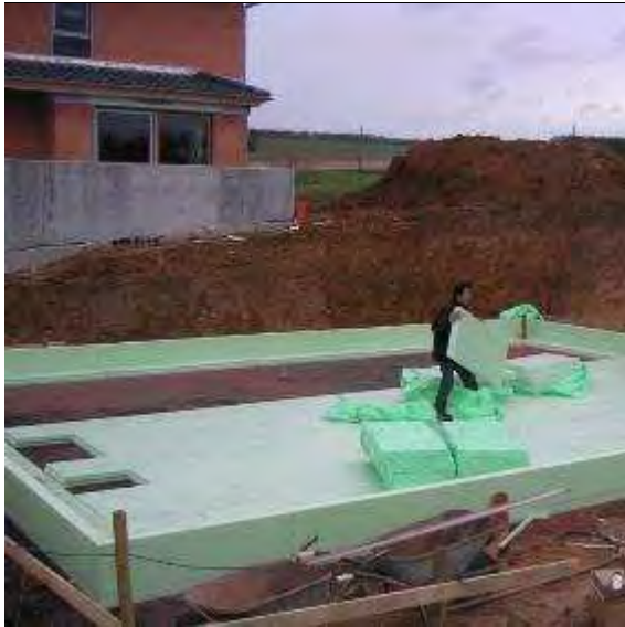
Abb. 51: Bodenplattendämmung
