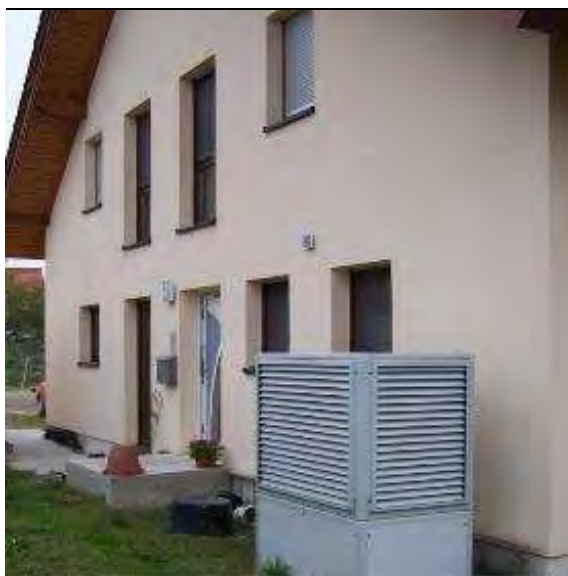
Abb. 47: Übersicht zur Hauseingangssituation
