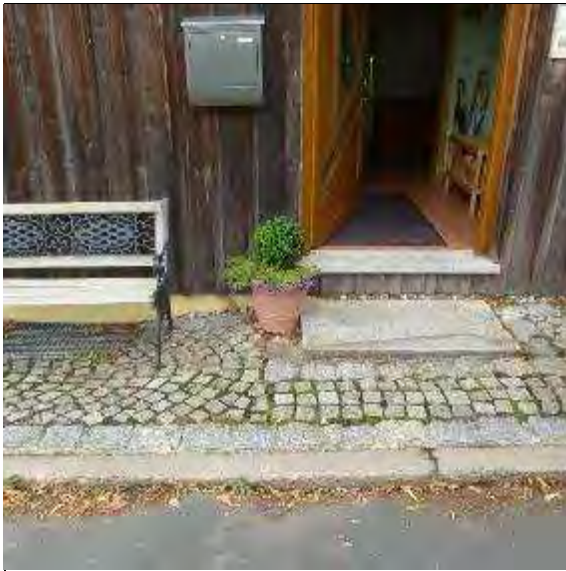
Abb. 55: Sockelanschluss neben der Hauseingangstür
