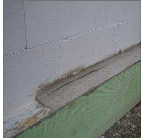
Abb. 52: Herstellen einer Mörtelhohlkehle
