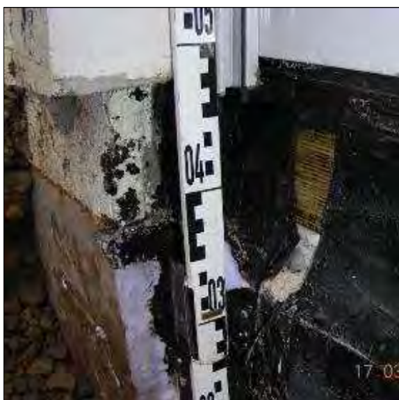
Abb. 27: Detailaufnahme im Bereich der Türschwelle
