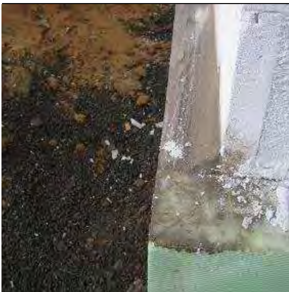
Abb. 53: Abschrägen des Anschlusses zwischen Bodenplatte und Außenwand
