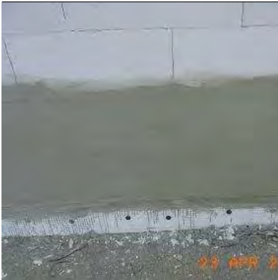
Abb. 17: Abdichtung des Sockelbereiches mit mineralischen Dichtungsschlämmen
