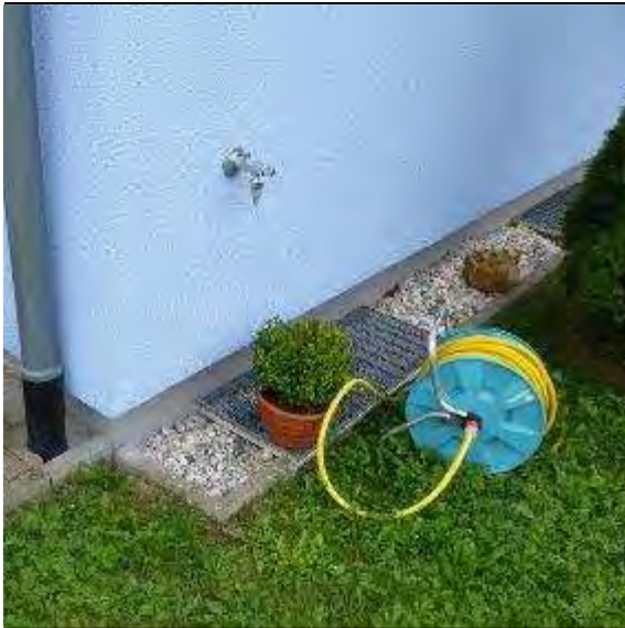
Abb. 61: Verputzter Gebäudesockel
