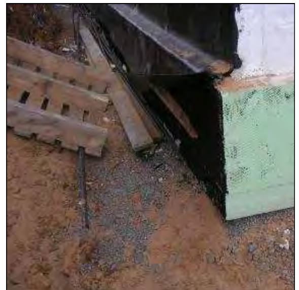
Abb. 54: KSK-Abdichtung entlang des Boden-Wand-Anschlusses
