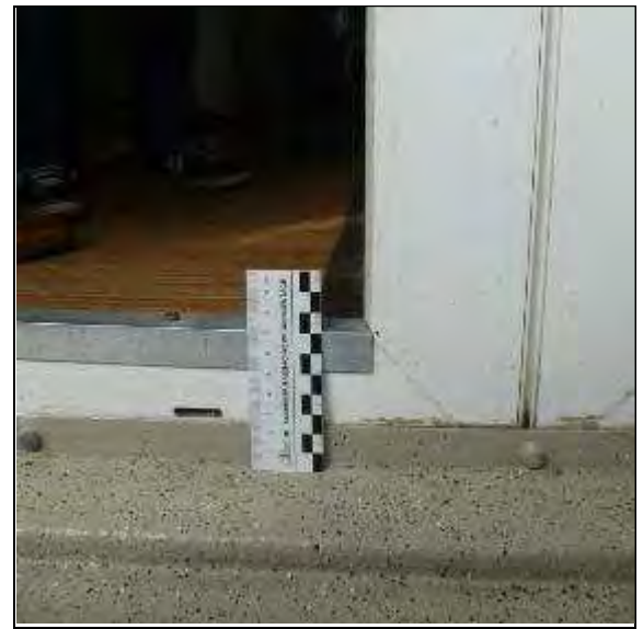
Abb. 78: Die Beschichtung schließt das aufgekantete Randan- schlussblech mit ein
