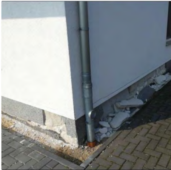
Abb. 11: Übersicht zum schadenbetroffenen Sockel
