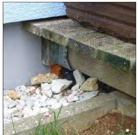
Abb. 64: Anschlussdetail der Gartenterrasse mit Höhenversprung zum angrenzenden Gelände
