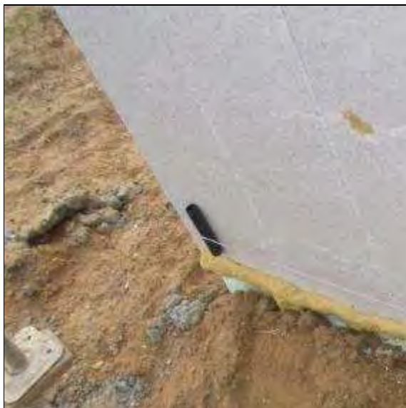
Abb. 15: Außenwand aus ausbetonierten Polystyrolblöcken als Abdichtungsuntergrund
