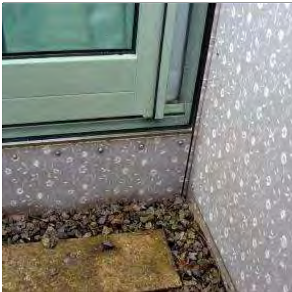
Abb. 39: Einbausituation neben der niveaugleichen Türschwelle
