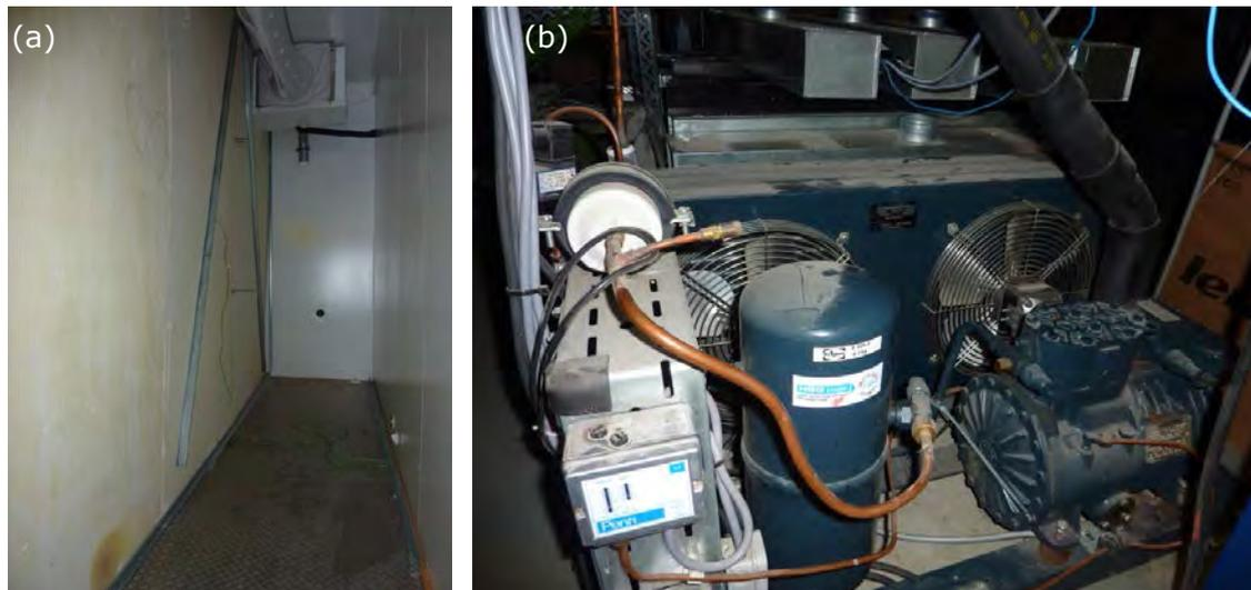
Abbildung 2: Aufnahmen der Klimakammer (a) mit an der Decke installiertem Verdampfer und Strömungsgleichrichter aus Kunststoffplatten mit wabenförmigen Öffnungen sowie der Kompressionskältemaschine unterhalb des Versuchsstandes (b)
