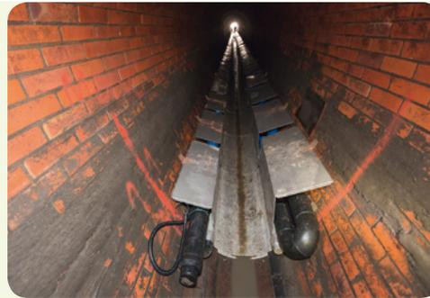
**Abb. 28:** Abwasserkanalnetz Wüstenrot (links), Wärmetauscher in einem Abwasserkanal (rechts, Quelle: Berliner NetzwerkE, Dietmar Gust)
