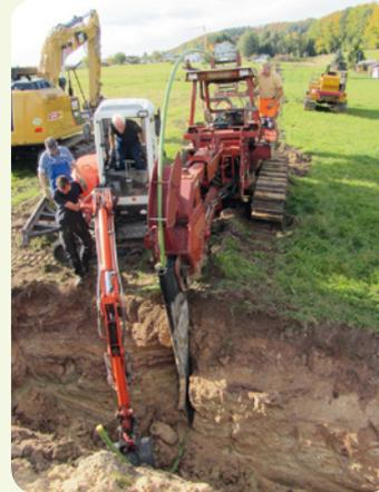
**Abb. 76:** Traktorpflug beim Einlegen der Kollektorrohre (Quelle: zafh.net, Doppelacker GmbH)
