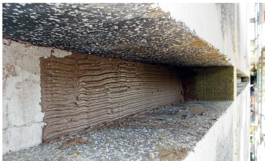
**Abb. 4:** Brandriegelsanierung im Floating Buttering Verfahren
