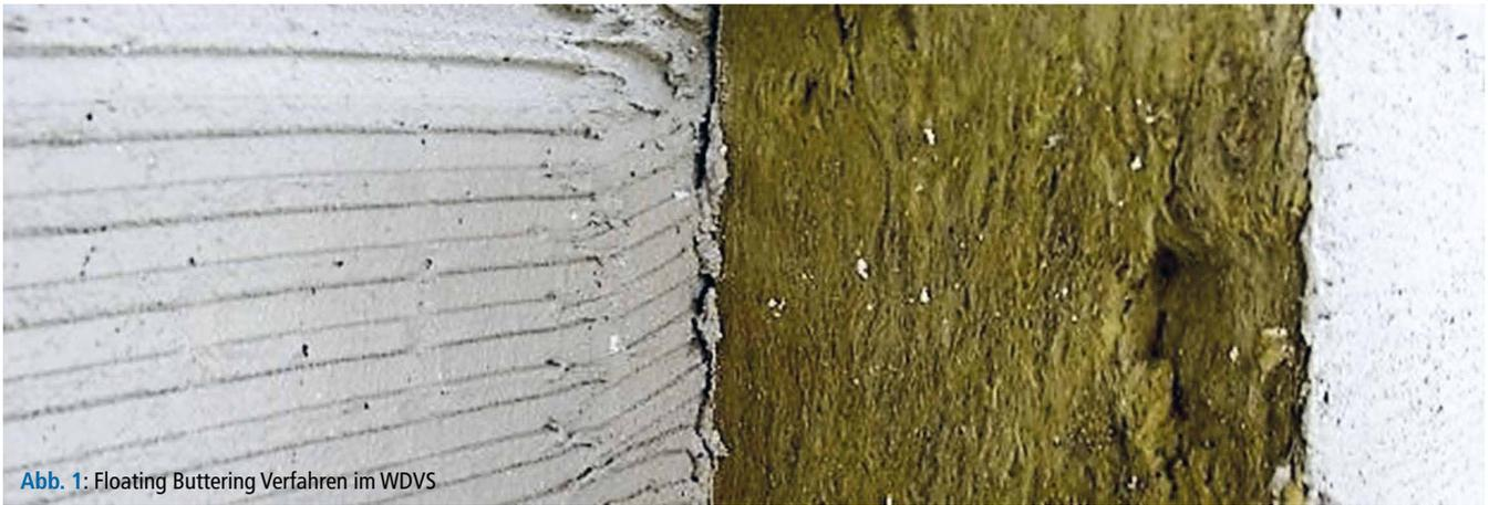
Abb. 1: Floating Buttering Verfahren im WDVS
