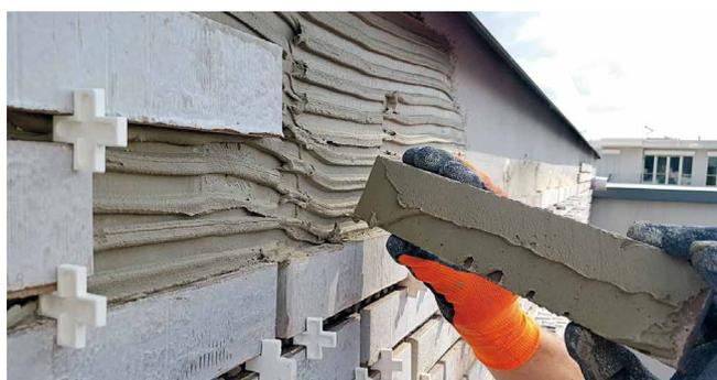
Abb. 13, 14: Einmassieren des Klebers in die Klinkerrückseite und Einlegen von Klinkerriemchen
