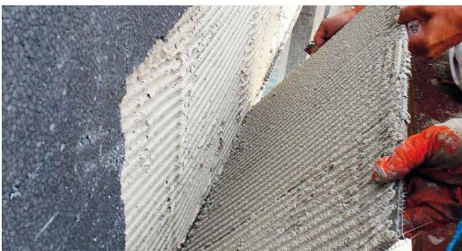
Abb. 2: Floating Buttering Verfahren im WDVS
