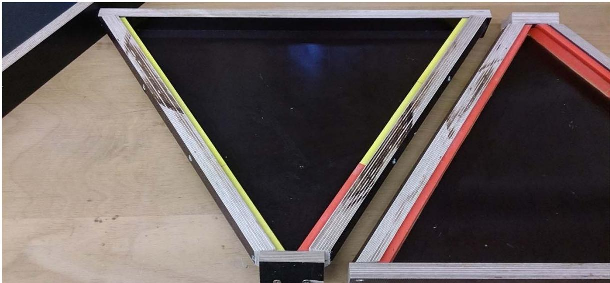
Abbildung 4.7: fertige Schalung der Bodenplatten
