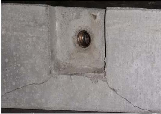
b) Risse im Massivbauteil
