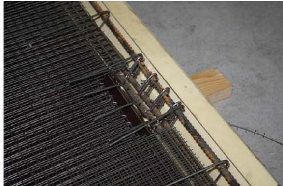
Abbildung 6.54: Detail der Bewehrungsführung im Verbindungsbereich
