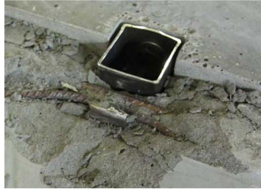
c) Freigelegte Stabstahlbewehrung und verformtes Spannschloss
