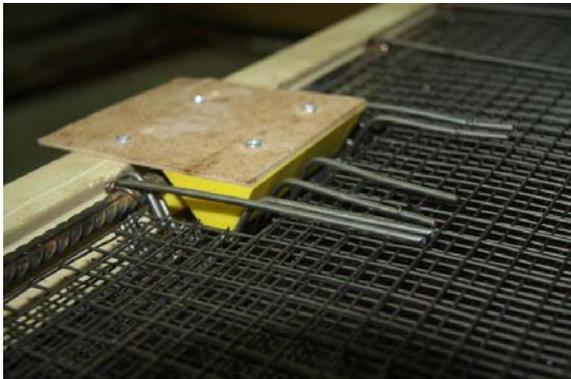
Abbildung 6.53: Schalung im Bereich der Verbindungspunkte
