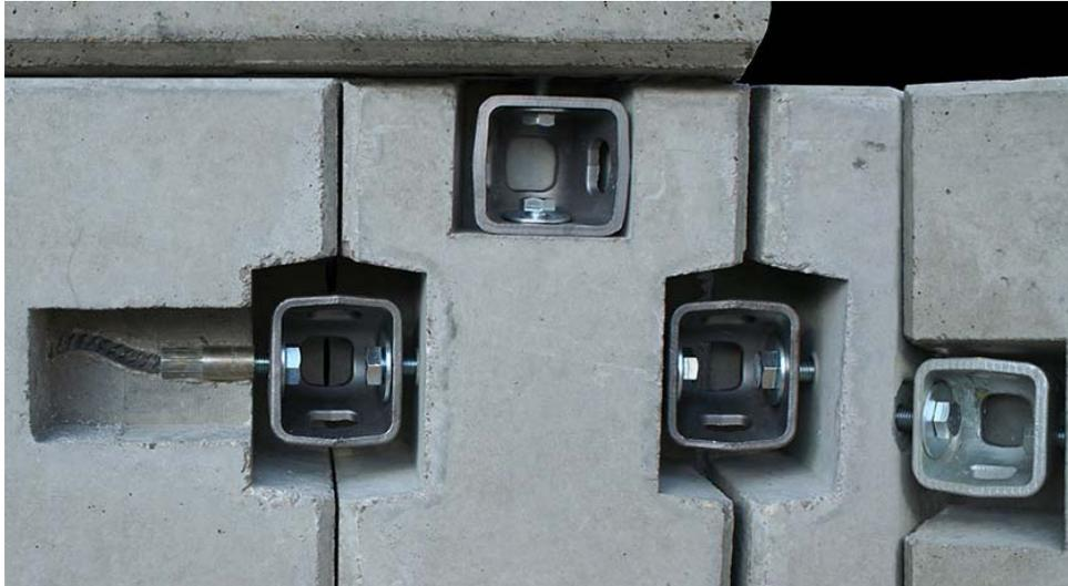
Abbildung 6.38: BT-Spannschluss-Verbindung mit Schrauben und Ankern
