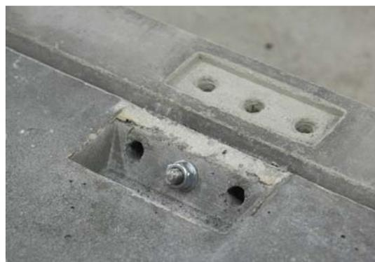
Abbildung 6.60: Detail Verbindungsbereich zwischen Wand und Stütze
