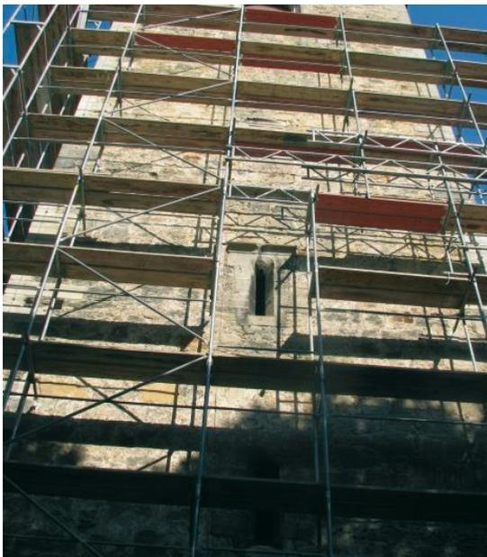
Abbildung 23. Das schmale Fenster dient den Fledermäusen als Aus- und Einflug. Das Gerüst wurde großräumig um die Öffnung freigehalten (keine Gerüststangen) und nicht mit Planen verkleidet. (Foto: W. Schorcht)
