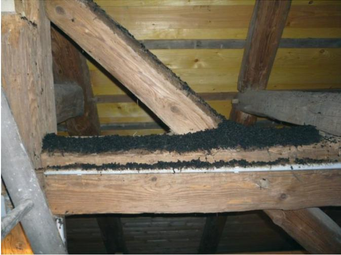
Abbildung 65. Massive Kotalagen (>1 Jahr) insbesondere auf dem waagerechten Balken unter dem Hangplatz.
