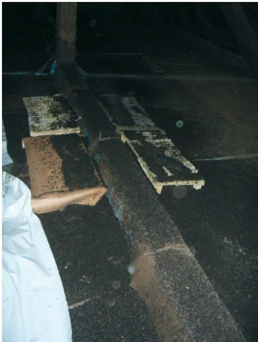
Abbildung 84. Massive Kotauflage auf den Musterflächen zum Vergleich der Abdeckungen
