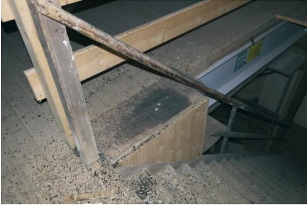
Abbildung 78. Durch Kot und Urin beaufschlagter Bereich direkt neben der Eingangsluke; Abdeckung mit transparenter Luftpolsterfolie.
