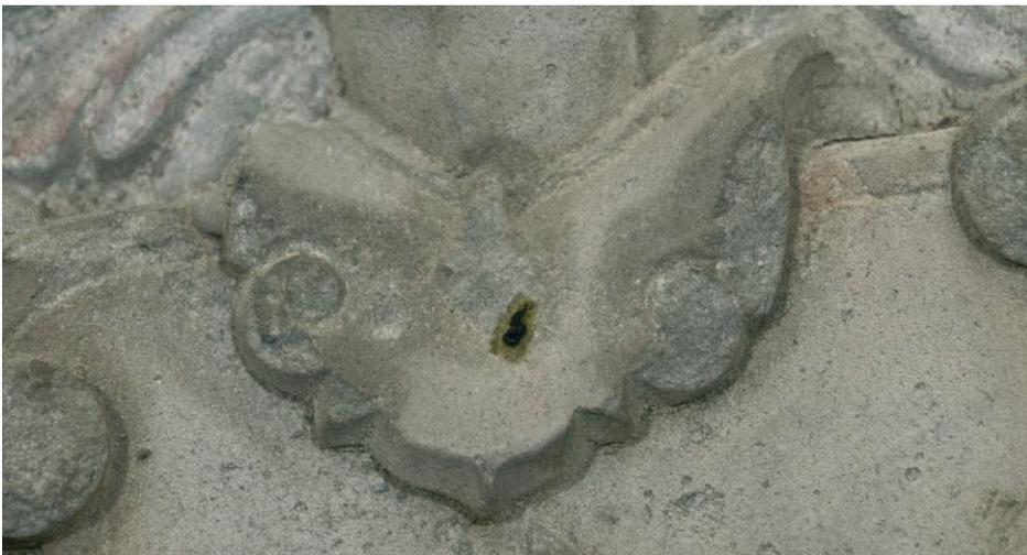
Abbildung 5. Kotalage auf einer Skulptur (Detail). Gut zu erkennen ist der durch in den Stein eingedrungene Feuchtigkeit erzeugte „Hof“. (Foto: B. Hübner)
