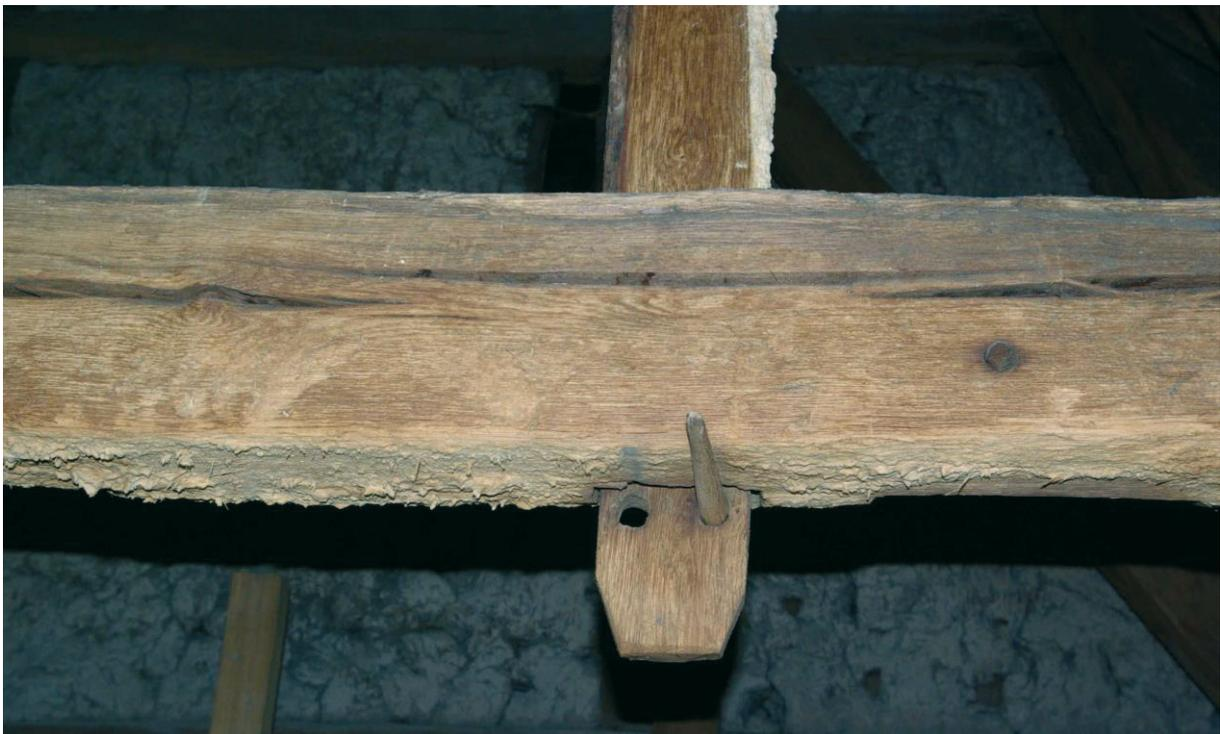
Abbildung 5. Meisenheim, Schlosskirche, durch Feuerschutzsalze geschädigtes Holz (Mazeration)
