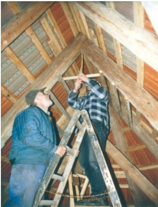
Abbildung 16. An die Innenseiten der Ziegel wurde Mörtel gespritzt, um diese für die Fledermäuse griffiger zu machen (im Bild grau). (Foto: FSU Jena)
