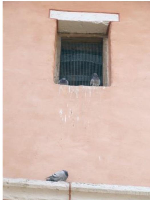
Abbildung 17. Das Aussperren von verwilderten Tauben und gleichzeitige Beibehalten von Ein- bzw. Ausflugsöffnungen für die Kleinen Hufeisennasen stellte eine der Herausforderungen dar, die für jedes Objekt eine individuelle Lösung erforderlich macht. (Foto: M. Biedermann)
