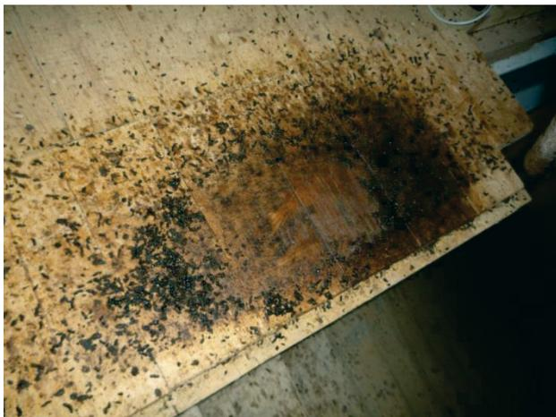
Abbildung 77. Durch Kot und Urin belasteter Bereich direkt neben der Eingangsluke; der Feuchteintrag ist deutlich zu erkennen.
