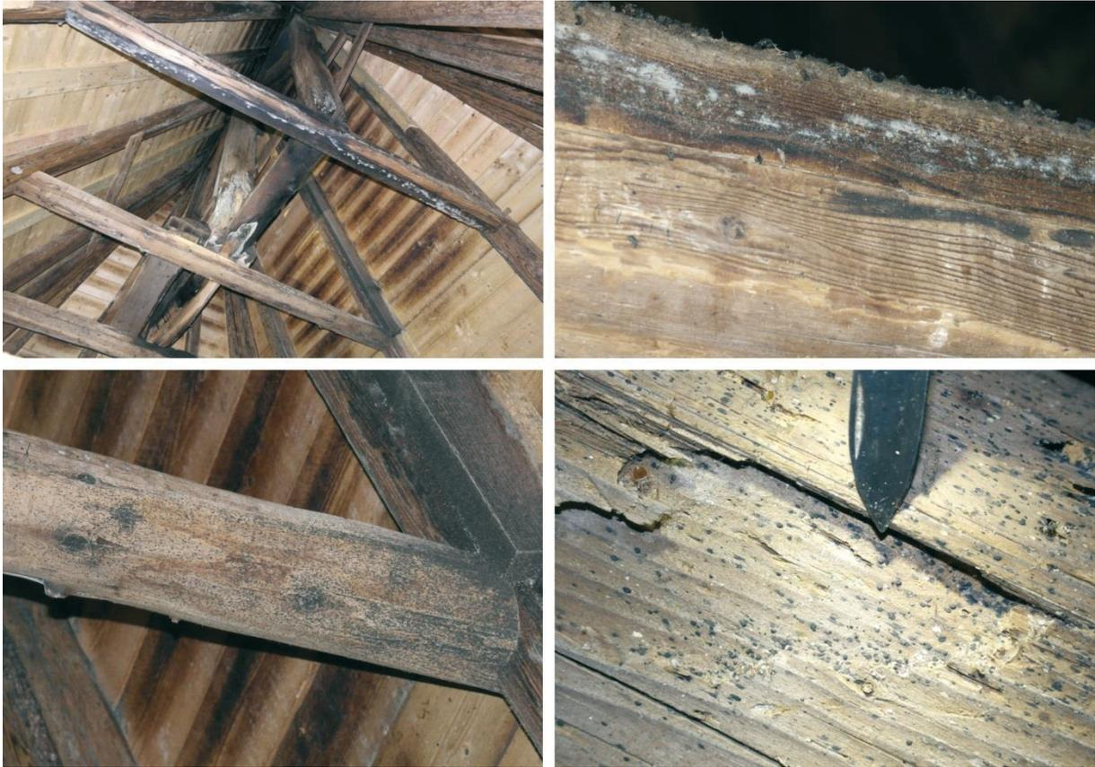
Abbildung 45. Günserode, Kirche, unterhalb des Hangplatzes (Großes Mausohr). In der oberen Reihe sind helle Flecken zu erkennen (Probe 1 – Schimmel und Salzausblühungen) und in der unteren Reihe sind dunkle Punkte erkennbar (Probe 5), die sich ebenfalls als Schimmelpilz identifizieren ließen.
