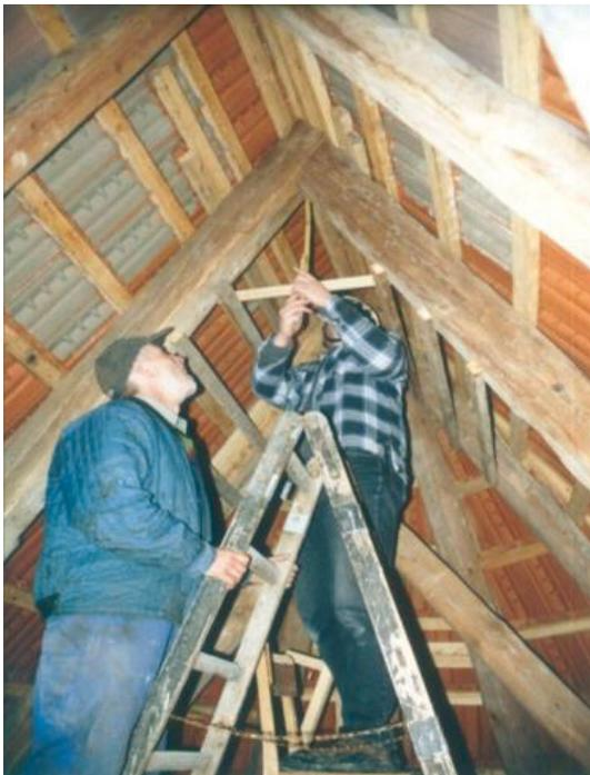
Abbildung 97. An die Innenseiten der Ziegel wurde Mörtel gespritzt, um diese für die Fledermäuse griffiger zu machen (im Bild grau).
