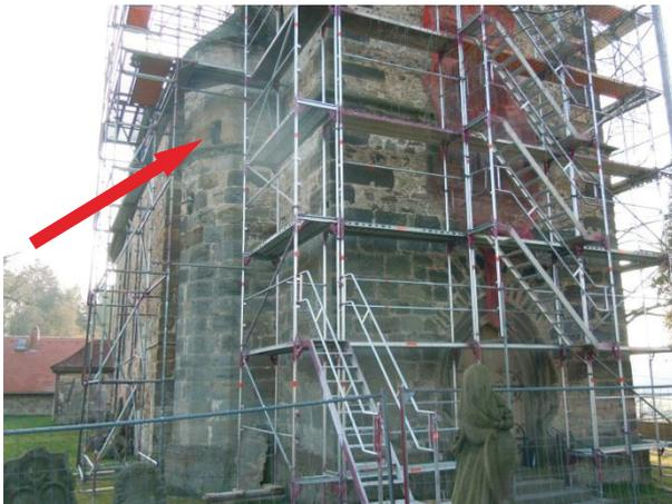
Abbildung 20. Einflug siehe Pfeil, Gerüst wurde großräumig um Öffnung freigehalten (keine Gerüststangen) und nicht mit Planen verkleidet, um Ein- und Ausflug nicht zu behindern. Der Zugang zur Baustelle im oberen Turmbereich erfolgte über einen Gerüsttreppenturm. (Foto: M. Franz)
