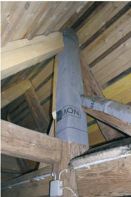
Abbildung 73. Unterspannbahn an vertikalem und schrägem Balken nach Beaufschlagung mit Exkrementen.
