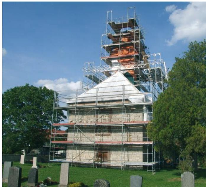
Abbildung 92. Dachsanierung der Kirche von Großkröbitz: In der Sommersaison 2013, war der Dachstuhl für die Fledermäuse gar nicht nutzbar.
