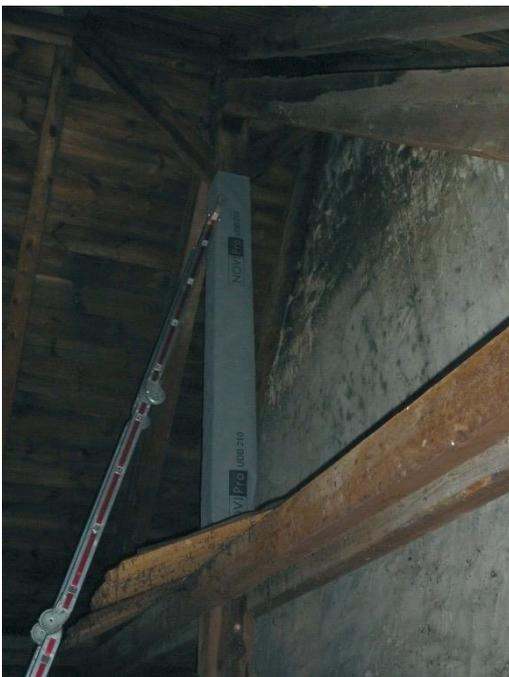
Abbildung 83. Unterspannbahn an vertikalem Balken im Bereich des Haupthangplatzes. Das Klimagerät befindet sich unter der Einhüllung, auf der dem Mauerwerk zugewandten Seite des Balkens.
