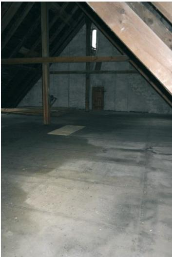
Abbildung 79. Feuchte Bereiche auf dem Boden.
