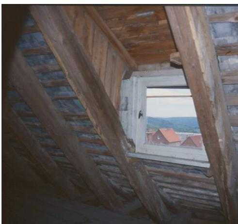
Abbildung 13. Dauerhaft gesicherte Einflugsöffnung in Form eines geteilten Fensters). Im oberen Fünftel des Fensters wurde das Glas entfernt und mit einer Fensterleiste neu abgeschlossen. Foto: (I. Karst)
