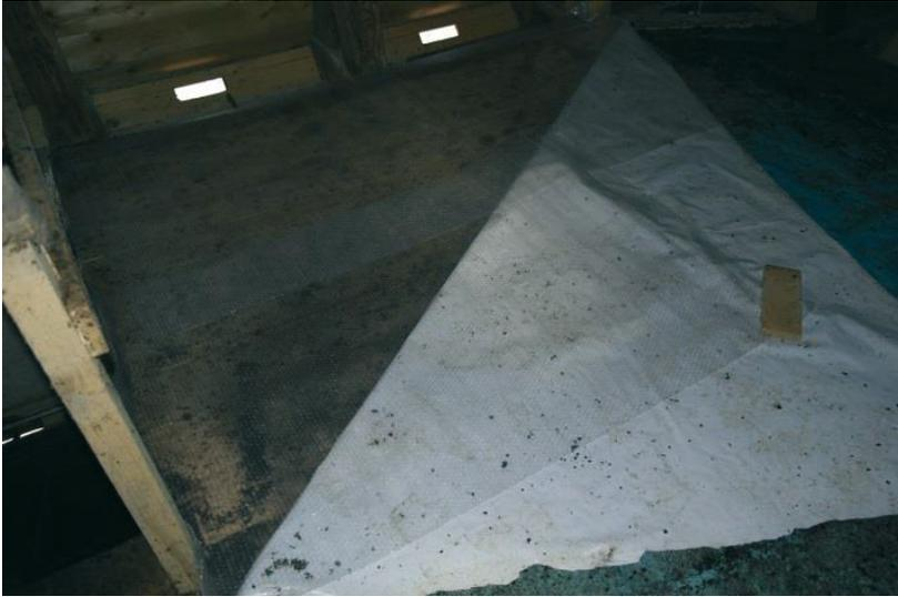
Abbildung 86 Aufgrund der hohen Feuchtwerte am 03.02.2016 wurde die Teichfolie in diesem Bereich zurückgeschlagen und eine Musterfläche mit Luftpolsterfolie angelegt.
