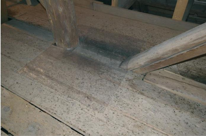
Abbildung 72. Luftpolsterfolie unter dem Hangplatz.
