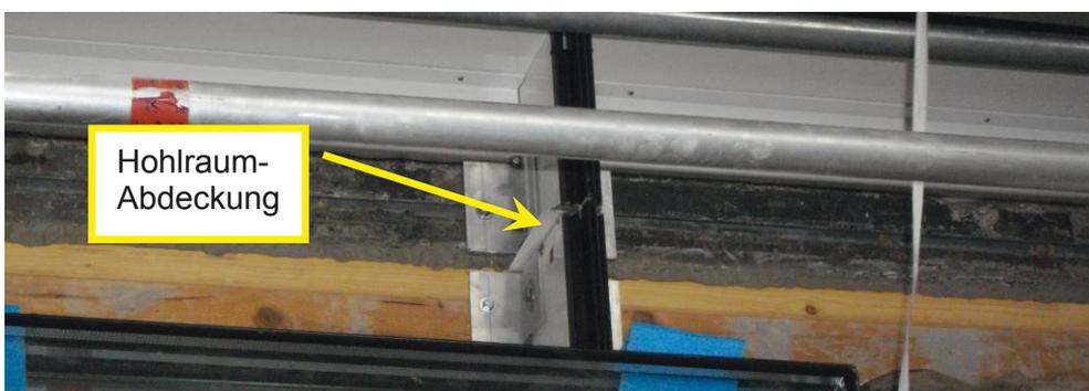
**Bild A 73** Detailfoto der Pfosten-Riegel-Fassade, getrennte Lager, Hohlraum des Pfostens abgedeckt
