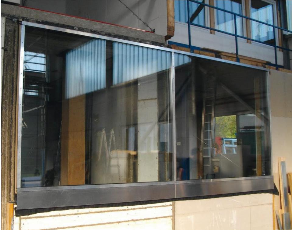
**Bild A 5** Beispiel für eine Pfosten-Riegel-Fassade ohne Einselelement im Großformat, (Bildquelle: ift Vorgang 11-002583)
