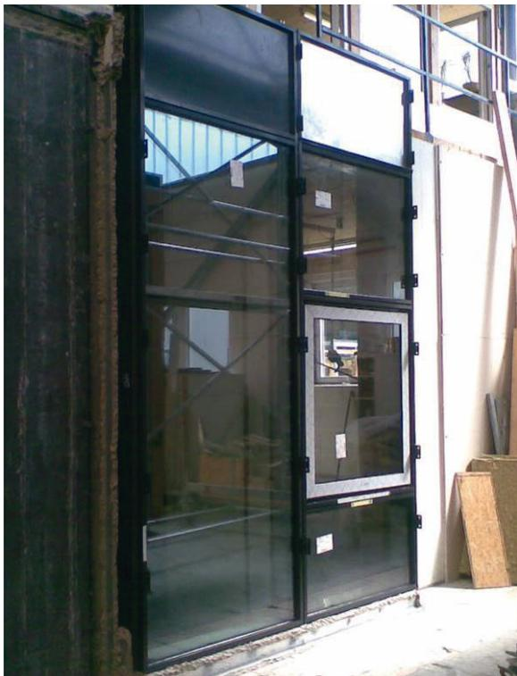
**Bild A 12** Beispiel für eine Elementfassade im Großformat (Bildquelle: ift-Vorgang 11-001961)
