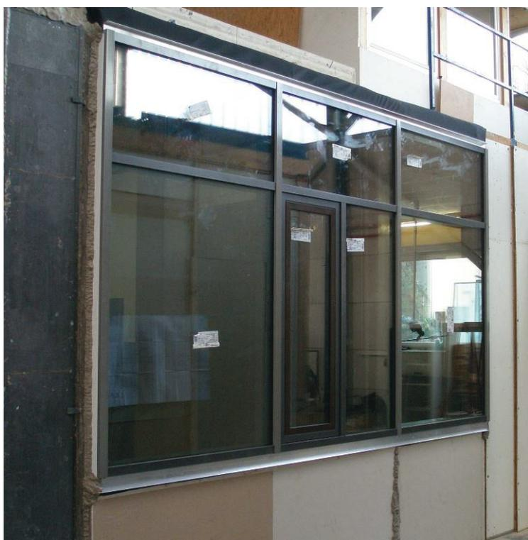
**Bild A 10** Beispiel für eine Pfosten-Riegel-Fassade mit Einsetzelement im Großformat, (Bildquelle: ift Vorgang 169 41537)
