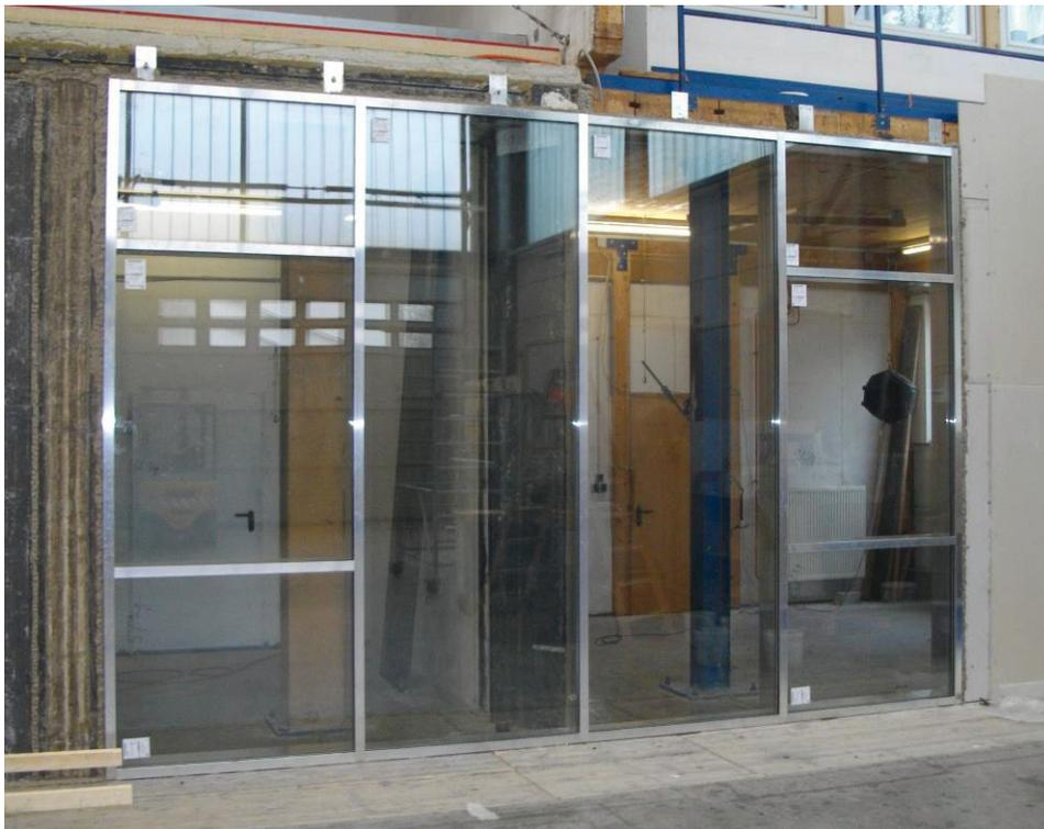
**Bild A 6** Beispiel für eine Pfosten-Riegel-Fassade ohne Einselelement im Großformat, (Bildquelle: ift Vorgang 310 45302)
