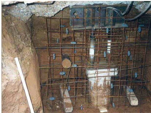
**Bild 33** Segmentpfähle in der unter dem Fundament hergestellten Presskammer
