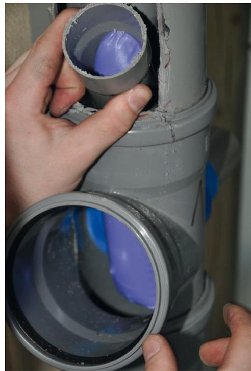
Abb. 16 Inversion und Fangen des Kalibrierschlauchs (Veser 2015)
