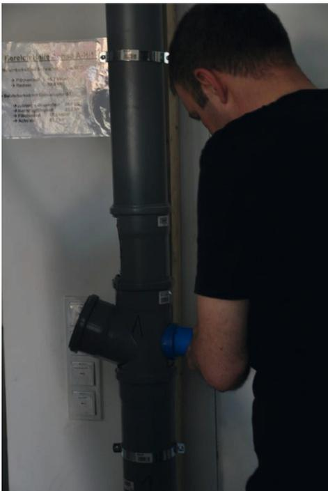
Abb. 11 Einbringen und Fixieren des Anschlussstutzens während der Inversion (Veser 2015)
