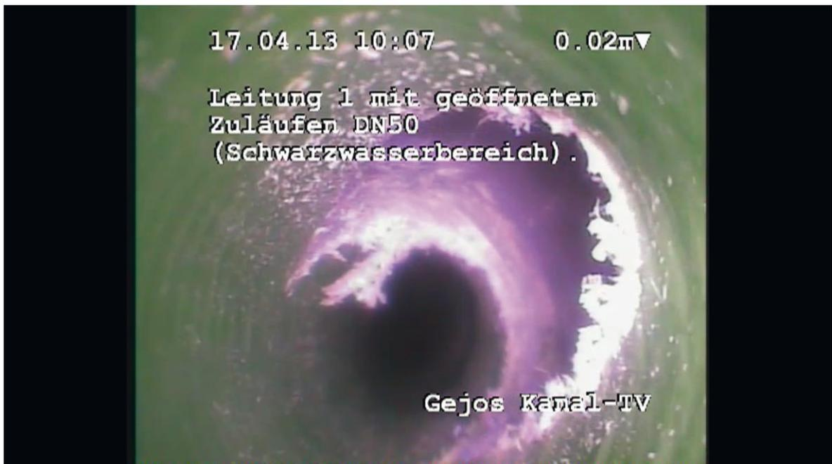
Abb. 20 Rohrleitungsinspektion des SW-Liners an der Anschlussstelle von Teststrecke 1 mit-Kamera Gejos PIC5.5 Peli (Veser 2015)
