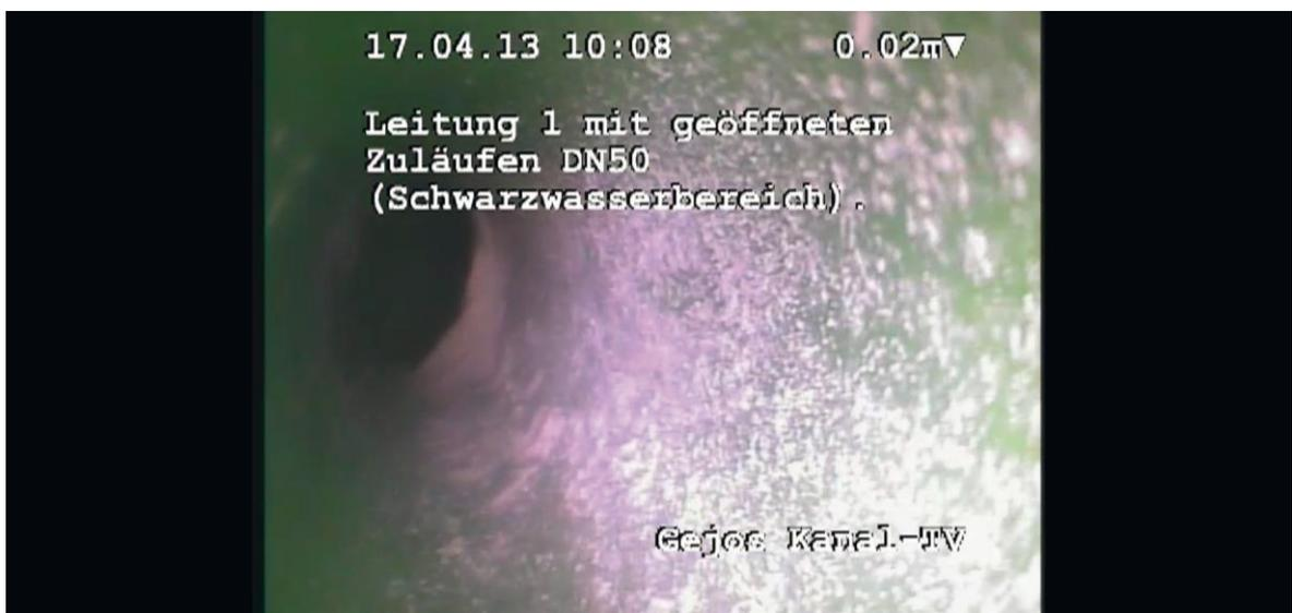
Abb. 21 Rohrleitungsinspektion des SW-Liners kurz vor dem Bogen am Ende von Teststrecke 1 mit-Kamera Gejos PIC5.5 Peli (Veser 2015)
