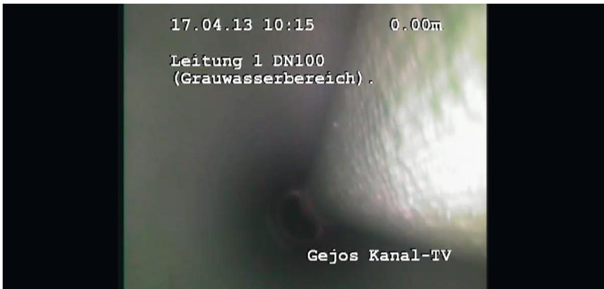
Abb. 22 Rohrleitungsinspektion des GW-Liners mit-Kamera Gejos PIC5.5 Peli (Veser 2015)
