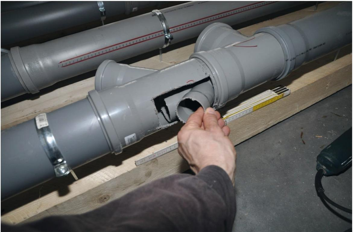
*Abb. 13 Vorbereitung des Anschlusses für den Schwarzwasserliner (Veser 2015)*
