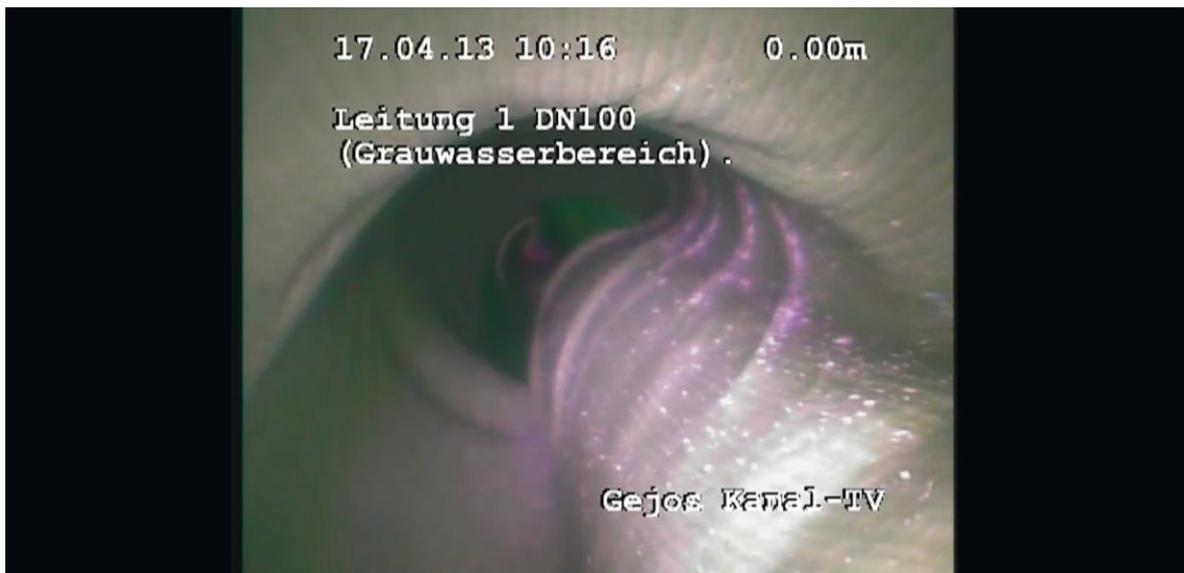
Abb. 24 Rohrleitungsinspektion des GW-Liners kurz vor dem Bogen am Ende von Teststrecke 1 mit Kamera Gejos PIC5.5 Peli (Veser 2015)
