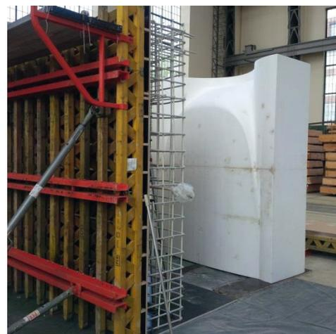
Bild 111: Bewehrung Prototyp 1
