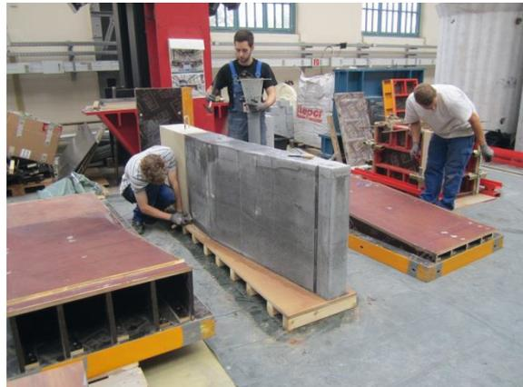
Bild 136 (oben): Ausschalen des Prototyps
