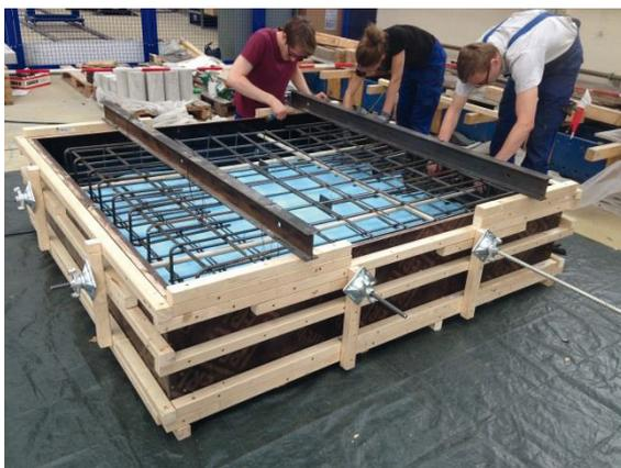
Bild 151: Zusammenbau der Schalung
