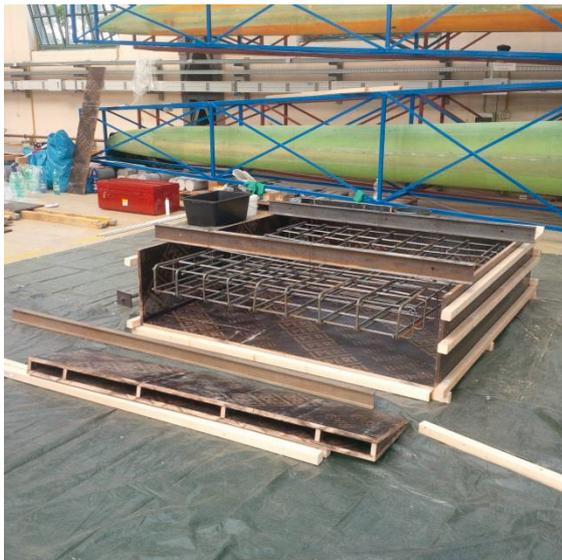
Bild 149: Schalung mit eingehängtem Bewehrungskorb
