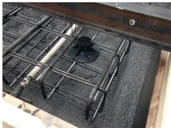
Bild 152: Mofi-Ankerteil zum späteren Aufstellen
