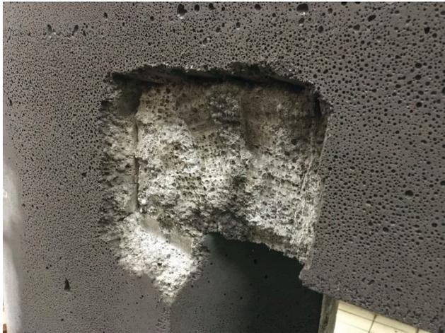
Bild 130: Öffnung des Bauteiles im Bereich des Fenstersturzes
