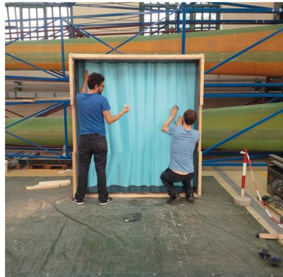
Bild 150: Bearbeitung der Oberfläche des Schalungskörpers
