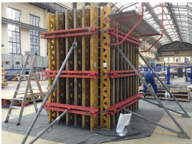
Bild 110: Aufbau Schalung Prototyp 1
