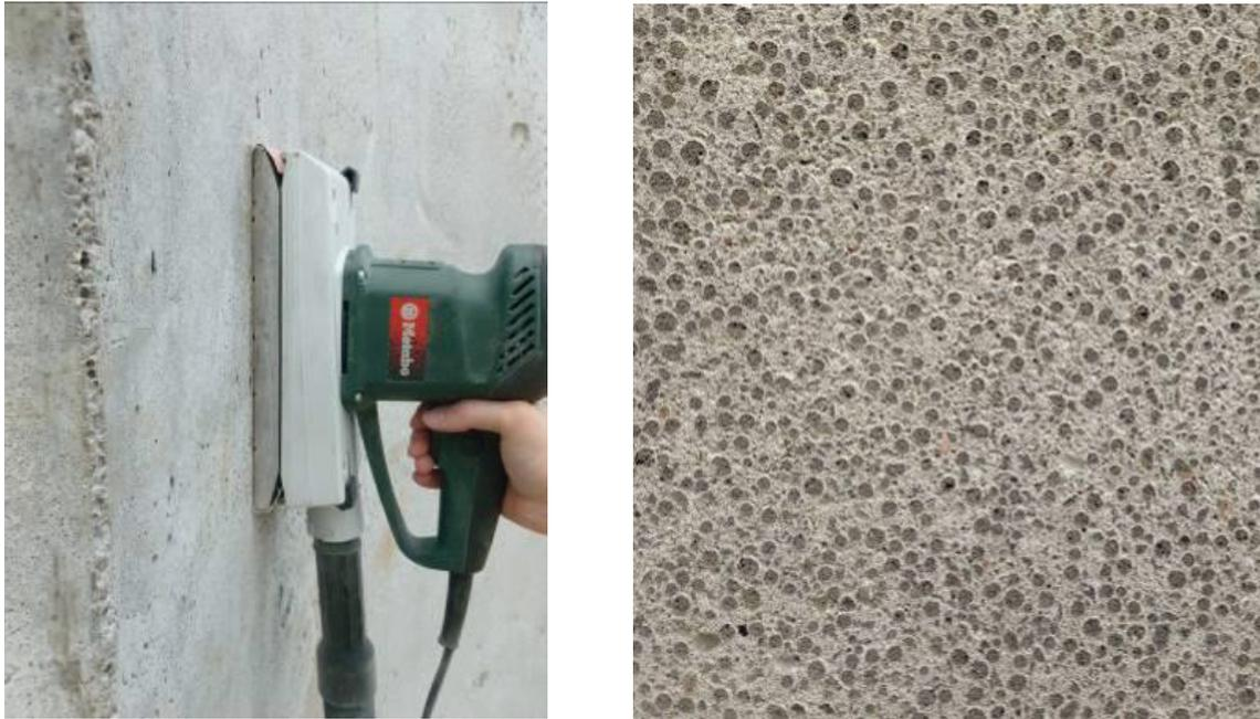
*Bild 171: Schleifgerät (links) und Oberfläche nach dem Schleifen (rechts) [67]*
