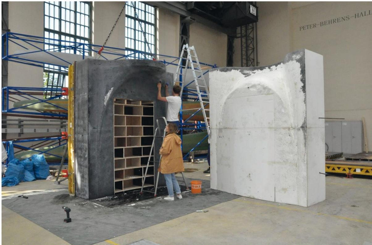
Bild 117: Ausschalen Prototyp 1
