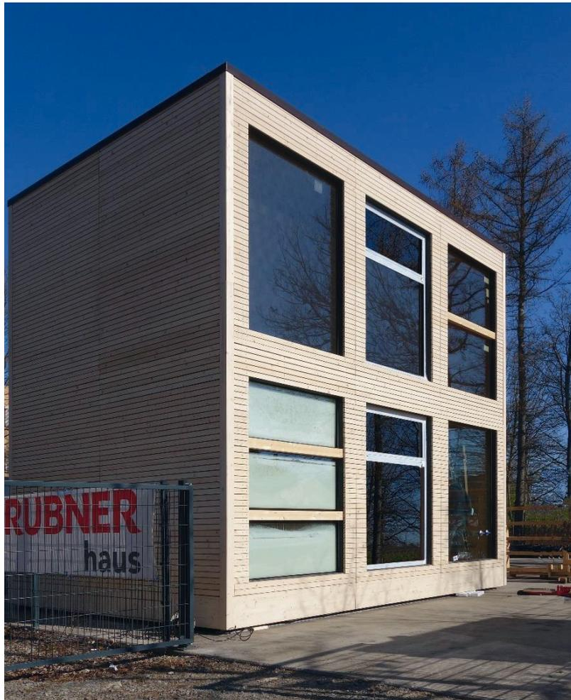
Abbildung 5-4: Die erste Testkonfiguration adaptiver Verglasungen im Fassadenprüfstand. Copyright ILEK.
