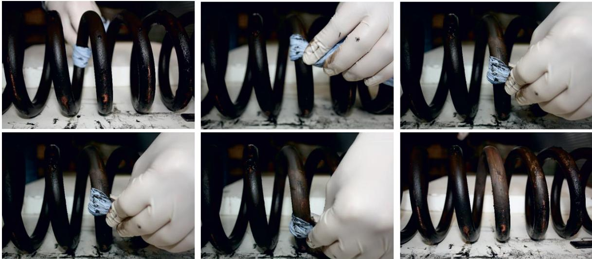
**Abbildung 57** : Mechanische Reinigung des Kupfer-Rohrwendel-Wärmeübertragers
