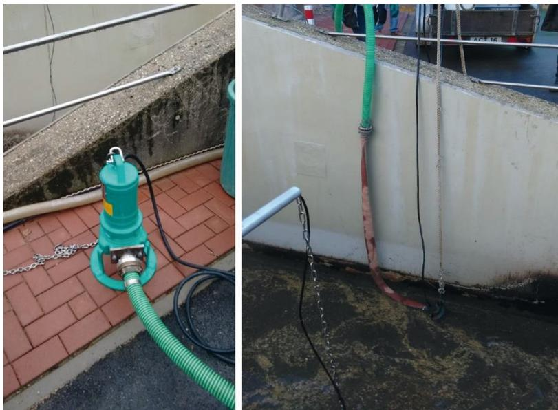
**Abbildung 20:** Abwassertransport von der Kläranlage
