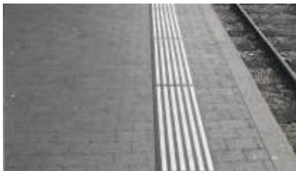
Sicherheitslinie aus Kaltplastik. Zusätzliche Wirkung zum Helligkeitskontrast durch Materialwechsel
