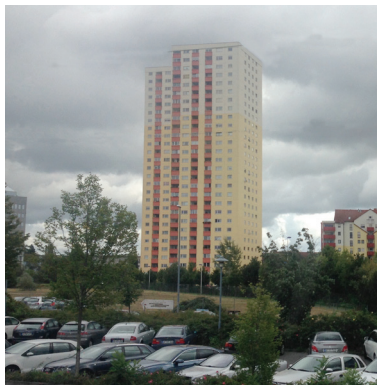
Abb. 39: Hochhaus mit Wohnnutzung Foto: Christoph Drebes
