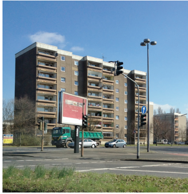
Abb. 96: Mehrfamilienhauszeile der 1970er Jahre Foto: Steffen Wurzbacher
