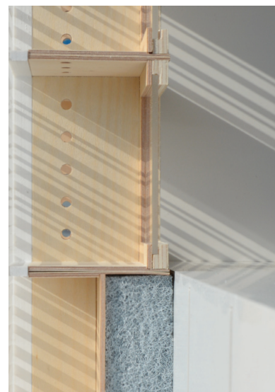
Abb. 232: Schnitt mit Anschluss Dämmpaket und Festverglasung Foto: FG ENB, Sarah Papperitz
