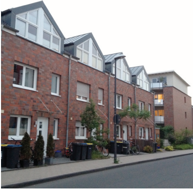
Abb. 95: Reihenhauszeile Foto: Steffen Wurzbacher
