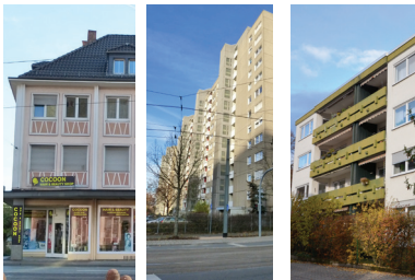
Abb. 25: variierende Fassadengestaltung Foto: Jana Weber
