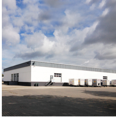
Abb. 156: Freistehende Logistikhalle Foto: Christoph Drebes
