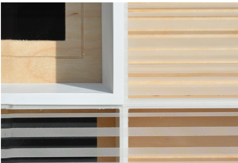
Abb. 231: Detail des Fensteranschlusses Foto: FG ENB, Sarah Papperitz
