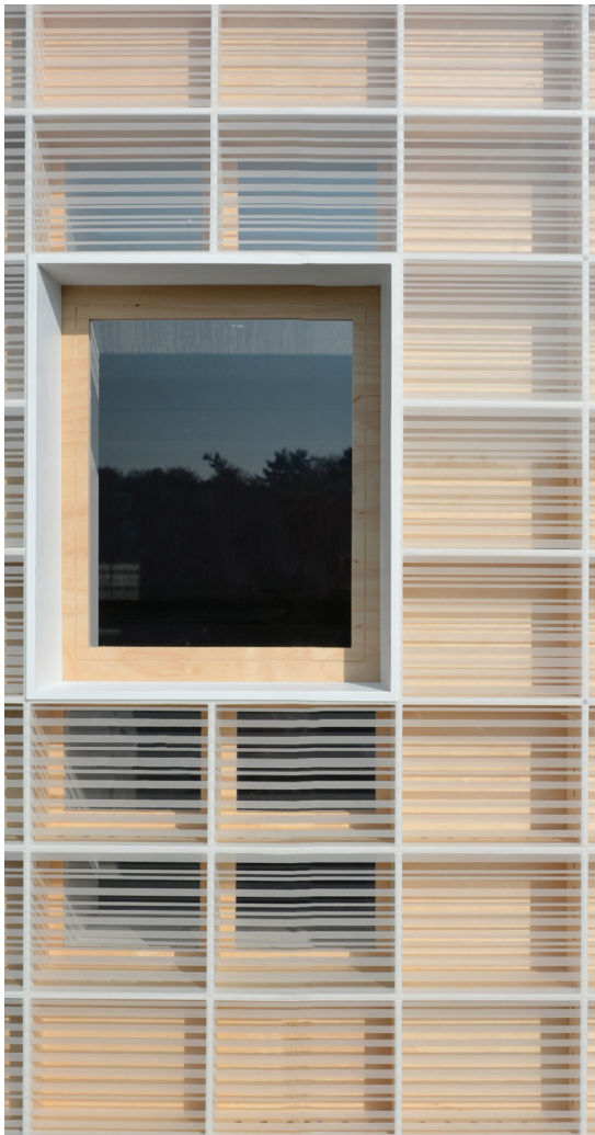
Abb. 230: solaradaptive Bürofassade "Polybox" Foto: FG ENB, Sarah Papperitz
