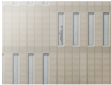
Abb. 215: Kombination schmaler, hochformatiger Fensterelemente mit kleinteiliger, transluenter organischer Photovoltaik und einsehbarem Holzrost Quelle: Eigene Darstellung
