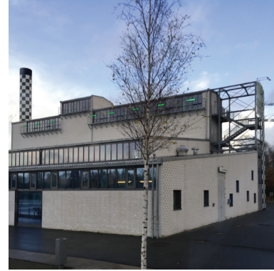
Abb. 157: Alte Fabrikhalle Foto: Christoph Drebes
