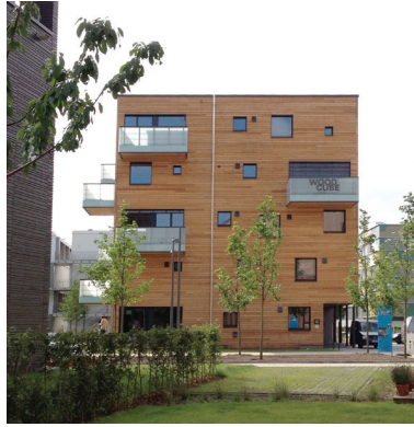
Abb. 67: modernes Mehrfamilienhaus Foto: Steffen Wurzbacher
