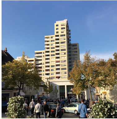
Abb. 37: Wohnungsbau der 1970er Jahre Quelle: Steffen Wurzbacher
