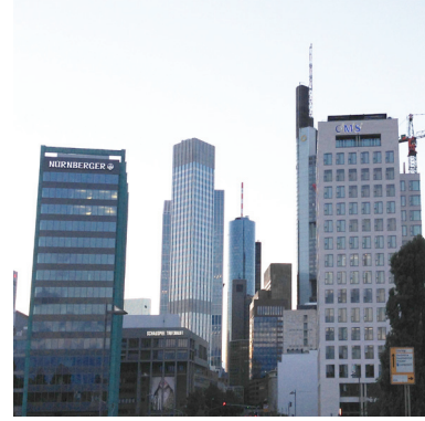
Abb. 36: Büro-Hochhäuser verschiedener Baualter Foto: Christoph Drebes
