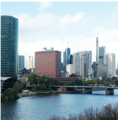
Abb. 38: Bürobau verschiedene Baualter Foto: Christoph Drebes
