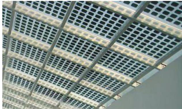
Abb. 9: Glasintegration von PV
