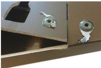
Die rückseitig angebrachte Verbindungsplatte verdrehte sich aufgrund von ursprünglich nur 2 vorgesehenen Nietverbindungen, sodass die beiden Schenkel nicht formschlüssig verbunden waren. Dies kann zu einer Verformung des gesamten Elementes führen, weshalb rückseitig eine Verbindungsplatte mit 4 Nieten vorgesehen wurde.
