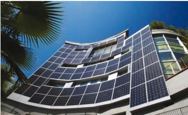
Abb. 8: BIPV-Fassade
