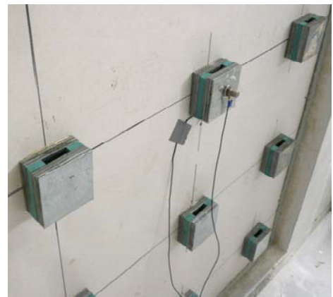
Abb. 31: Beispiel für einen der verwendeten Schwingungstilger (links) und Befestigung der Tilger auf der Wandoberfläche (rechts). In dem dargestellten Beispiel sind die Tilger auf einem quadratischen Gitter mit einem Rastermaß von 40 cm angeordnet.
