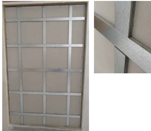
Abb. 61: Foto der streifenförmigen Beschwerung Nr. 2 als Gesamtansicht der Wand (links) und im Detail (rechts).
