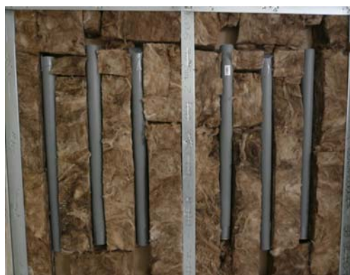
Abb. 24: Einbau der \lambda/4 -Resonatoren in den mit Mineralwolle gefüllten Wandhohlraum (dargestellt ist nur der obere Teil der Wand).
