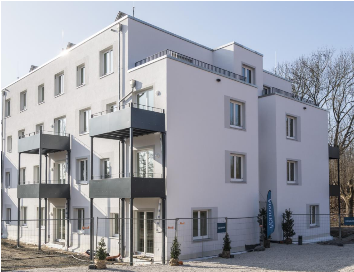
Abbildung 7: Geschosswohnungsbau in Raummodulbauweise (Betonkonstruktion) in Bayreuth, Deutschland (Bildrechte: Matthias Merz)
