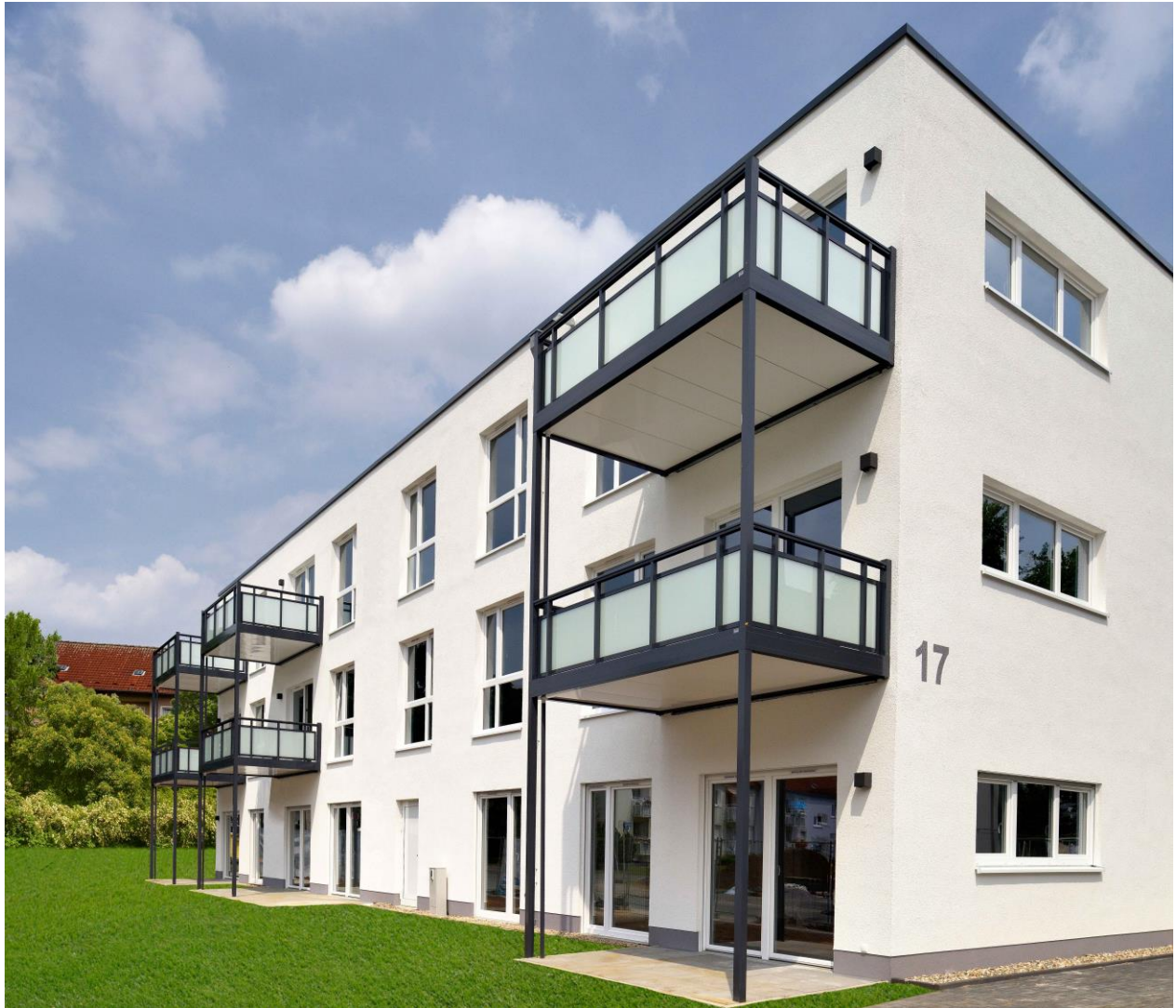
Abbildung 5: Geschosswohnungsbau in Raummodulbauweise (Stahlkonstruktion) in Dortmund, Deutschland (Bildrechte: ALHO Systembau GmbH)
