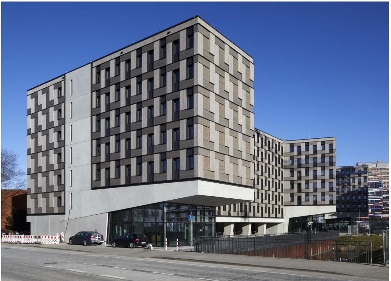
Abbildung 3: Studentenwohnheim in Raummodulbauweise (Holzkonstruktion) in Hamburg, Deutschland (Fotograf/Urheber: Götz Wrage)
