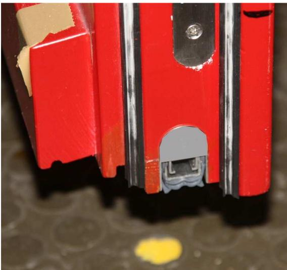
**Abbildung 24** Bodenabsenktdichtung der untersuchten Außentür
