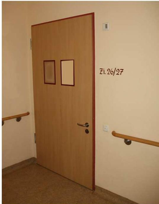
**Abbildung 5** Gute Erkennbarkeit durch Kontraste an einem Türelement
