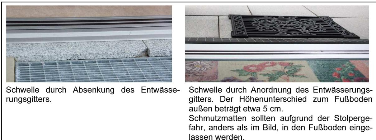
Schwelle durch Absenkung des Entwässerungsgitters.
