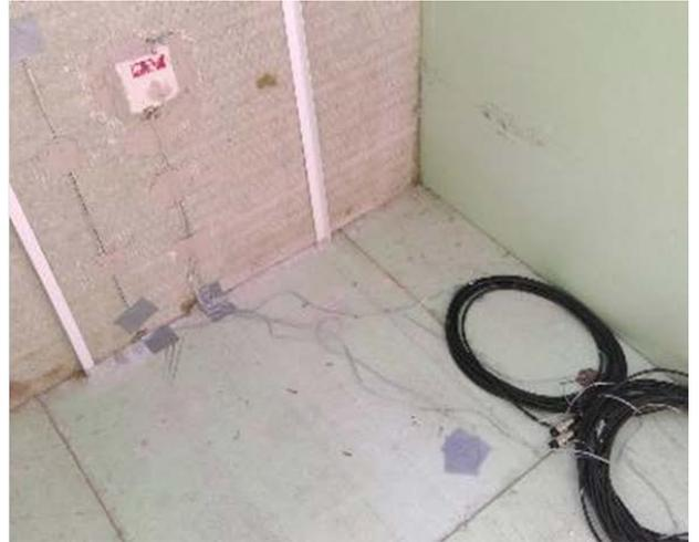
Abbildung 63: Einbau der Sensoren in verschiedenen Putzschichten vorab im Block
