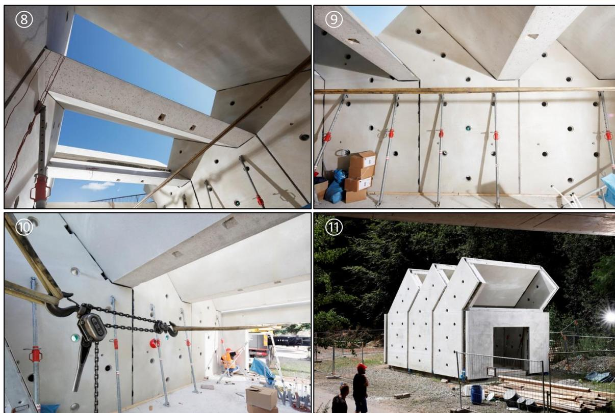
Abbildung 63: ① Stellen der ersten Außenwand, ② Heben der zweiten Außenwand, ③ Verbindung zwischen erster und zweiter Außenwand, ④ Aufbringen des Dachelements, ⑤ Verbinden den der Dachelemente mit den Außenwänden, ⑥ Stellen und Verbinden von Außenwänden, ⑦ Blick vom Innenraum durch die Fensteröffnungen, ⑧/⑨/⑩ Innenansicht, ⑪ Endzustand der Montagearbeiten
