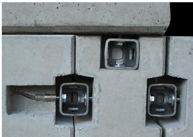
Abbildung 15: Spannschlossverbindungen [5]
