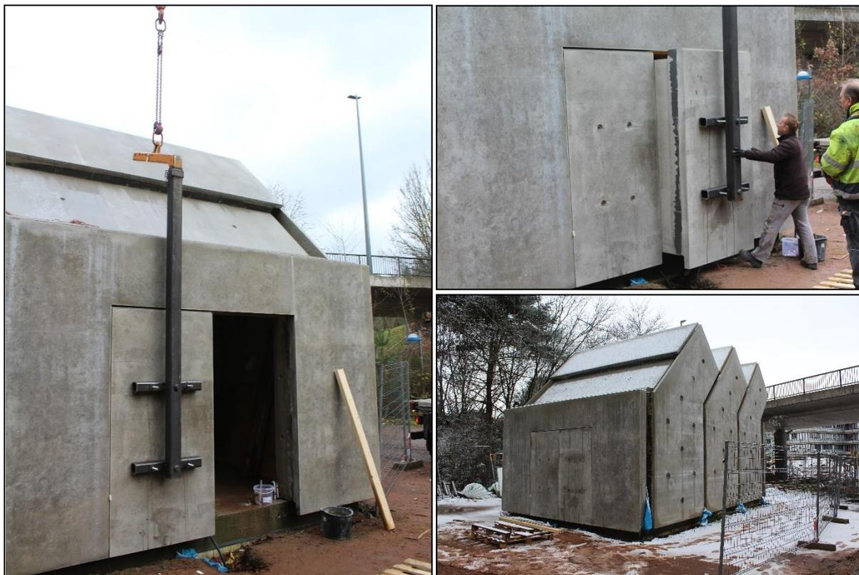
Abbildung 64: ① Einsetzen austauschbare Wand links, ② Einsetzen austauschbare Wand rechts, ③ Außenansicht Großdemonstrator mit Blick auf austauschbare Wandelemente
