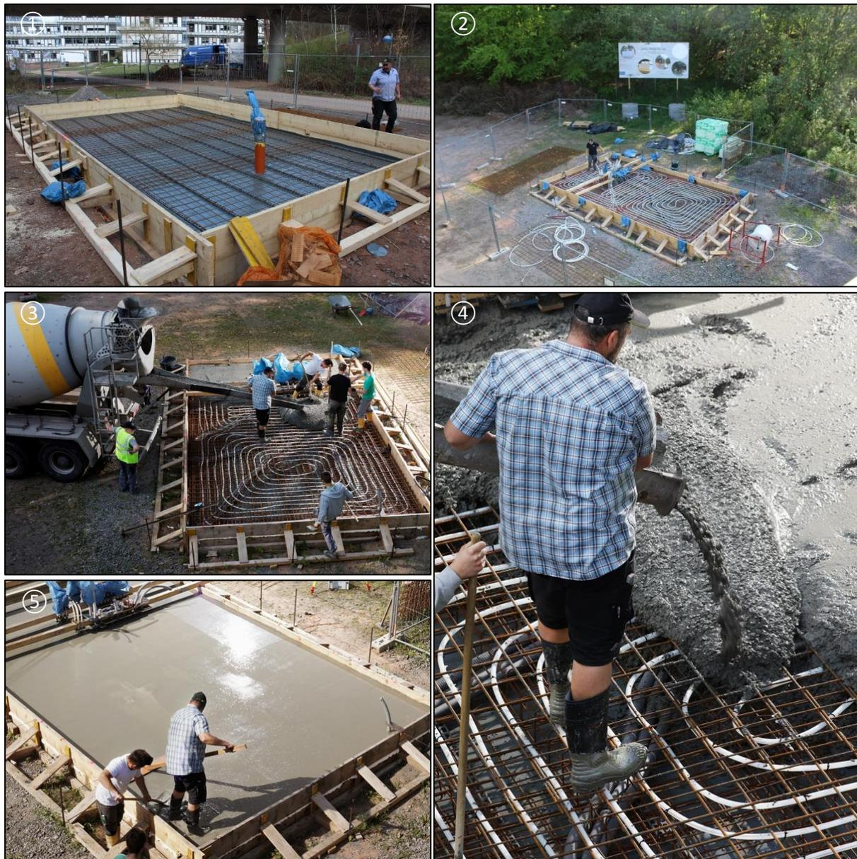
Abbildung 61: ① Schalung und Bewehrung der Bodenplatten, ② Thermische Aktivierung der Bodenplatte, ③/④ Betonage der Bodenplatte, ⑤ Abziehen der Bodenplatte
