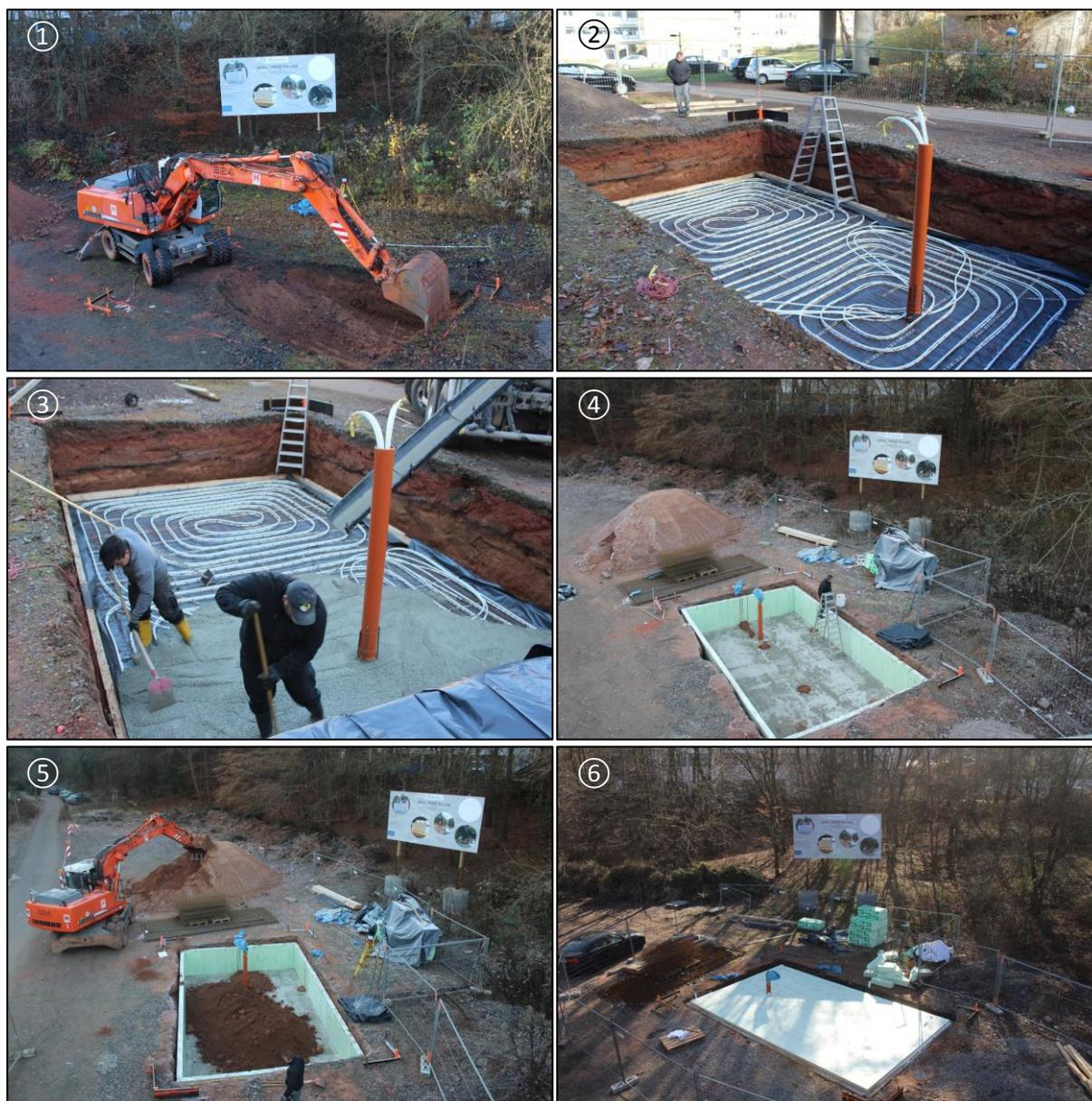
Abbildung 60: ① Spatenstich Smallhouse IV, ② Thermische Aktivierung des Erdreichspeichers, ③ Betonage der Wärmetauscherplatte des Erdreichspeichers, ④ Vertikale Dämmung des Erdreichspeichers, ⑤ Verfüllen des Erdreichspeichers, ⑥ Horizontale Dämmung
