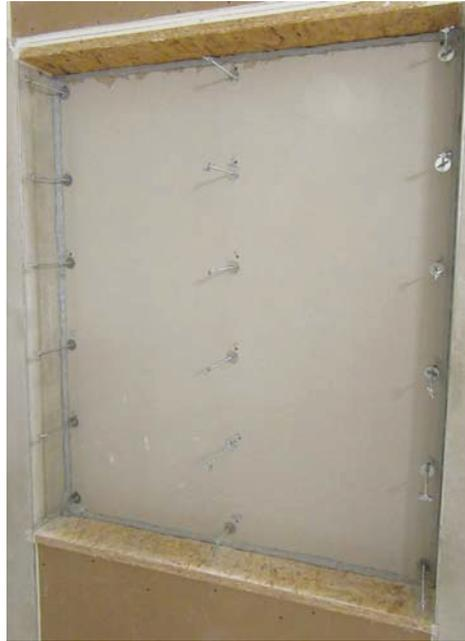
**Abb. 15:** Rückseite einer Ständerwand mit Gewindestäben, Unterlegscheiben und Kontermuttern zur Befestigung des WDVS. Um Undichtigkeiten innerhalb der Wand zu vermeiden, wurden die Muttern im Empfangsraum – zumindest bei Wänden mit hoher Schalldämmung – sicherheitshalber zusätzlich mit Terostat IX abgedichtet.
