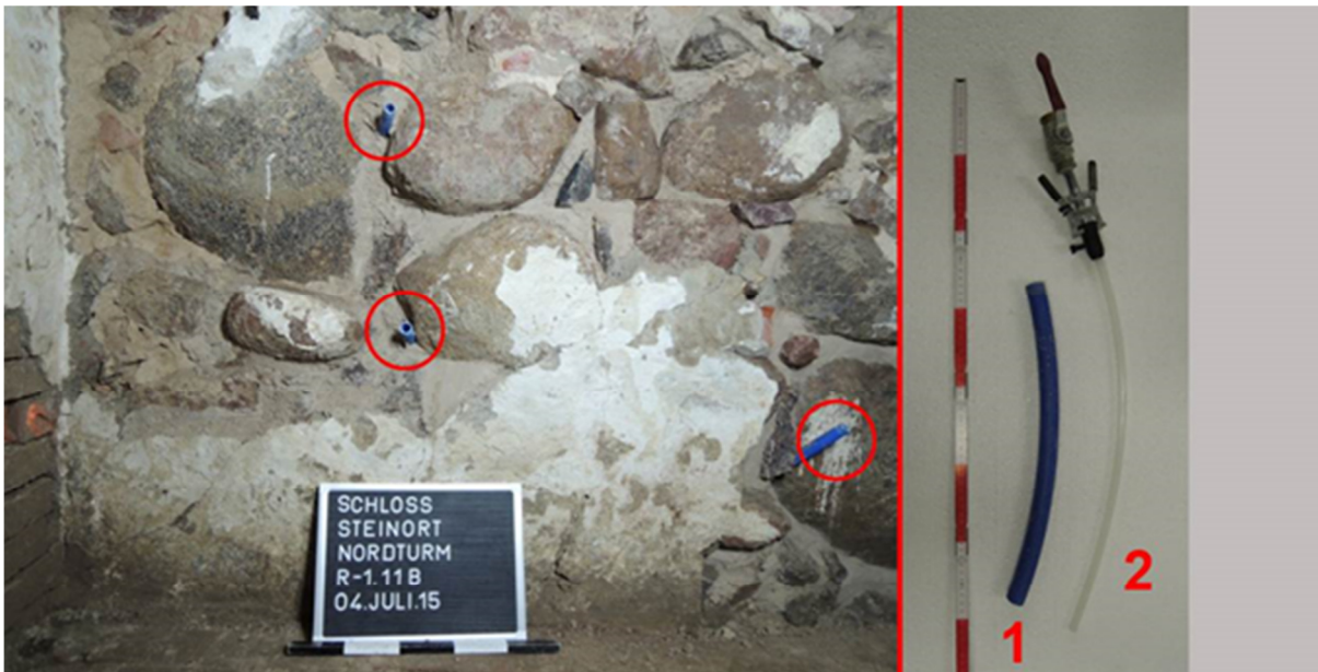
Bild 99 Links die mit Kalkmörtel verfugte Kellerwand aus Lesesteinen, mit den blauen Schläuchen (in den roten Kreisen), rechts die blauen Schläuche (1) und der dünnere Injektionsschlauch mit Schnellkupplungszange von DESOI (2)
