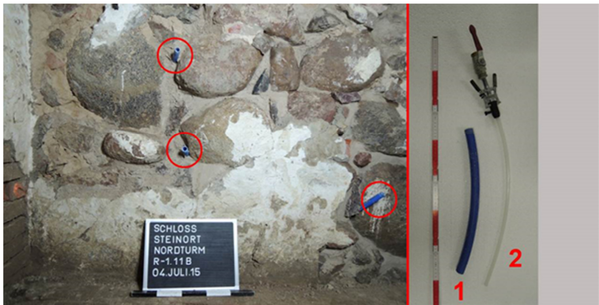
Bild 100 Links die mit Kalkmörtel verfugte Kellerwand aus Lesesteinen, mit den blauen Schläuchen (in den roten Kreisen), rechts die blauen Schläuche (1) und der dünnere Injektionsschlauch mit Schnellkupplungszange von DESOI (2)
