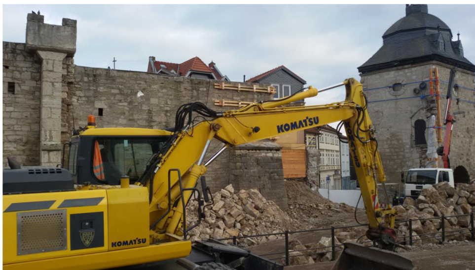
Bild 1 Rückbau der Stadtmauer Mühlhausen im Bereich Frauentor 2018
