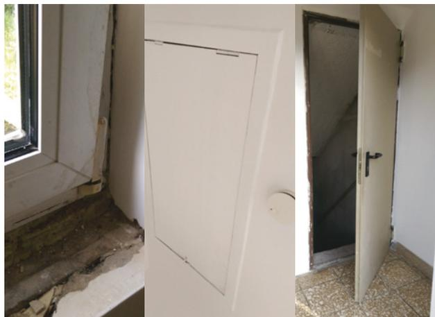
Die Türen von der beheizten zur unbeheizten Zone weisen unzureichende Dämmeigenschaften auf und sind nicht abgedichtet. Schwachpunkte sind vor allem die Kellertüren sowie die Dachbodenklappen. Die Fenster sind nicht abgedichtet. Teilweise fehlen die Fensterbretter. Dies führt zu einer mehrfachen Unterbrechung der Luftdichtheitsebene. Die Folge sind Wärmeverluste und das Risiko von Feuchteintritt. Es droht die Gefahr von Tauwasserausfall und Schimmelpilzbildung.
