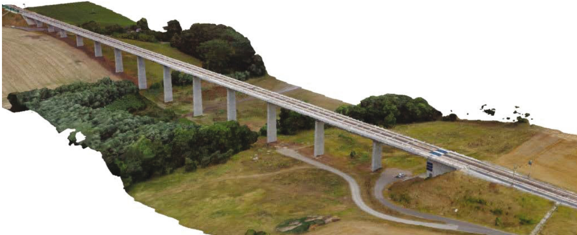
Abbildung 12: Erzeugtes 3D-Modell (grob) der Scherkondetalbrücke mit unmittelbar angrenzendem Gelände
