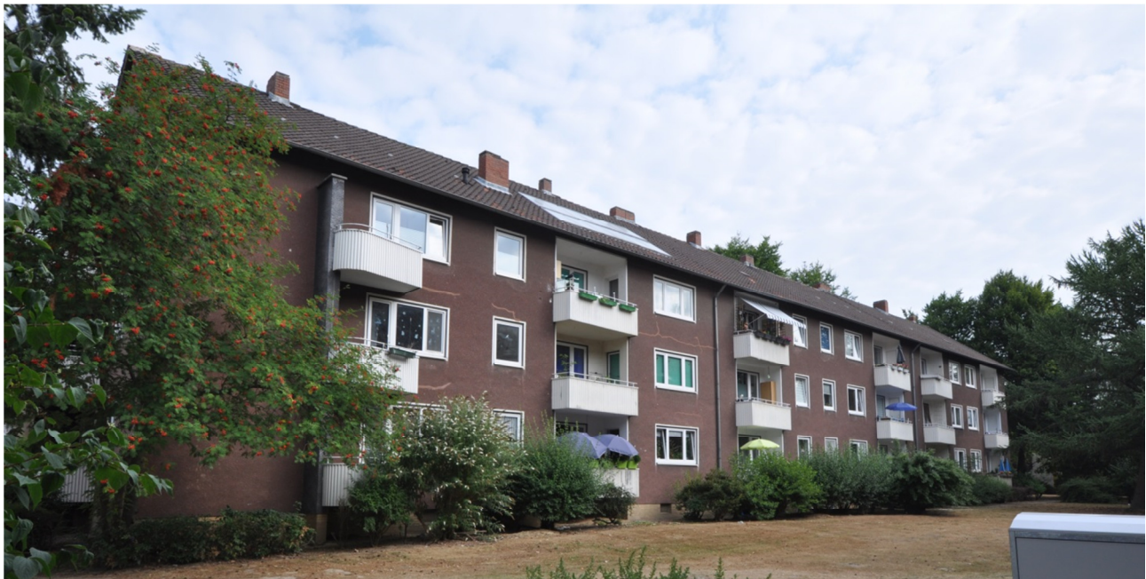
Abbildung 47 Bild der Hauseingänge des thermographisch untersuchten Bestandsgebäudes in Braunschweig
