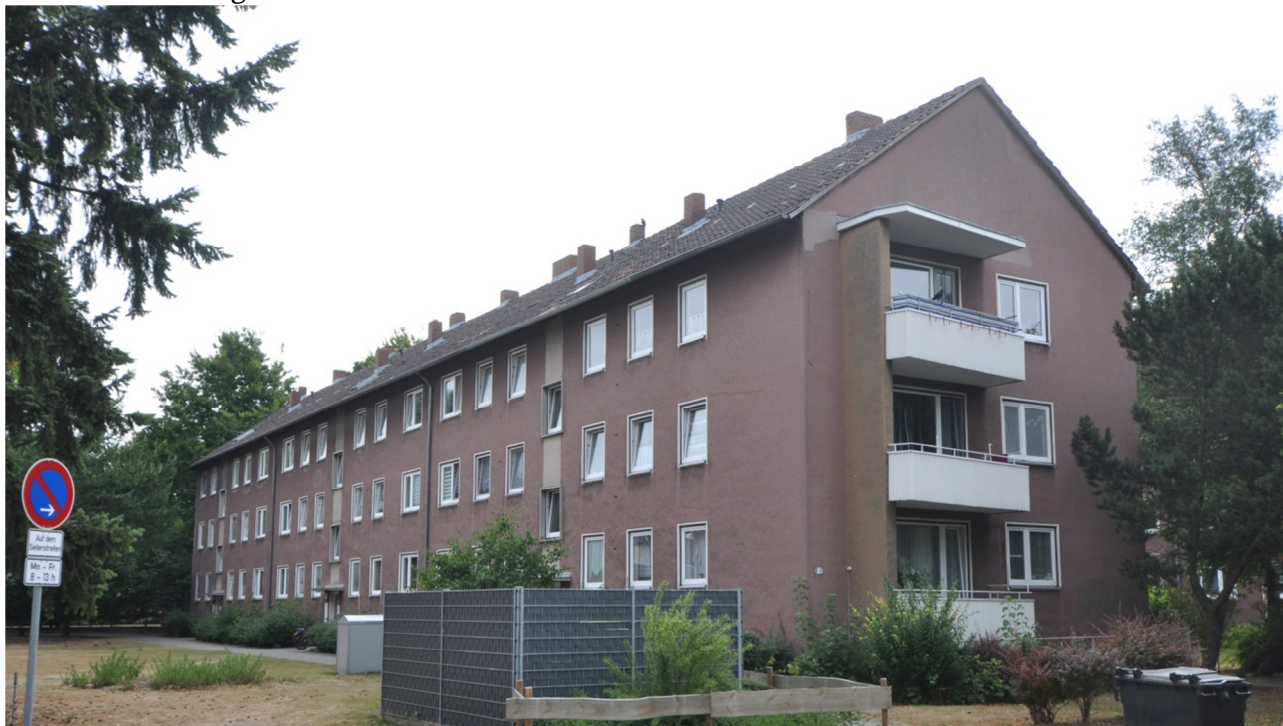
Abbildung 45 Bild der Hauseingänge des thermographisch untersuchten Bestandsgebäudes in Braunschweig
