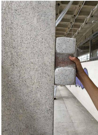
Abb. 10: Mustererstellung der Betonrestaurierung
