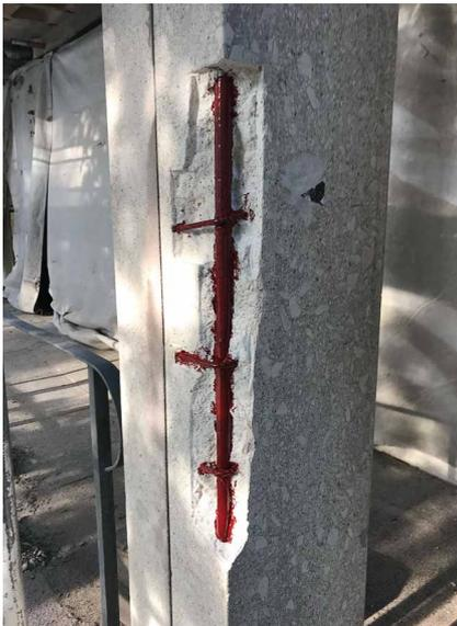
Abb. 9: Bewehrung mit neuem Korrosionsschutz
