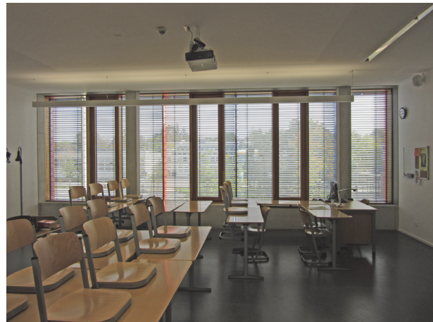
Bild 3 Beispiele für die Fenstertechnik von modernen bzw. modernisierten Klassenräumen: links – ein schmaler Flügel in der hinteren Ecke, sonst große Festverglasungen; rechts – drei schmale Flügel, alle auf Höhe der Tische und somit eingeschränkt nutzbar
