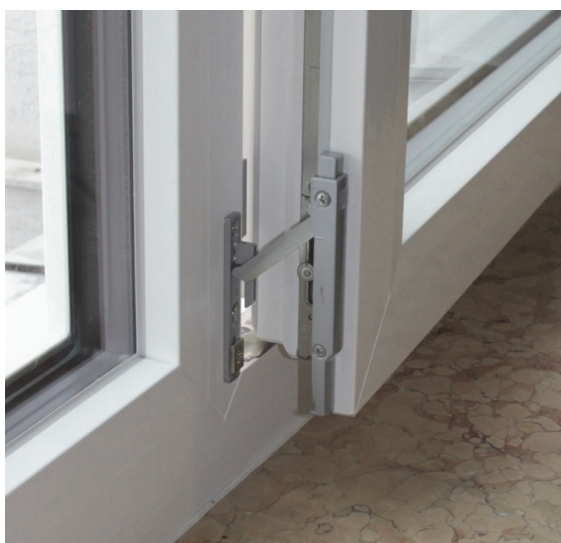
Bild 7 Dreh-Öffnen wird zunächst durch die Verriegelung begrenzt, kann dann manuell freigegeben werden
