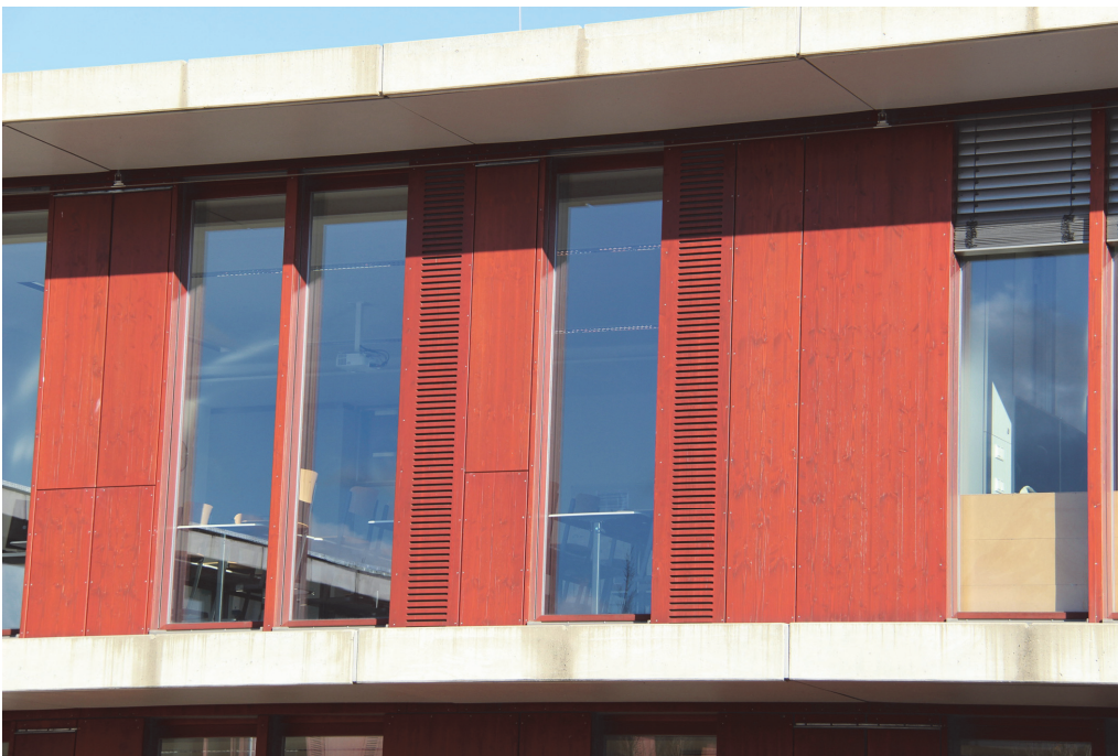
Bild 13 Beispiel einer Schulfassade, bei der Lüftung und Fenstertechnik in separaten Funktionselementen umgesetzt sind. Das Vordach reduziert im Sommer die direkte Einstrahlung, Raffstores ermöglichen variable Nutzung oder Abschirmung von Tageslicht (Staatliche Realschule Obertraubling, Dömges Architekten AG).
