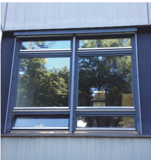
Bild 1 Typische Fensterteilungen in Schulgebäuden aus den 1960er und 70er Jahren
