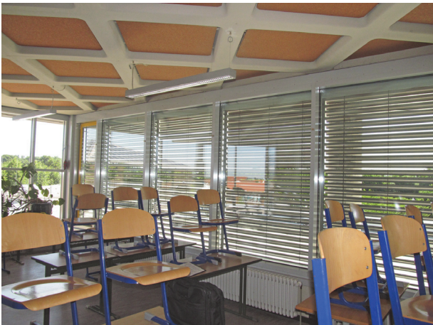
Bild 3 Beispiele für die Fenstertechnik von modernen bzw. modernisierten Klassenräumen: links – ein schmaler Flügel in der hinteren Ecke, sonst große Festverglasungen; rechts – drei schmale Flügel, alle auf Höhe der Tische und somit eingeschränkt nutzbar
