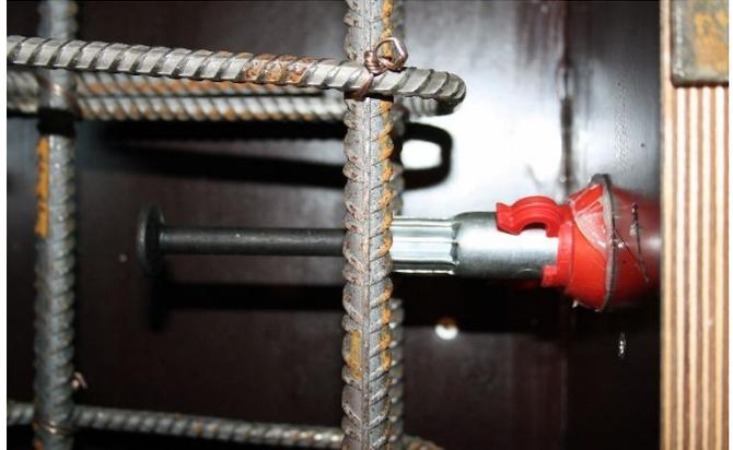
Bild 200. RC-Balken 1, Schalungsdetail: Kompaktanker
