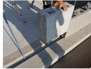
*Bild 285. Bild links: Schlaufe welche in Bild Mitte befestigt wird um dann Bild rechts: den Stein aufzustellen*
