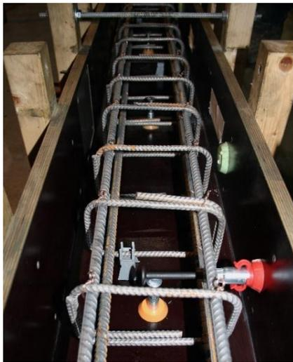
Bild 216. Bewehrung, Verbindungstechnik, RC-Attika 2
