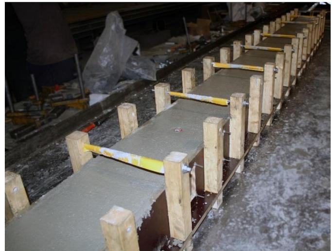
Bild 217. RC-Attika 2 nach Betonlage
