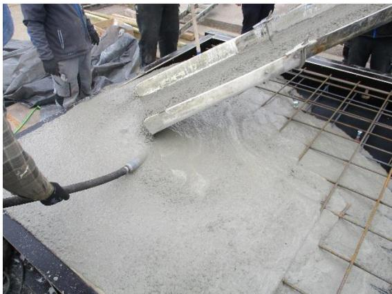
*Bild 130. RC-Bodenplatten, Rütteln mit-*
