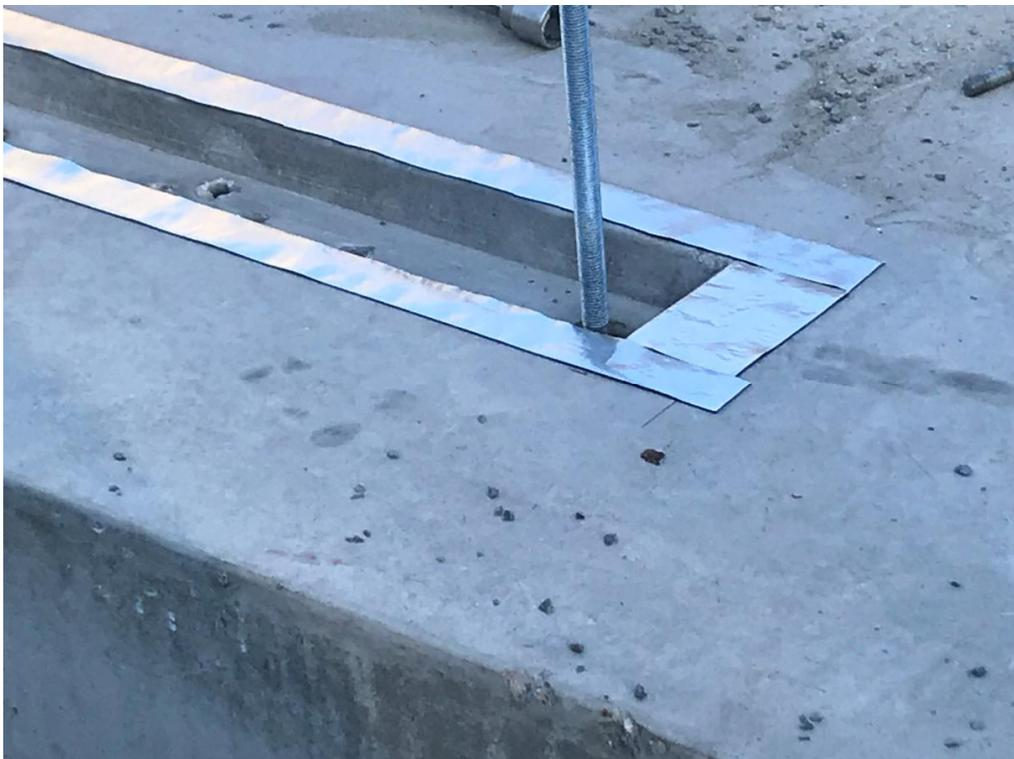
*Bild 261. Abdichtung gegen aufsteigende Feuchtigkeit*
