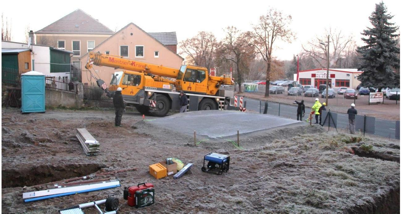
Bild 258. *Planum mit abgezogener Feinkieschicht vor dem Verlegen der Bodenplatte*
