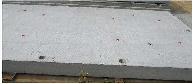
Bild 155. RC-Deckenplatte 1, Glätten, Bild 156. RC-Deckenplatte 1, Ausschalen
