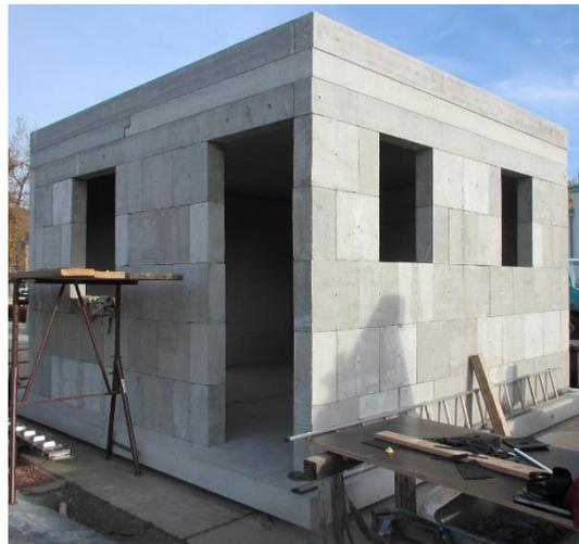
*Bild 289. fertig montierte RC-Wohneinheit*
