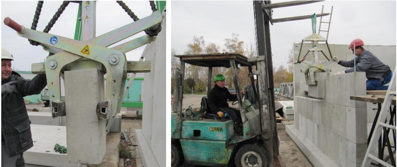
*Bild 290. Demontage eines RC-Betonsteines mit der Winkелеlementzange*
