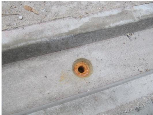
*Bild 291. Korrosion der Gewindebefestigungen*
