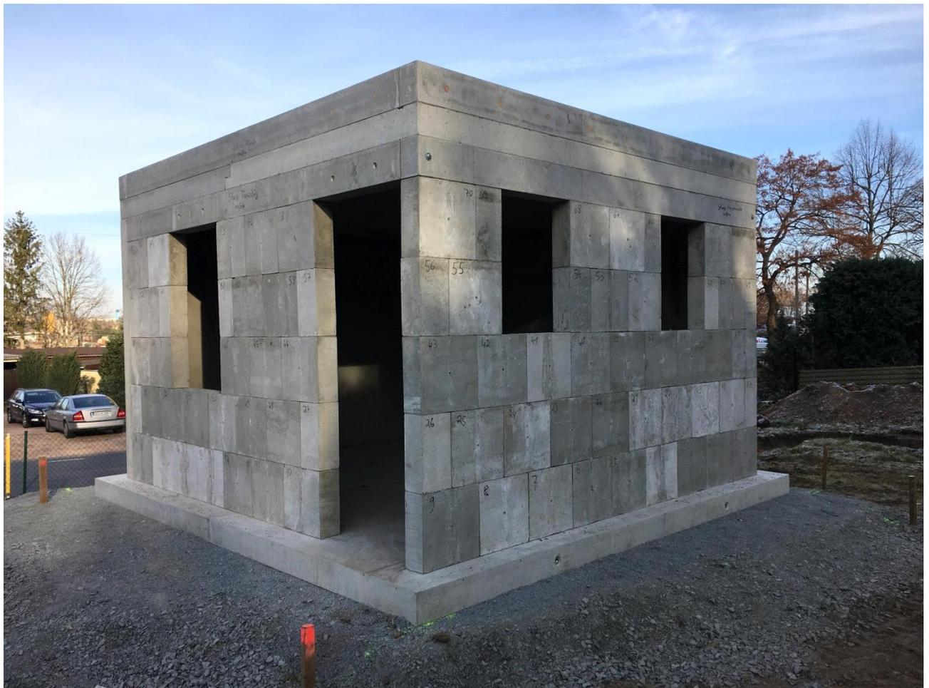
Bild 263. *Fertige Remontage des Rohbaus der RC-Wohneinheit in Meißen*
