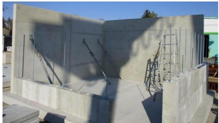
*Bild 238. Schritt 7, RC-Bild 239. Schritt 7, RC-Betonsteine Aufmauern
