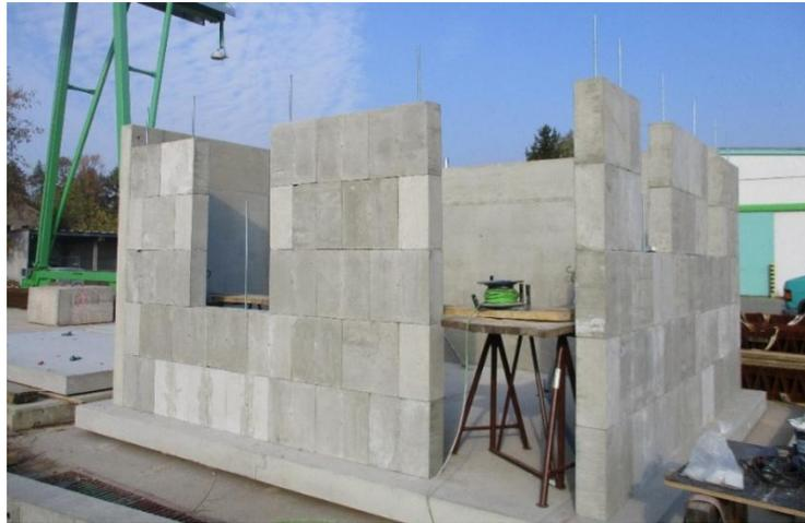
*Bild 240. Schritt 8, nächste Bild 241. Schritt 8, nächste Reihen der RC-Betonsteine /Modell*
