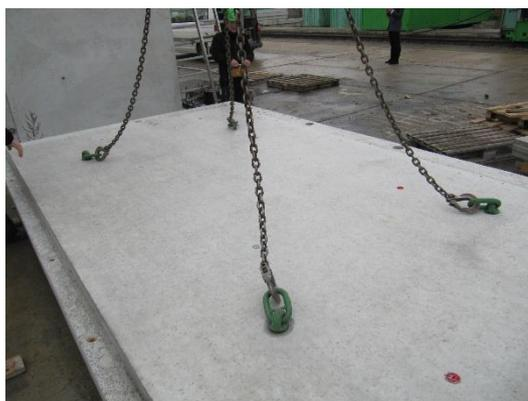
*Bild 283. Bild links: Anschlagwirbel Bild rechts: angeschlagene Ketten an Anschlagwirbel welche mit Bauteil verbunden sind*
