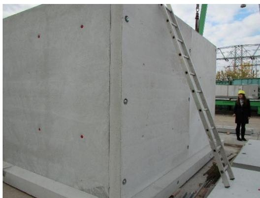
*Bild 284. Aufbau Bodenplatte sowie Wände; einsetzen der Gewindestangen für die Verankerung*
