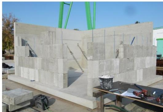
*Bild 286. Montage und Aufstellen der RC-Vollsteine mit einer zusätzliche Verankerung mittels Gewindestangen*
