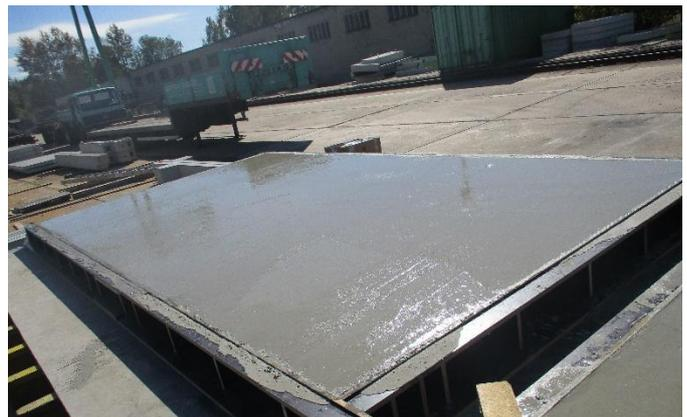
*Bild 131. RC-Bodenplatten, Glätten der Ober-*
