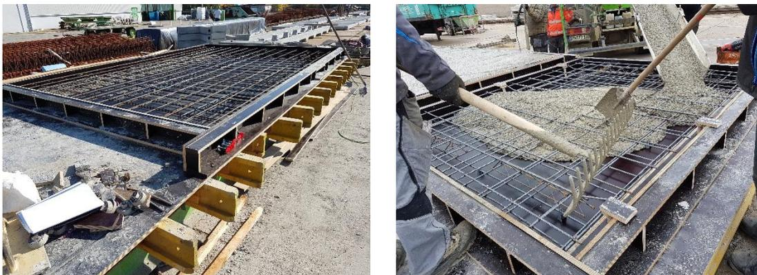
*Bild 280. Bild links: Vorbereitete Schalung im Außenbereich der Fa. M&L Bild, rechts: Verarbeiten des Betons*
