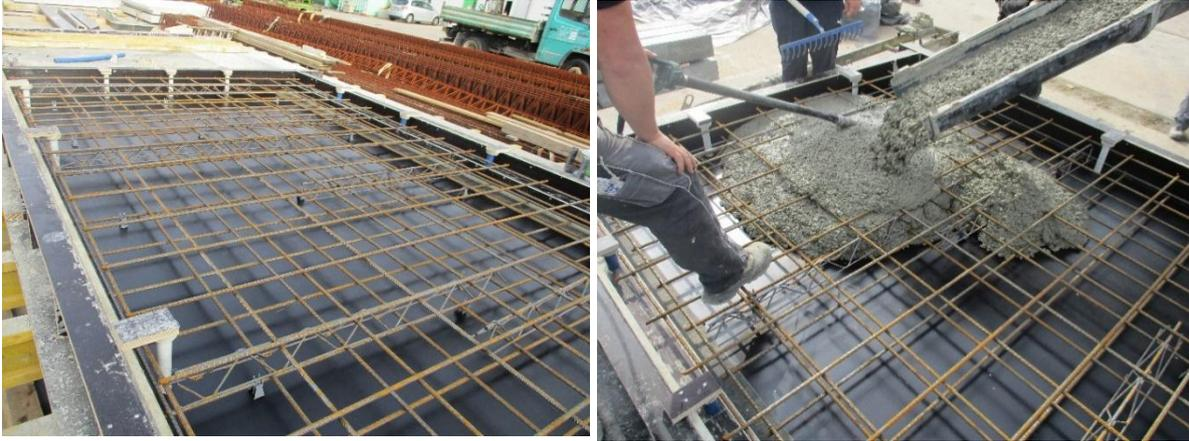
*Bild 159. RC-Deckenplatte 2, Schalung, Bild 160. RC-Deckenplatte 2, Betonage
