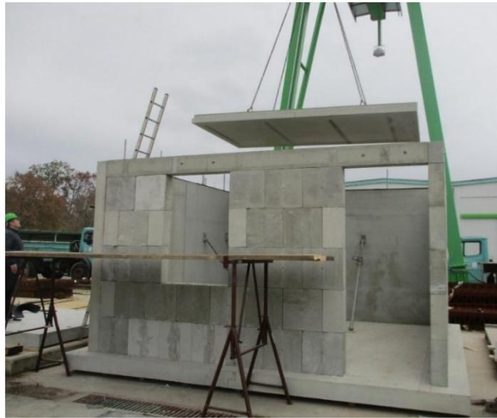
*Bild 244. Schritt 10, Deckenplatten/Modell*
