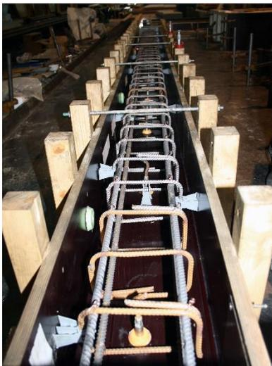
Bild 220. Bewehrungskorb und Verbindungstechnik, RC-Attika 3
