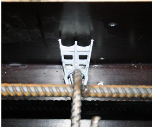
Bild 199. RC-Balken 1, Schalungsdetail: Abstandhalter
