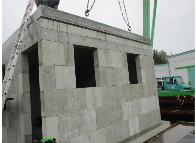
*Bild 248. Schritt 12, Attiken/Modell      RC-Bild 249. Schritt 12, Aufsetzen der RC-Attiken*
