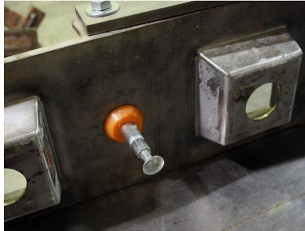
*Bild 165. Verwendete Nagelteller mit Schraubenanker*
