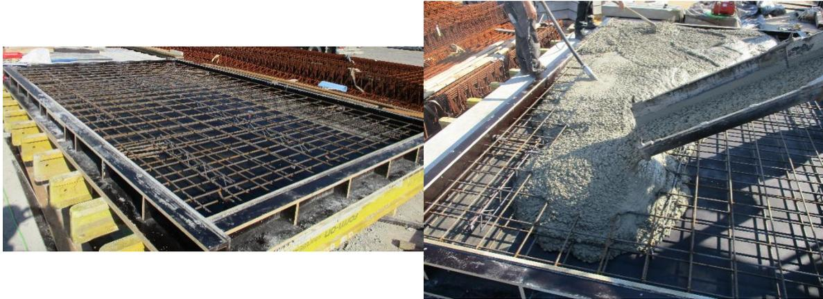
*Bild 136. RC-Wand 1, Schalung, Verbin-Bild 137. RC-Wand 1, Betonlage, Verdichtungs-
