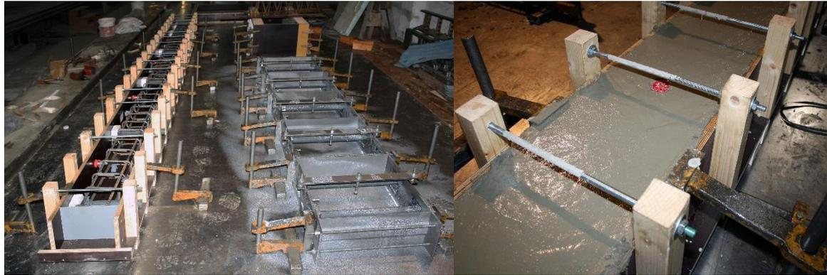
*Bild 203. Vorbereitete Schalungen für RC-Bild 204. RC-Balken nach Betonieren und Glätten*
