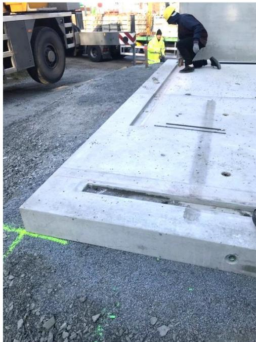
Bild 259. *Bodenplatte auf dem Planum mit abgezogener Feinkieschicht*
