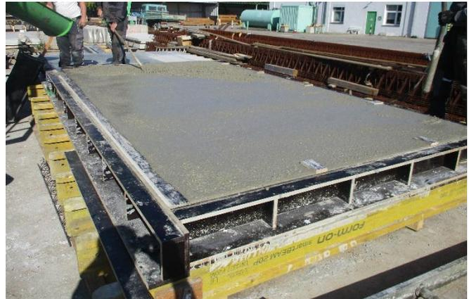
*Bild 153. RC-Deckenplatte 1, Schalung, Bild 154. RC-Deckenplatte 1, Betonage Verbindungstechnik*
