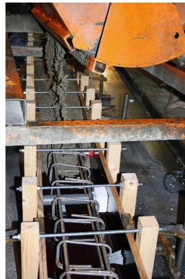
Bild 202. RC-Balken, Einfüllen des RC-Betons
