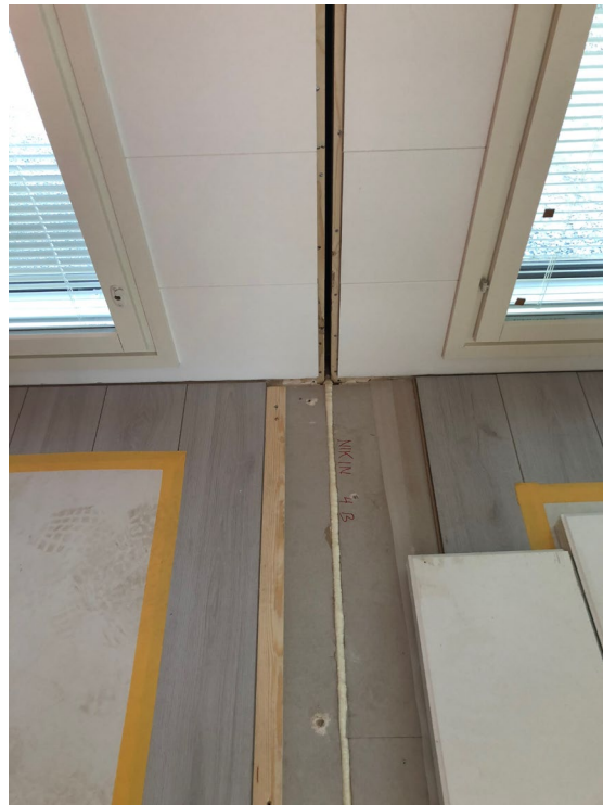
Abb. 31: Produktionsschritte Rohbau, Innenausbau und Fassade; Einbau-Möblierung; Fugenausbildung vor Ort (Fotos: eigene Aufnahmen)
