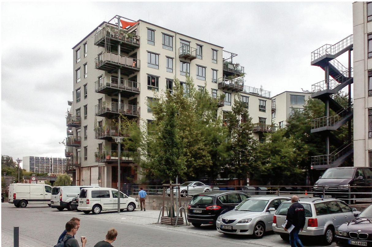
Abb. 3.1.1: Spreefeld, Blick vom Wilhelmine-Gemberg-Weg auf Haus 1
