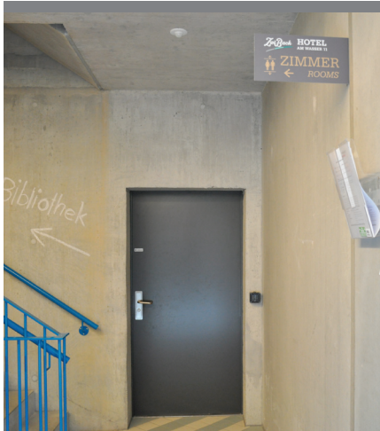
Abb. 3.5.11: Treppenaufgang in Haus 6
