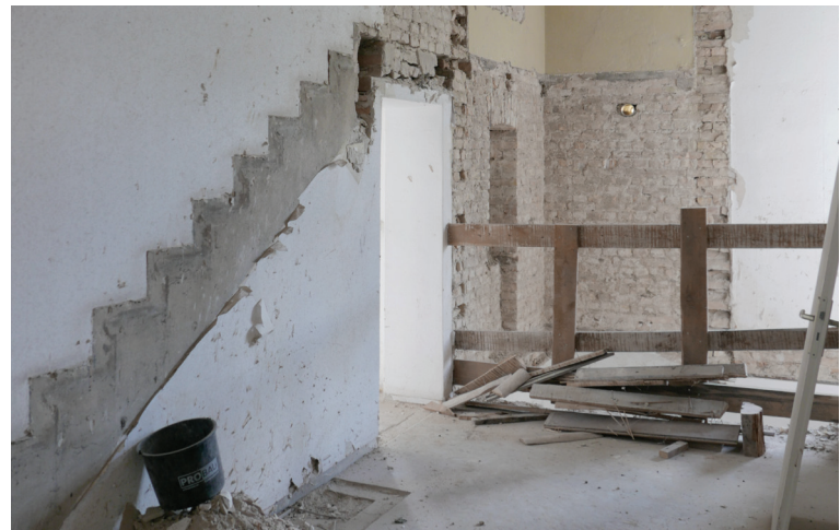
Abb. 3.8.18: Weitreichende Umbauarbeiten für ein neues Treppenhaus
