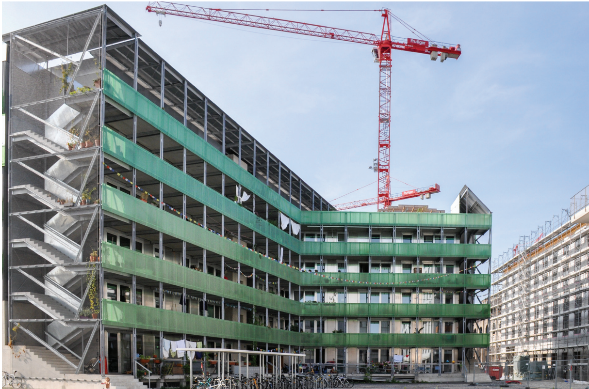
Abb. 3.7.1: StadtErle , Hof-Fassade mit sichtbarer Außenschließung
