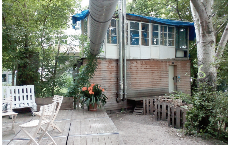
Abb. 3.1.12: Heizhaus und Gartenterrasse
