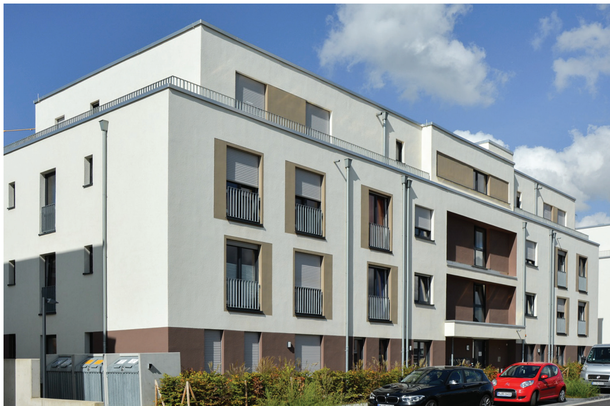
Abb. 3.6.1: Blick auf das Haus von der Straße aus, Foto: Christiane Strohecker
