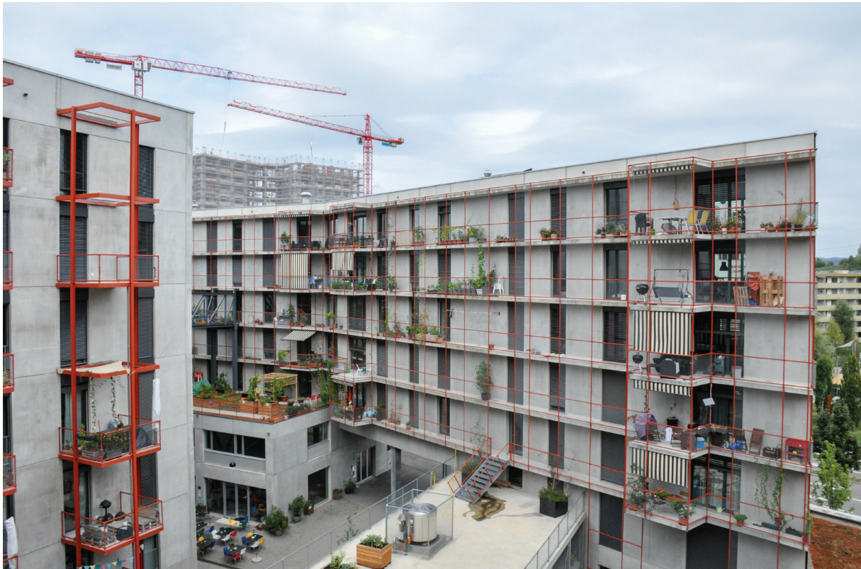
Abb. 3.5.1: Blick von Haus 6 auf Haus 5 (links) und Haus 4
