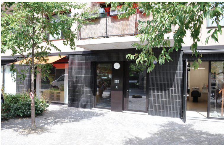
Abb. 3.3.9: Hauseingang und Gewerbeeingänge im EG
