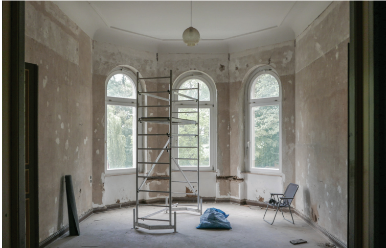
Abb. 3.8.13: Zweizimmer-Individualbereich im Rohbau
