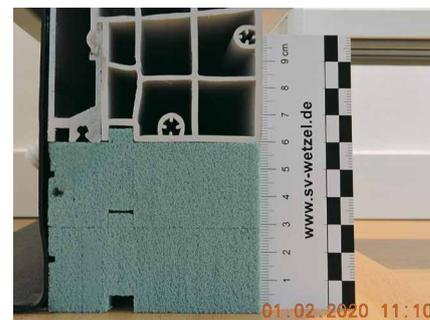
**Abb. 32:** Rahmen-Ergänzungsprofil aus hochfestem Schaumkunststoff
