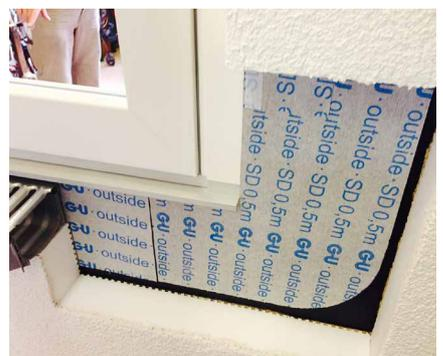
Abb. 26 und 27: Muster eines unteren und seitlichen Abdichtungsanschlusses an die Bodenschwelle GU-thermostep 204 (© 2015 Gretsch Unitas GmbH)
