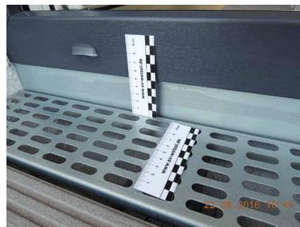
**Abb. 2 und 3:** Zur Abbildung 1 passendes Praxisbeispiel mit einer 50 mm über Oberfläche Belag/Lochblech reichenden FLK-Abdichtung, die durch das davor angeordnete Blech geschützt ist
