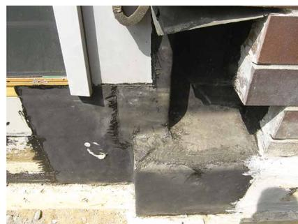
**Abb. 15:** Nachrüstung eines zunächst vergessenen Anschlusses zwischen der hinter der Vorsatzschale angeordneten Sockelabdichtung und der Abdichtung an die Pfosten-Riegel-Fassade (Holz-Aluminium-Konstruktion) [11]
