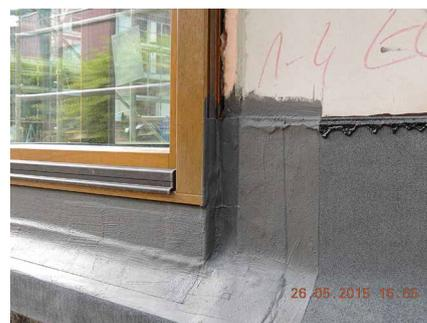
**Abb. 16:** An der Stirnfläche des seitlichen Rahmens hochgeführte FLK-Abdichtung bei einer zweischaligen Wand mit noch nicht erstellter Vorsatzschale
