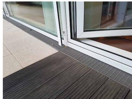
**Abb. 8:** Zur Abbildung 7 passendes Praxisbeispiel, bei der die Abdichtung  $\leq 20$  mm über Oberfläche Belag/Gitterrost endet, allerdings nicht in Kombination mit einer barrierefreien Türschwelle, sondern mit einem umlaufenden Türrahmen
