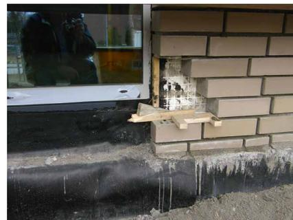
**Abb. 14:** Aussparung in der Vorsatzschale in dem Bereich, in dem der Bauwerksabdichter (!) die Abdichtungslücke zwischen der Sockelabdichtung und der Fensterabdichtung schließt [11]
