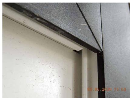
Abb. 22 und 23: Tür- und Fensterelement eines Balkons mit ca. 20 mm großen Rücksprüngen in dem (unteren) Bereich in dem der Bauwerksabdichter seine FLK-Abdichtung applizieren sollte
