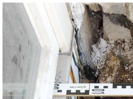
Abb. 24 und 25: Über die gesamte Breite des Türelements verlaufendes und vorderseitig überstehendes Schwellenprofil
