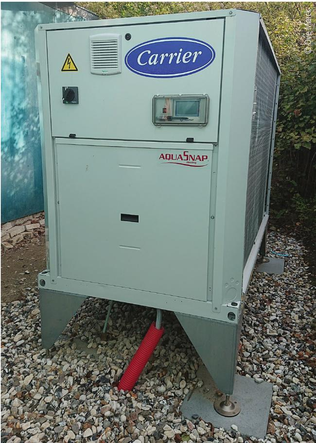
Die Luft-Wasser-Wärmepumpe trägt, intelligent gesteuert, wesentlich zum Erfolg des Sanierungskonzepts bei
