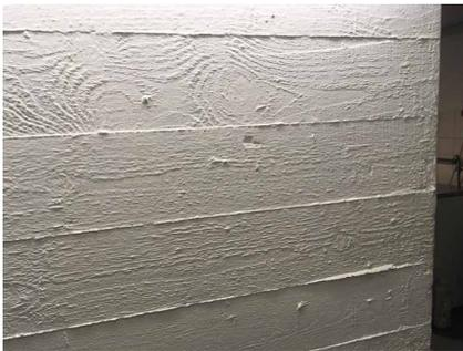
Abb. 6: Die beim Bau brettgeschalte Betonoberfläche im Inneren des Gebäudes wurde später weiß beschichtet
