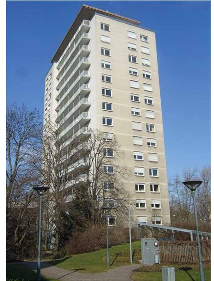
Abb. 4: Das Studentenwohnheim Max-Kade-Haus in Stuttgart wurde 1953 aus Bauschuttbeton errichtet. Die Fassade und alle sonstigen Betonbauteile des Hochhauses sind bis heute im Originalzustand erhalten.
