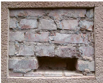
Abb. 3: Auch Flächen unter harten Zementputzen können substanzschonend freigelegt werden
