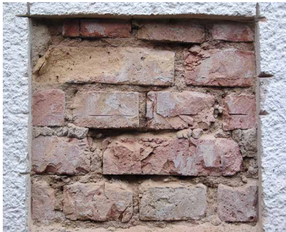
Abb. 2: Unsachgemäß freigelegte, beschädigte Mauersteine sind für Festigkeitsuntersuchungen unbrauchbar
