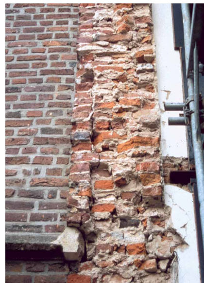
Abb. 1: Risse parallel zur Wandoberfläche werden oft erst im Schadensfall erkannt
