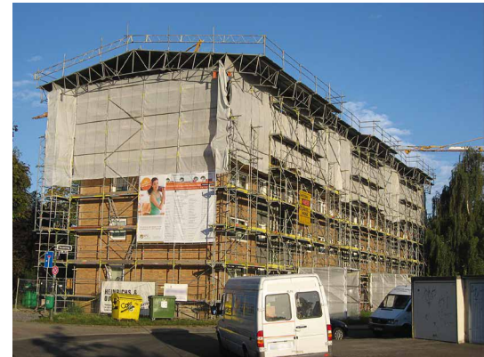
Abb. 4: Bei vielen Bauaufgaben können Proben in ausreichender Menge entnommen werden (Szenario A)
