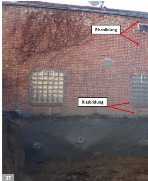
Abb. 07: Rissbildungen an der zur Baugrube orientierten Außenwand des Bestandsgebäudes
