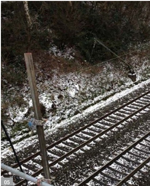
Abb. 05: Umgeknickter Oberleitungsmast
