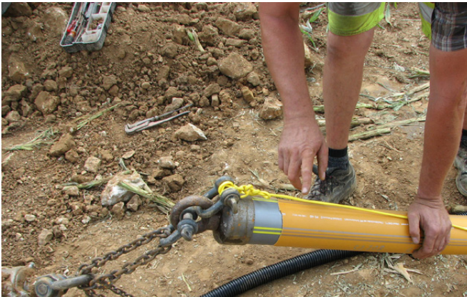
Abb. 02: Anwendung beim Einziehen (HDD-Verfahren) [Quelle: CHASE/NEPTCO]
