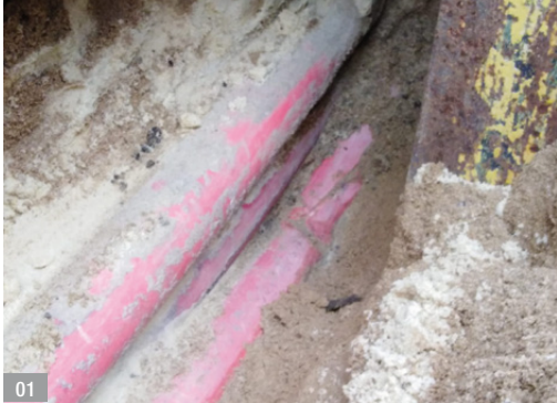
Abb. 01: Blick in den Graben der Suchschachtung mit den erdverlegten Hochspannungskabeln
