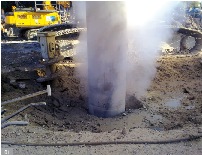
Abb. 01: Aufsteigender Wasserdampf aus einer beschädigten Fernwärmeleitung (Symbolbild)
