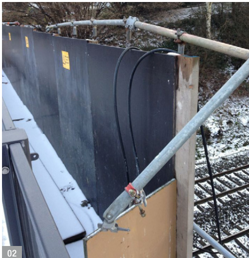
Abb. 02: Traggerüst: Seitliche Absturzsicherung
