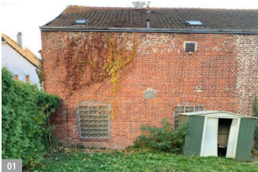
Abb. 01: Blick auf die Nordfassade des Bestandsgebäudes, spätere Grenzwand zum geplanten Neubau
