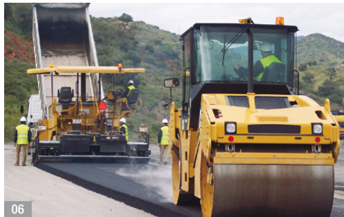
Abb. 06: Walze mit Trimble CCS900 [SITECH]
