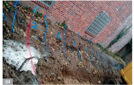
Abb. 04: Farbige markierte Unterfangungsabschnitte
