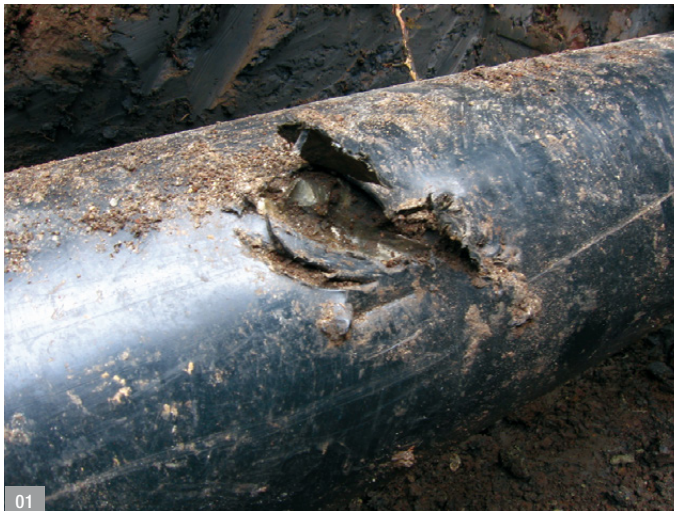
Abb. 01: Bei Tiefbauarbeiten beschädigte Gastransportleitung (Symbolbild)
