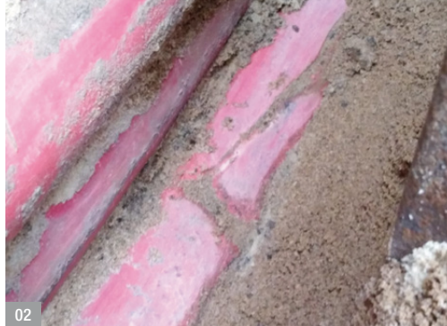
Abb. 02: Beschädigter Kabelmantel eines Hochspannungskabels
