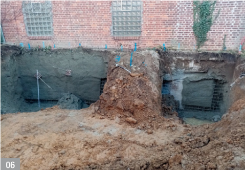
Abb. 06: Blick in die Baugrube auf die noch nicht fertige Unterfangung. Hier ist deutlich zu erkennen, dass die Vorgaben zur Herstellung der Unterfangungsabschnitte nicht eingehalten wurden.
