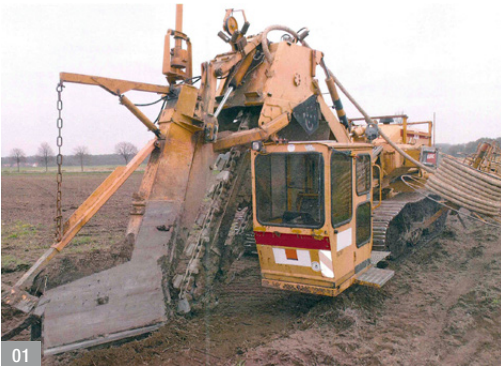
Abb. 01: Dränmaschine auf der zu dränierenden Ackerfläche
