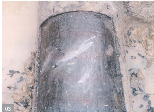
Abb. 03: Beschädigte Gastransportleitung, partiell entfernter Leitungsmantel
