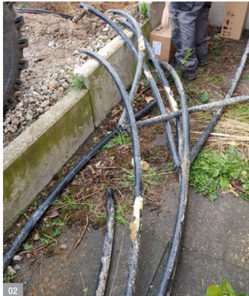
Abb. 02: Erdverlegte Mittelspannungskabel aus der gesuchten Kabeltrasse
