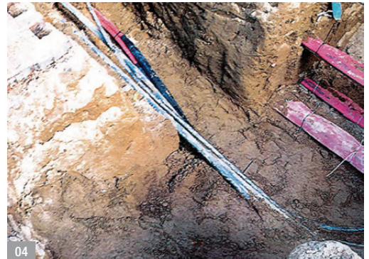
Abb. 04: Reparierte Kabeltrasse, neues Teilstück mit Schumpfmuffe
