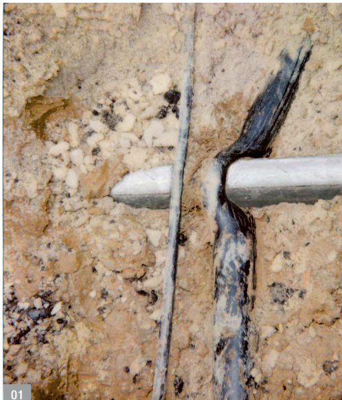
Abb. 01: Durchbohrtes Telekommunikationskabel
