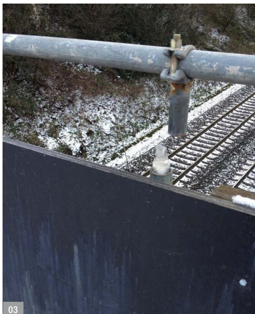
Abb. 03: Eisbildung durch gefrorenes Niederschlagswasser in einer Gerüststange
