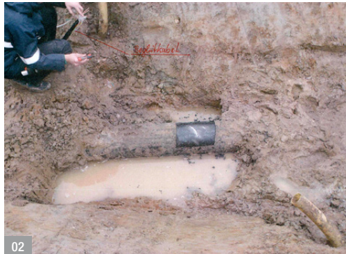
Abb. 02: Gerissenes Begleitkabel und freigelegte Gastransportleitung
