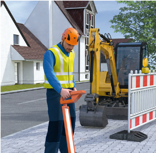
Abb. 03: Lokalisierung von Leitungen mit Kabelortungsgerät [H.ZWEI.S Werbeagentur GmbH]
