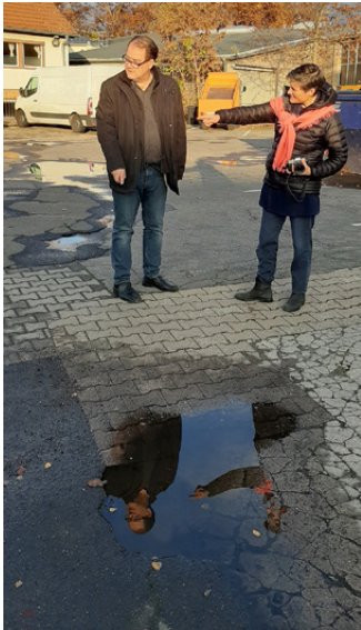
Abb. 04: Unterschiedliche Pflasterarten können Indiz für verlegte Versorgungsleitungen auf privaten Arealnetzen sein. Franziska Wodicka, Diplom-Ingenieurin der Landschaftsarchitektur, zeigt dem Vertreter des VST, Jan Syré, ein typisches Beispiel.
