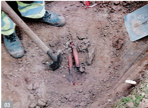
Abb. 03: Durch den elektrischen Kurzschluss verbrannte Kabel(-mäntel)
