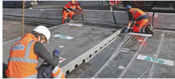
Bild 2 Verlegung eines Betonfertigteillements [1, 2]
