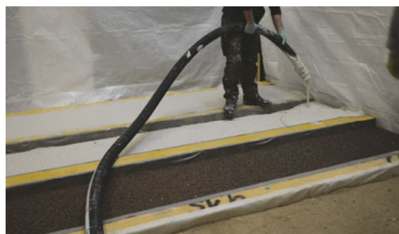
Bild 2 Ausbringen des Schaumgipses im Technikum zur Hohlraumbefüllung in Holzbalkendecken mit unterschiedlichen Einlagematerialien (Quelle: CASEA pGmbH)
