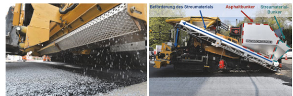
Bild 5 Abstreuerung des photokatalytischen Granulats (links) über den fertigerintegrierten Streuer mit Innovationsbunker (rechts) [1]
