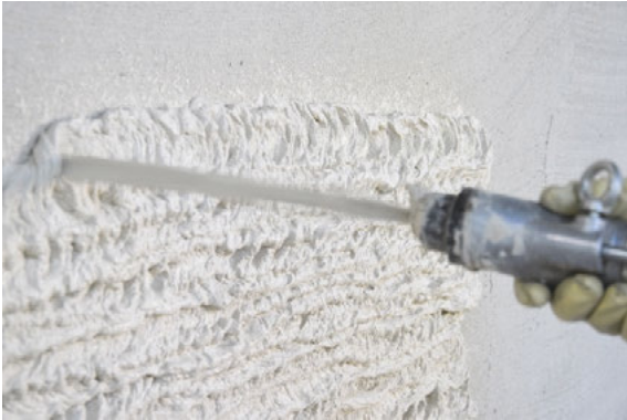
Bild 2 Aufspritzen der ersten Lage der neu entwickelten Dämmung [Quelle: Franken Maxit Mauermörtel GmbH]
