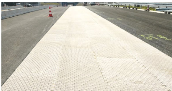
Bild 2 Fertiggestellte Teststrecke mit Texturschicht [1]
