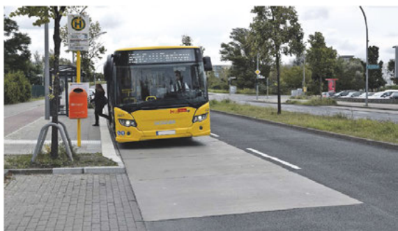
Bild 1 Erneuerte Bushaltestelle mit Fertigteilenelementen aus Beton [1]
