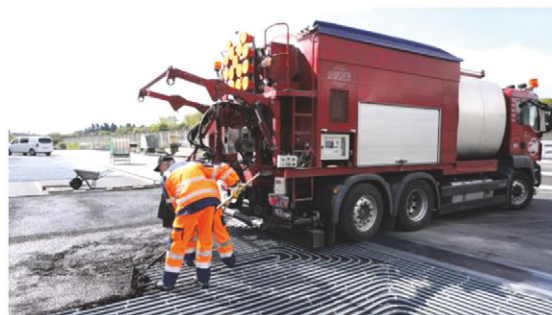
Bild 5 Einbau des Asphalts mit Rohrsystem [4]
