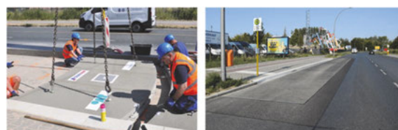
Bild 5 Verlegung der Fertigteile (links) und Aufnahme der fertigen Bushaltestelle (rechts) [1]
