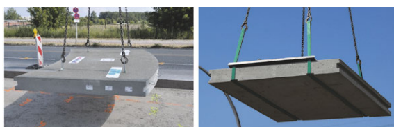
Bild 4 Einbau der Betonfertigteile mit Transportankern (links) bzw. Hochleistungsgurten (rechts) [1]
