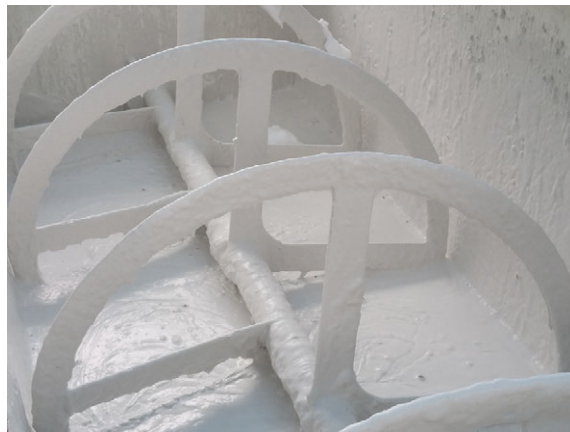
Bild 4 Frisch angemischter Gipsschaummörtel in der speziell entwickelten Mischkammer (Quelle: CASEA GmbH)
