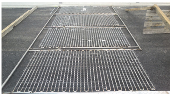
Bild 3 Eingebauter Kollektor mit Gittersystem [2]
