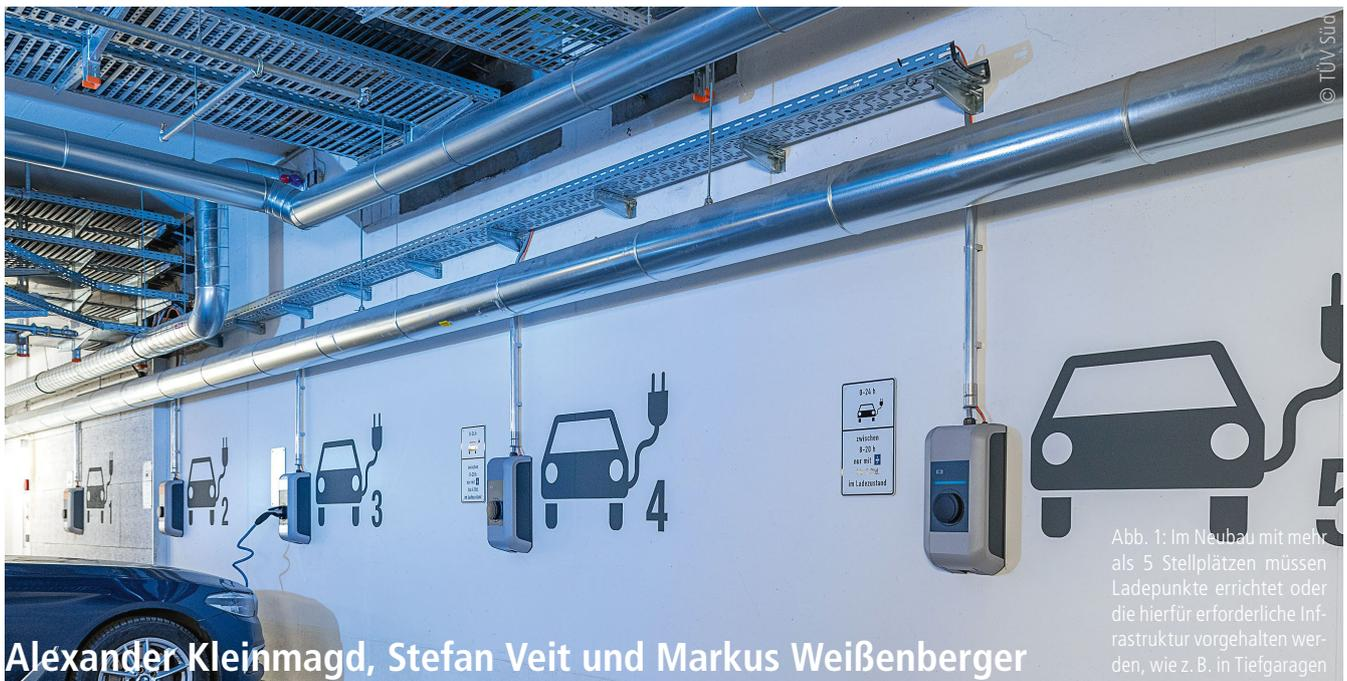
Abb. 1: Im Neubau mit mehr als 5 Stellplätzen müssen Ladepunkte errichtet oder die hierfür erforderliche Infrastruktur vorgehalten werden, wie z. B. in Tiefgaragen
