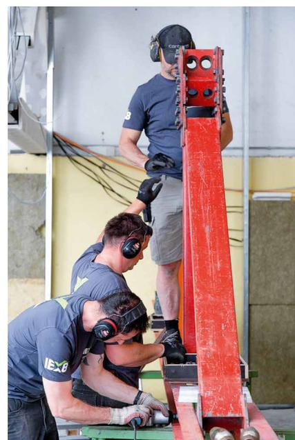
**Abb. 3:** Wenn die Muttern mit einem Schlagschrauber befestigt werden, rattert es laut. Nun ist ein Hörschutz erforderlich. (Foto: Maximilian Johnson/HTWK Leipzig)
