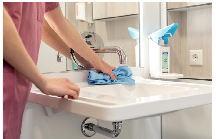
Abb. 7 Reinigung der fugenlosen Aufkantung des Waschtischs im Übergang zur Wand.
