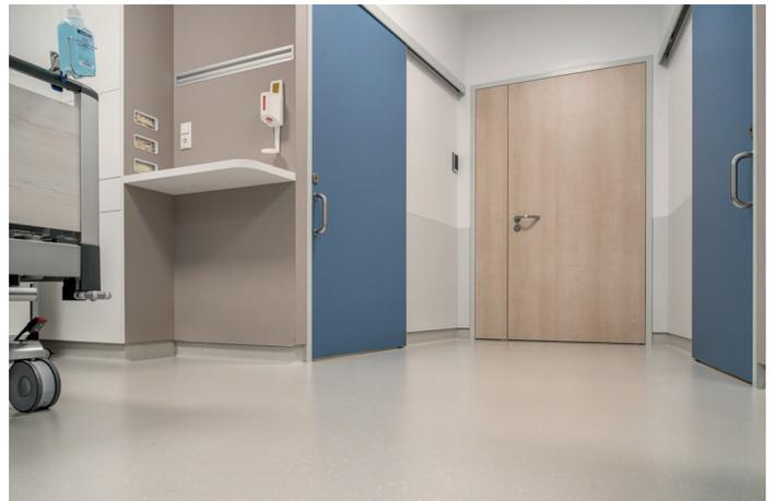
Abb. 10 Der Kautschukboden mit der Hohlkehle reicht bis zum Sockel an der Wand. Dadurch lässt sich der Boden auch in den Ecken einfacher reinigen.
