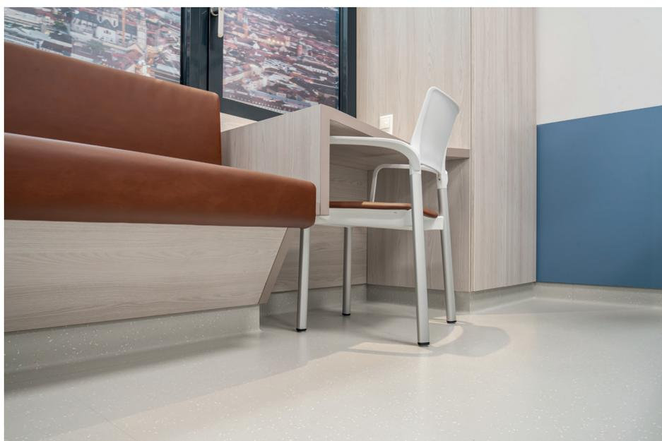
Abb. 18 Sockelbereich mit umlaufender Hohlkehle an allen Bauteilen für optimale Bodenreinigung
