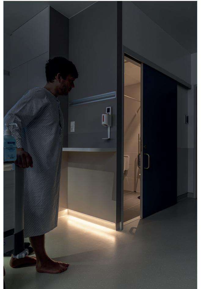
Abb. 13 Ein Bettsensor löst das nächtliche Orientierungslicht aus.
