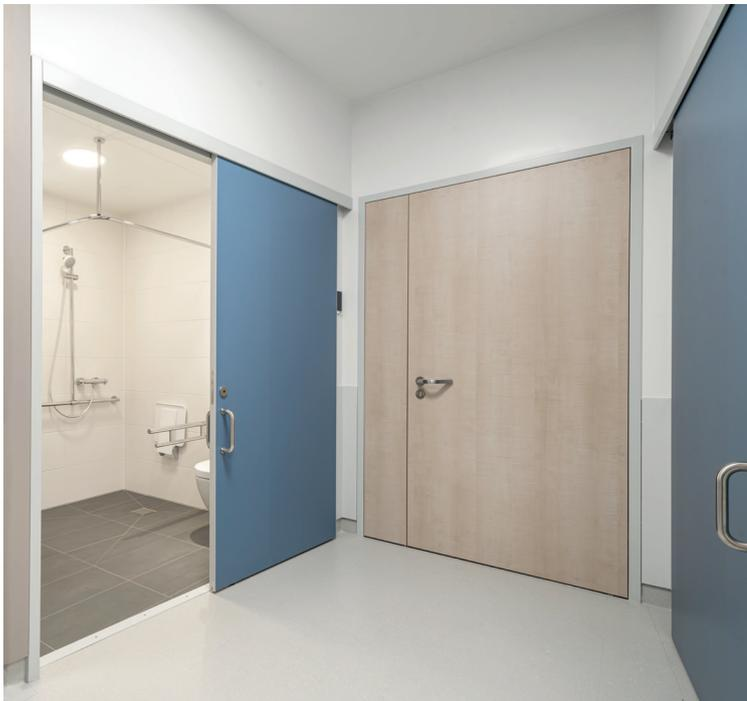
Abb. 12 Einblick in die Nasszelle. Nutzerfreundliche Bedienung, da das Türblatt seitlich vor der Wand verschoben wird.
