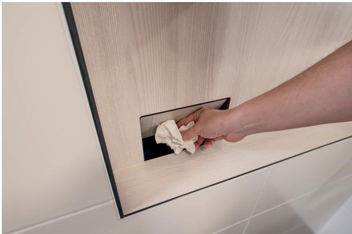
Abb. 9 Die Abwurfklappe des Abfalleimers in der Nasszelle.
