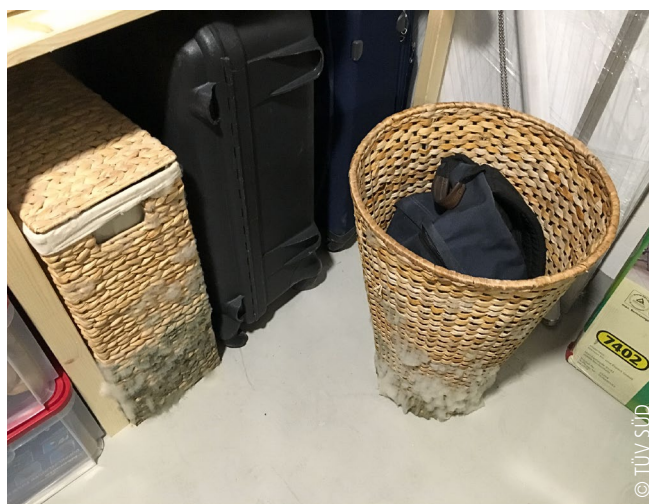
Abb. 1: Schimmelbefall an Körben in einem Lagerkeller. Ursache ist die Schimmelanfälligkeit des Lagerguts und die »kalten Füße« auf dem Estrich in großer Gründungstiefe im 2. Untergeschoss.
