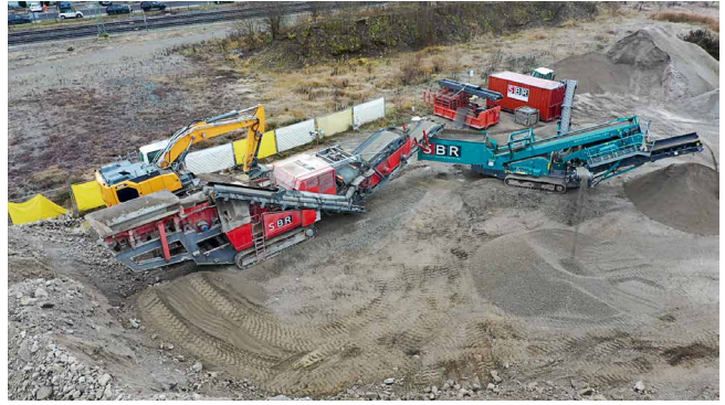
Abb. 7: Aufbereitung des Abbruchmaterials nahe der Baustelle [© Georg Reisch GmbH & Co. KG]
