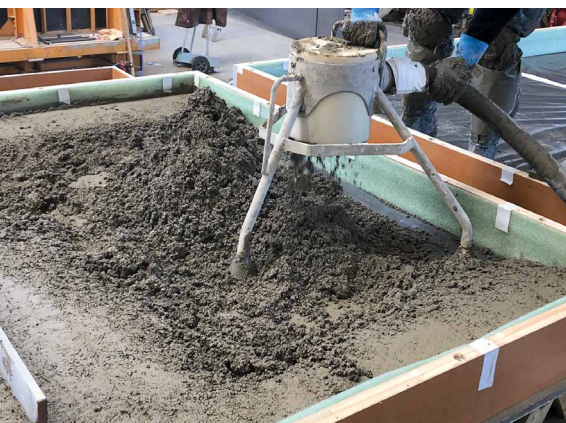
Abb. 9: Während des Pumpens des RC-Estrichs [© Georg Reisch GmbH & Co. KG]
