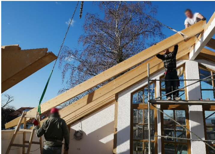
Abbildung 85: Montage der Dachsparren (eigene Darstellung)
