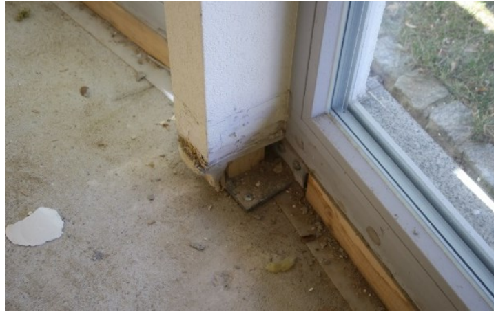
Abbildung 98: Verschraubung Wand/Decke (Foto: SchwörerHaus)
