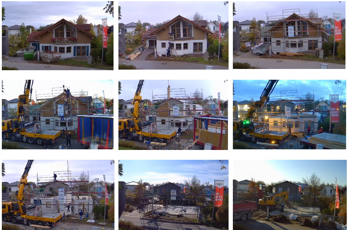
Abbildung 73: Fotografische Dokumentation des Abbaus des SchwörerHouses in Poing (eigene Darstellung)
