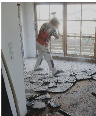
Abbildung 88: Zertrümmern des Gussasphaltestrichs (eigene Darstellung) Abbildung 89: Abbruch der Kellerdecke (eigene Darstellung)
