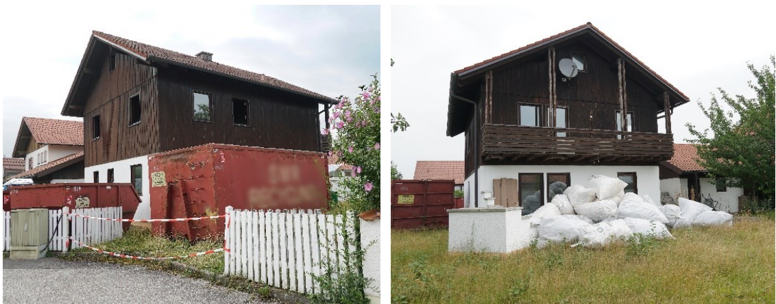
Abbildung 69: Rückbau eines Einfamilienhauses in Holzfertigbauweise (eigene Darstellung)
