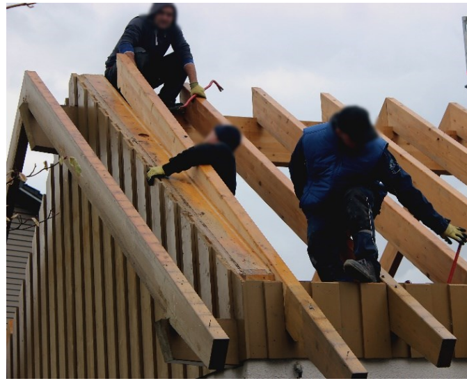
Abbildung 83: Demontage der Dachsparren (eigene Darstellung)
