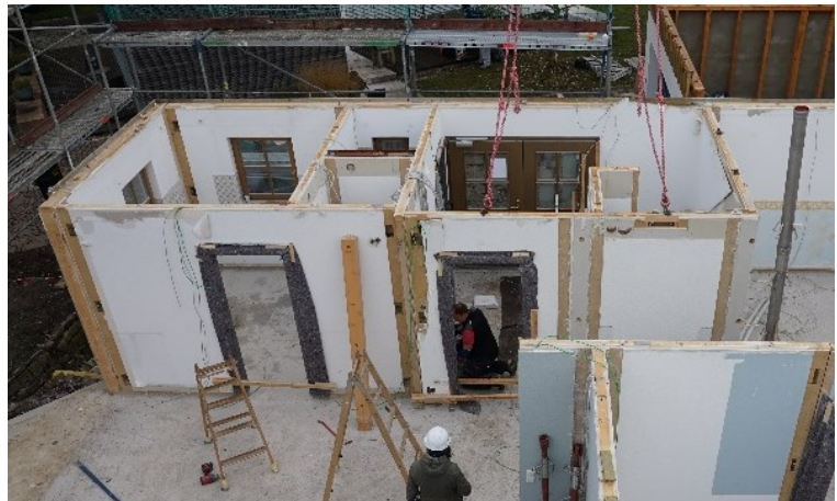
Abbildung 77: Abbau der Wandelemente (eigene Darstellung)
