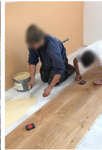
Abbildung 92: Verlegung des Parketts (eigene Darstellung)
