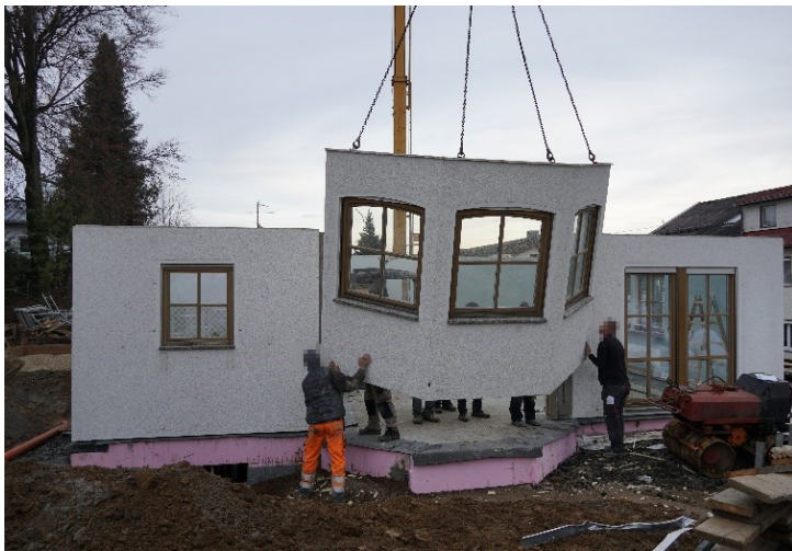
Abbildung 79: Aufbau der Wandelemente (eigene Darstellung)
