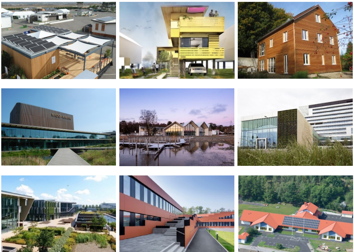
Abbildung 43: C2C inspirierte Gebäude, 1. Reihe v. li. n. re.: Nexushaus, Konzept Flow House, Wohnhaus Familie Eser; 2. Reihe v. li. n. re.: Niederländisches Institut für Ökologie, Green Solution House, Rathaus Venlo; 3. Reihe v. li. n. re.: Park 2020, Verwaltungsgebäude von RAG-Stiftung und RAG Aktiengesellschaft, Backsippan Vorschule (Quellen s. Auflistung Kapitel 4.1)
