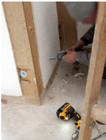
Abbildung 76: Freilegung der Verschraubungen zwischen Wänden (eigene Darstellung)
