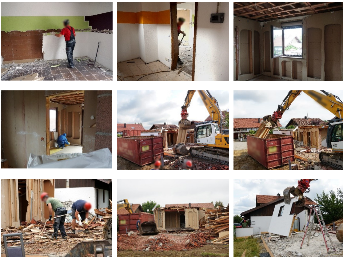
Abbildung 70: Arbeitsschritte beim Rückbau eines Einfamilienhauses in Holzfertigbauweise in Mettenheim (eigene Darstellung)
