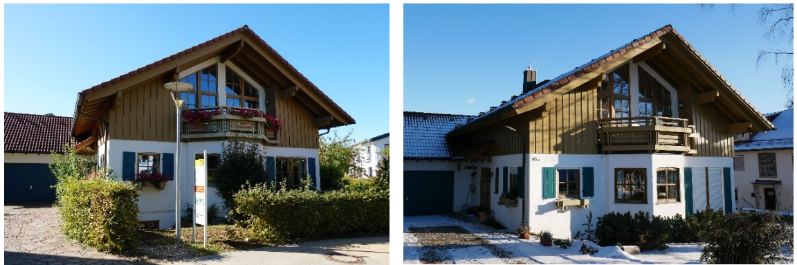
Abbildung 72: Zweifamilienhaus in Holzfertigbauweise vor (links) und nach der Versetzung (rechts) (eigene Darstellung)
