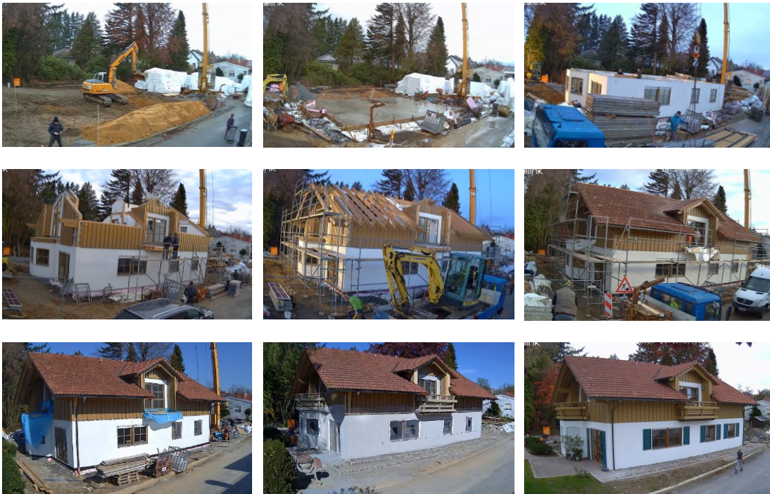
Abbildung 74: Fotografische Dokumentation des Aufbaus des SchwörerHouses in Tittling (eigene Darstellung)
