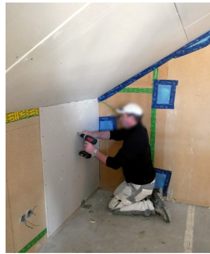
Abbildung 80: Anbringen der Gipskartonverkleidung (eigene Darstellung)
