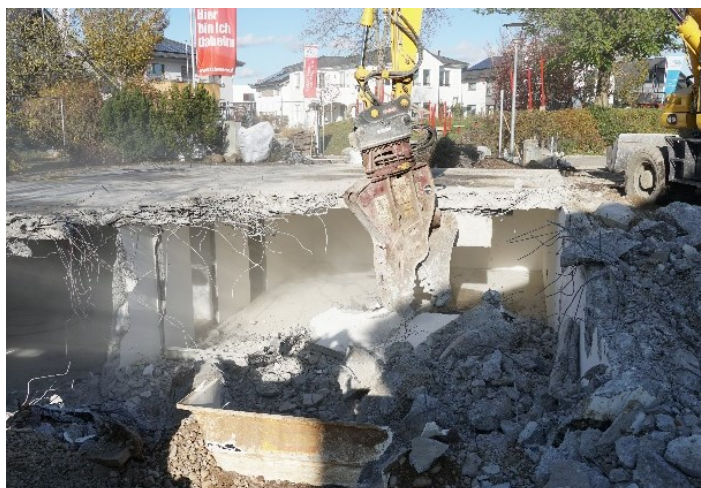
Abbildung 88: Zertrümmern des Gussasphaltestrichs (eigene Darstellung) Abbildung 89: Abbruch der Kellerdecke (eigene Darstellung)
