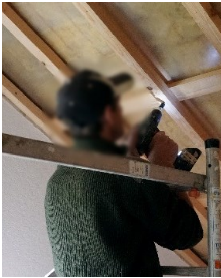
Abbildung 82: Abschrauben der Konterlattung und Lattung (eigene Darstellung)
