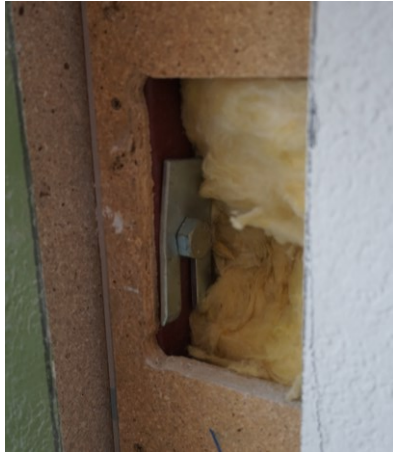
Abbildung 97: Verschraubung Wand/Wand (eigene Darstellung)
